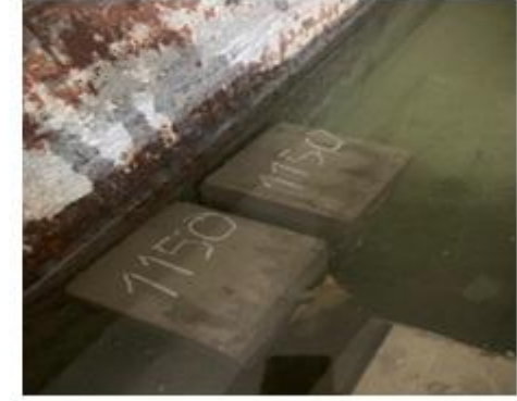
d. Beton kür uygulaması
