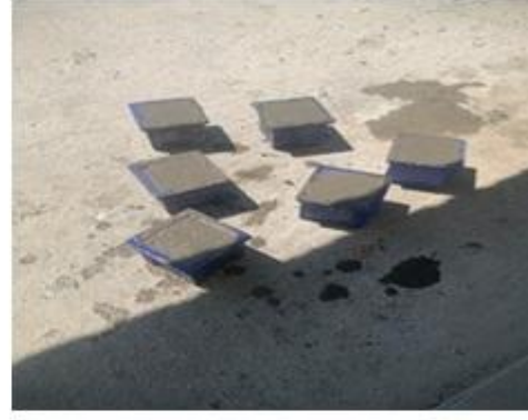
b. Taze beton kalıba alınması
