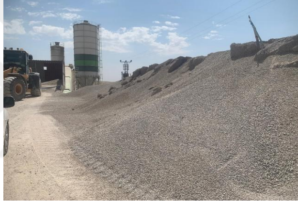
Şekil 2. Agregas stok sahası
