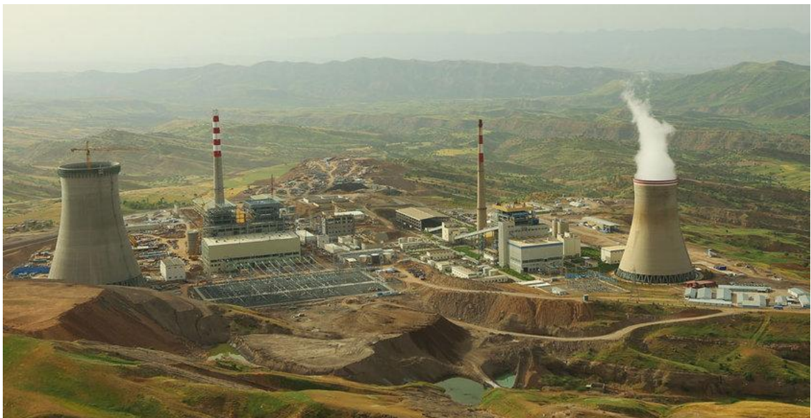
Şekil 8. Silopi termik santali
