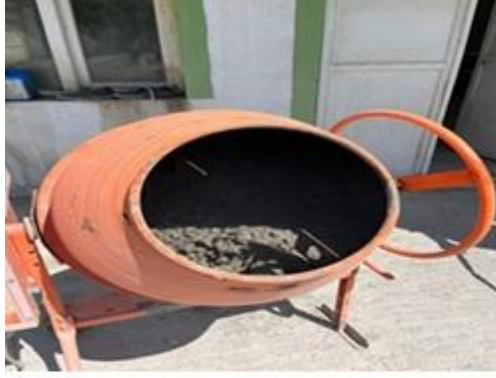
a. Beton malzemelerinin karıştırılması
