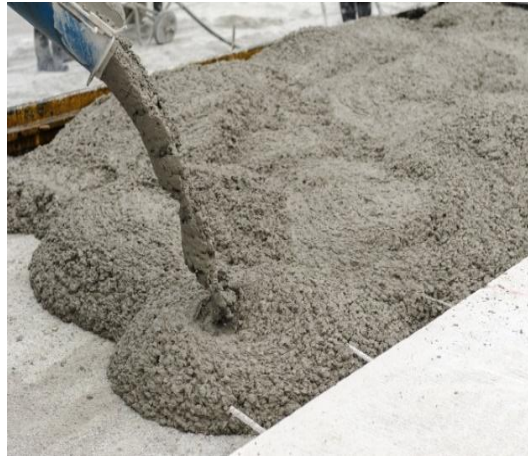
Şekil 1. Beton dökümü
