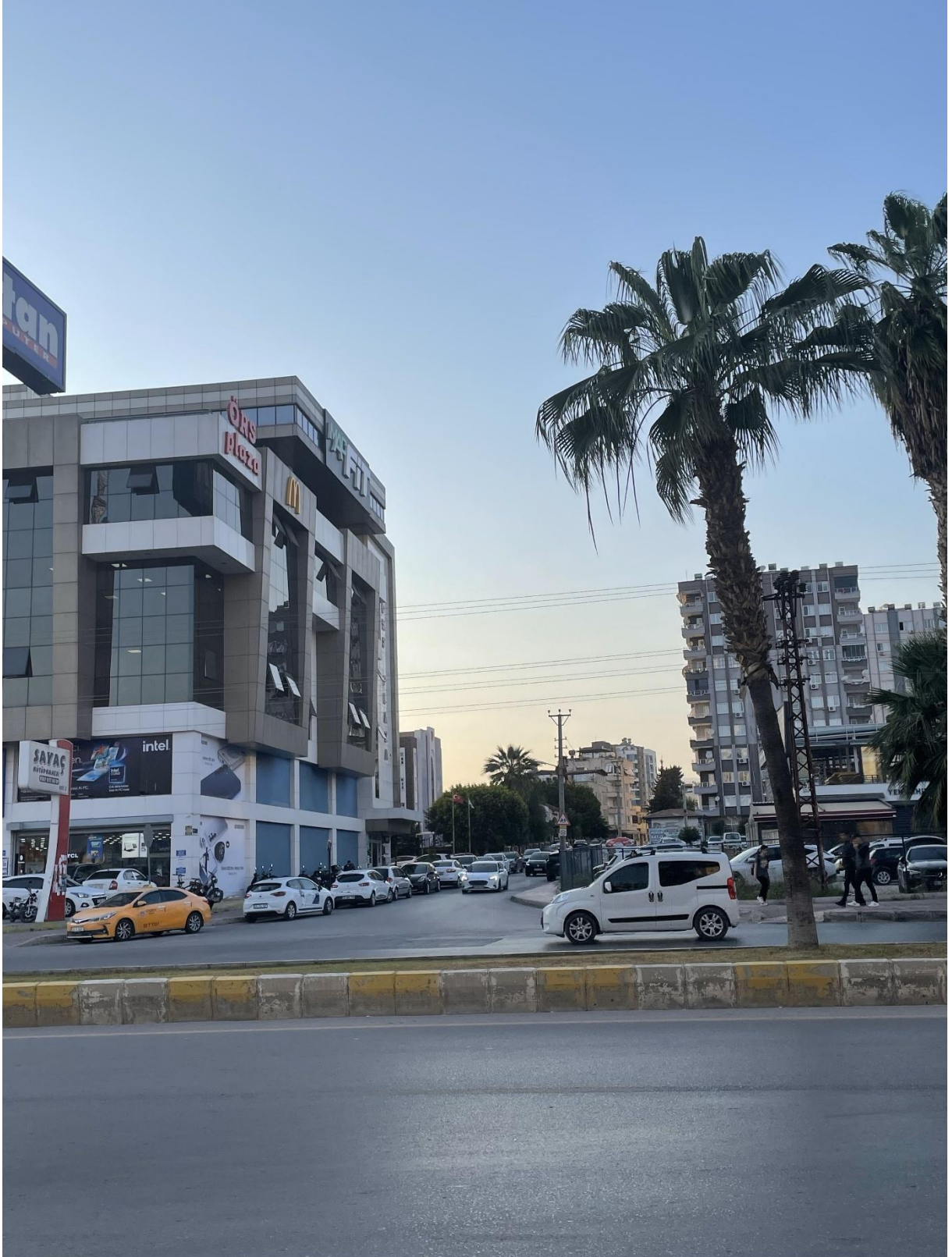
Şekil 3.50. 2224. Sokağın güney girişi (2)
