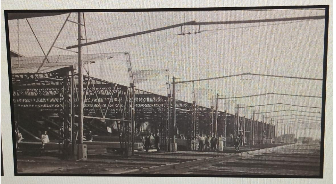
F. 33: Fabrika içinde ulaşım için kullanılan elektrikli tramvay sistemi. (Ayancık Orman İşletme Arşivi.)
