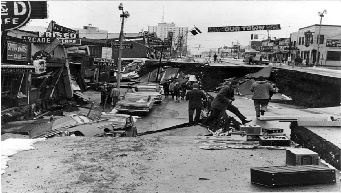
Şekil 1.2. Sıvılaşma kaynaklı zemin yer değiştirmesi (Alaska, 1964)
