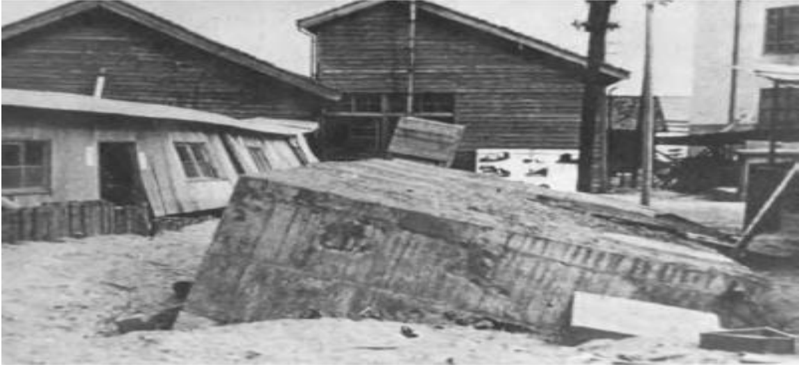
Şekil 2.2. Niigata depremi sonucu sıvılaşmış zeminde gömülü tankın yüzmesi (Kawasuni, 1968)
