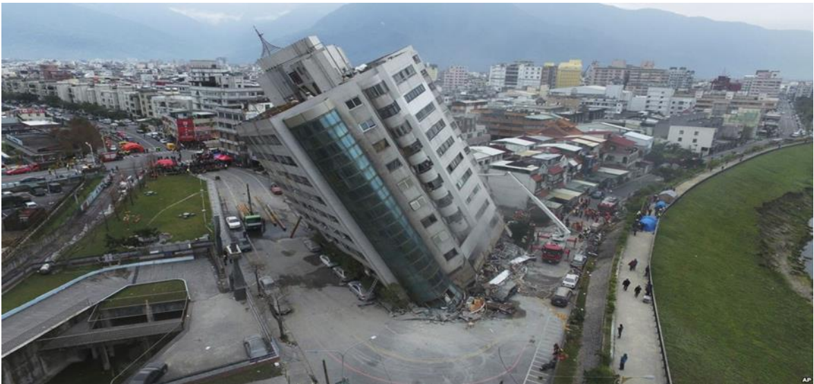
Şekil 1.1. Sıvılaşma kaynaklı temel oturması, Hualien, Tayvan (CNA, 2018)
