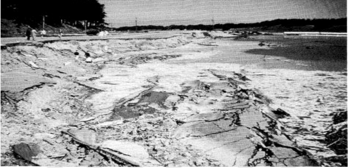
Şekil 2.4. Merced Gölü kıyısındaki akma tipi sıvılaşma, San Francisco (USGS, 1957)
