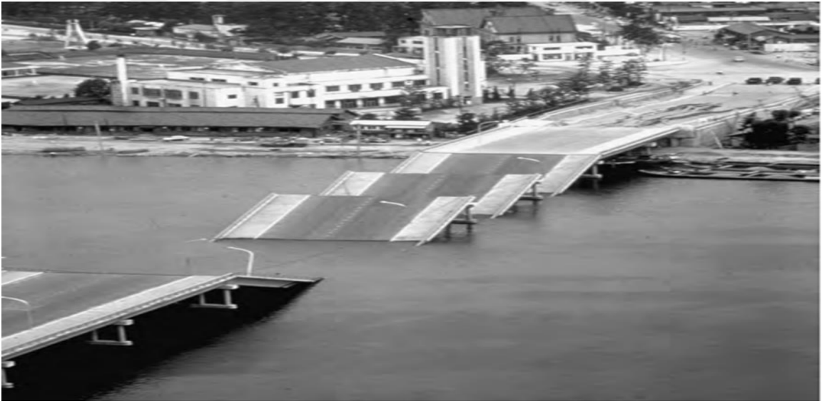
Şekil 2.3: Showa Köprüsü'nün çökmesi, sıvılaşma ve yanal yayılmadan kaynaklandı (EERC, 1964)
