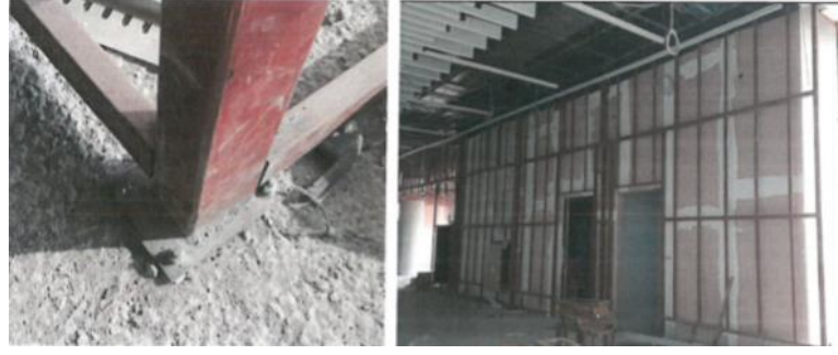
Resim 9. Kompakt Laminat Altı Duvar Konstrüksiyon İmalatı
