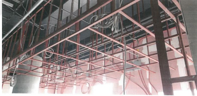
Resim 14. Taşıyıcı Yatay Profiller
