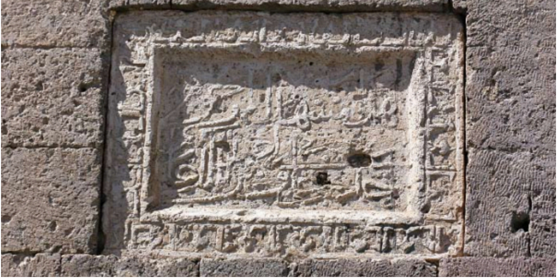
Şekil 4.46 Hacı Çavlı Kümbeti güney duvar üzerindeki kitabe (Kayseri Taşınmaz Kültür Varlıkları Envanteri’nden)
