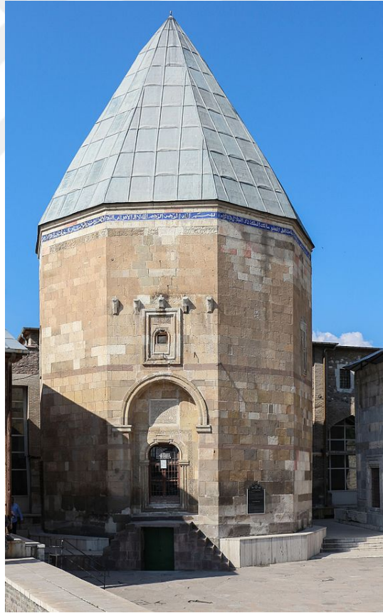
Şekil 4.16II. Kılıç Arslan Türbesi genel görünüş
