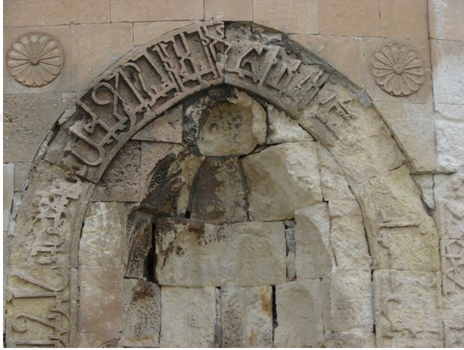
Şekil 4.65 Mama Hatun Kümbeti çevre duvarı taçkapı detayı
