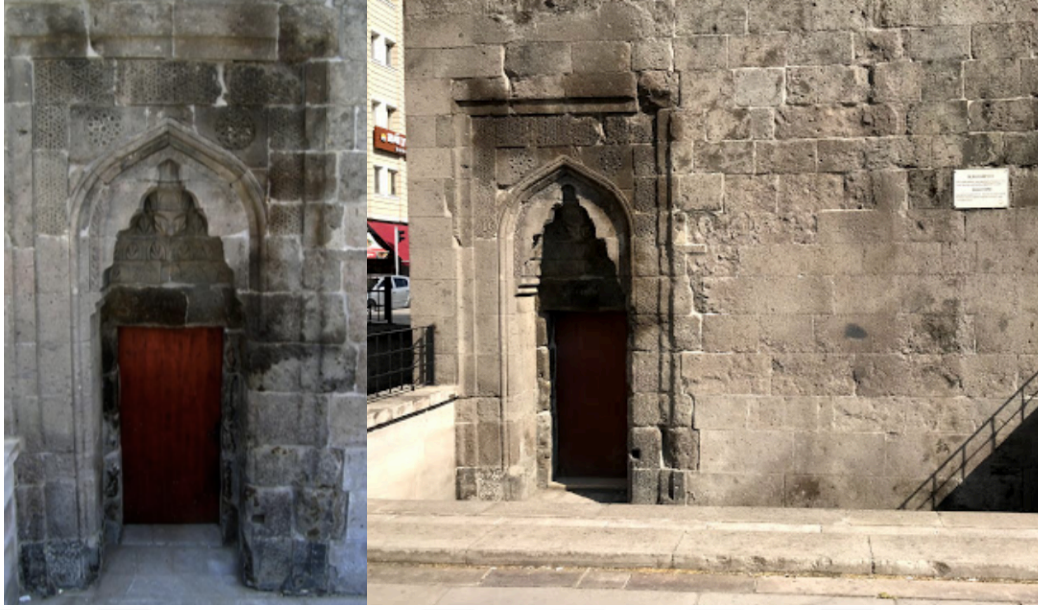
Şekil 4.34 Alaca Kümbet kuzey cephesi taçkapı
