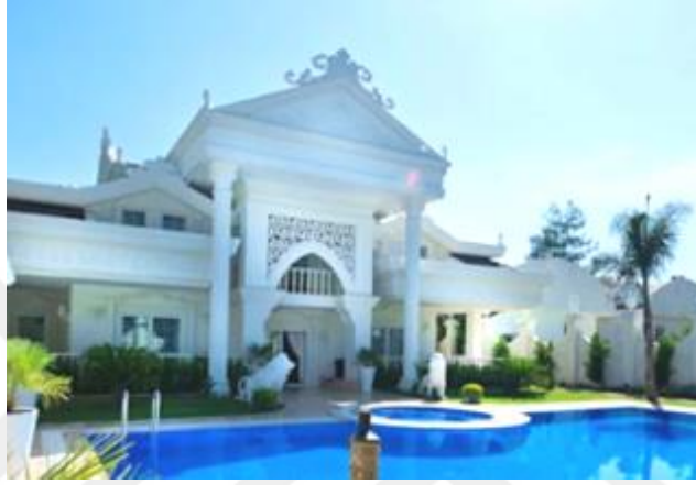
Şekil 3.9 2A sorusunda verilen yapı (Homify, b.t)
