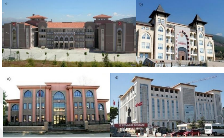
Şekil 2.5 a) Okul yapısı (Batuman, 2014); b) Kahramanmaraş Adliyesi (Kahramanmaraş.adalet, b.t); c) Sapanca Adalet Sarayı, (Mimdap, 2008a); d) Ankara İl Emniyet Müdürlüğü (Arkitera, 2019)
