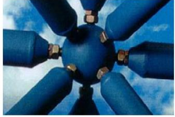
Şekil 2.4.1.1. Uzay Kafes Sistemlerde Düğüm Noktası (Küre Eleman) [20].
