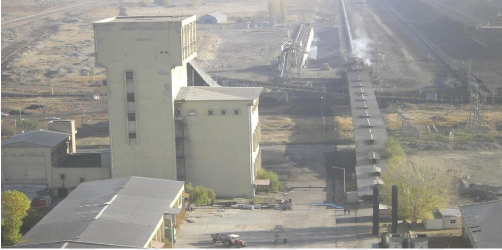
Şekil 3.8 : Santralin kömür kırma binası.
