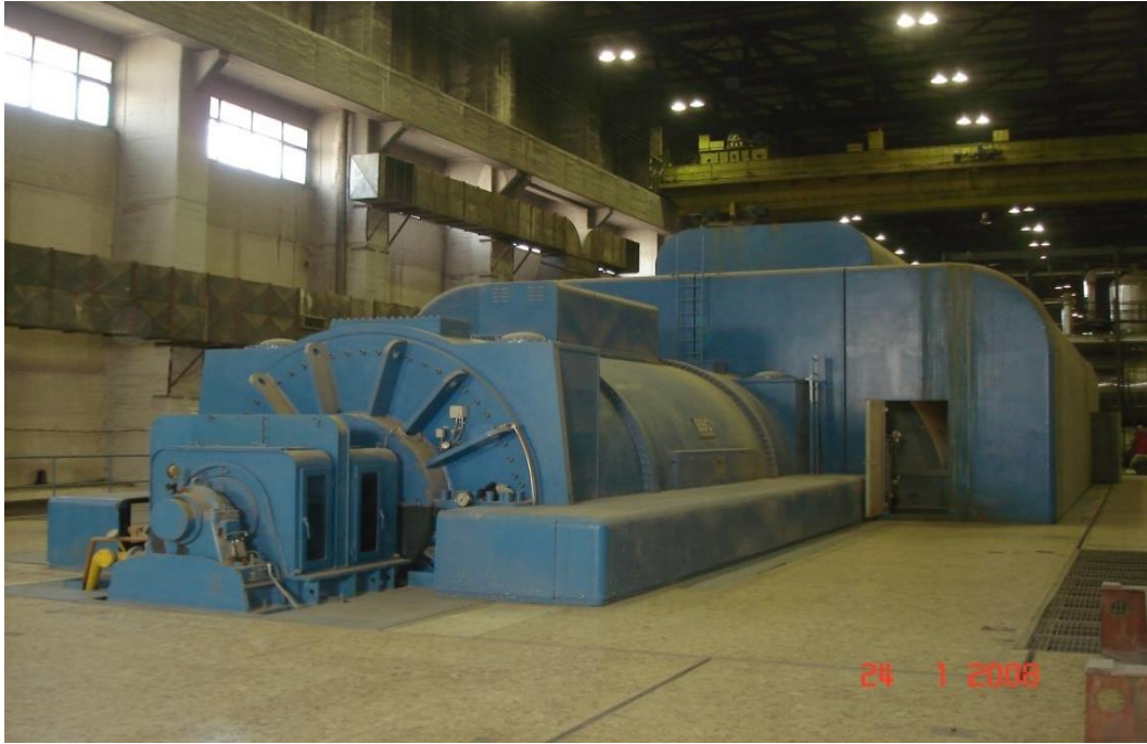
Şekil 3.5 : Santralin turbo-jeneratör grubu.
