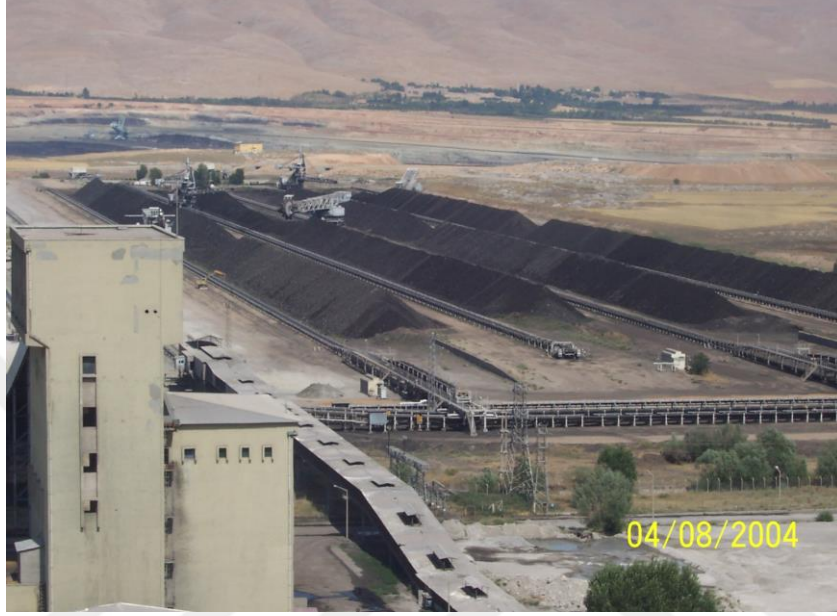
Şekil 3.3 : Santralin stok sahası.
