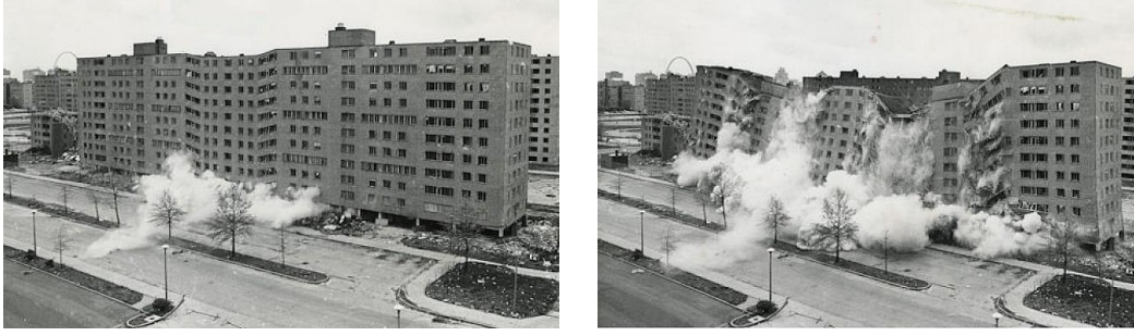
Resim 2.2. Pruitt-Igoe konutlarının yıkılışı (Koyuncu, 2019)
