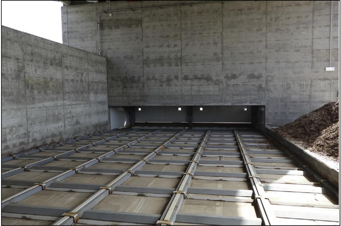
Şekil 3.3. Kayar tabanlı yakıt besleme sistemi
