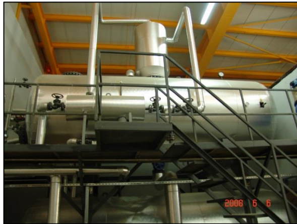
Şekil 3.14. Degazör tankı
