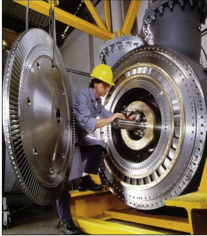
Şekil 1.21. 15 MW üç kademeli eksenel türbin montajı, Ormat
