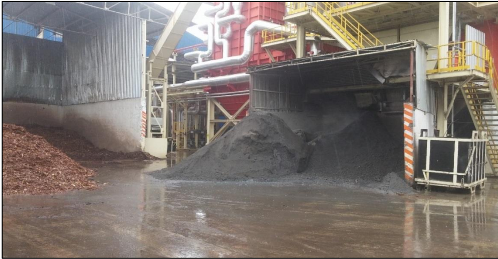
Şekil 3.8. Yanma sonrası oluşan kül depolama alanı
