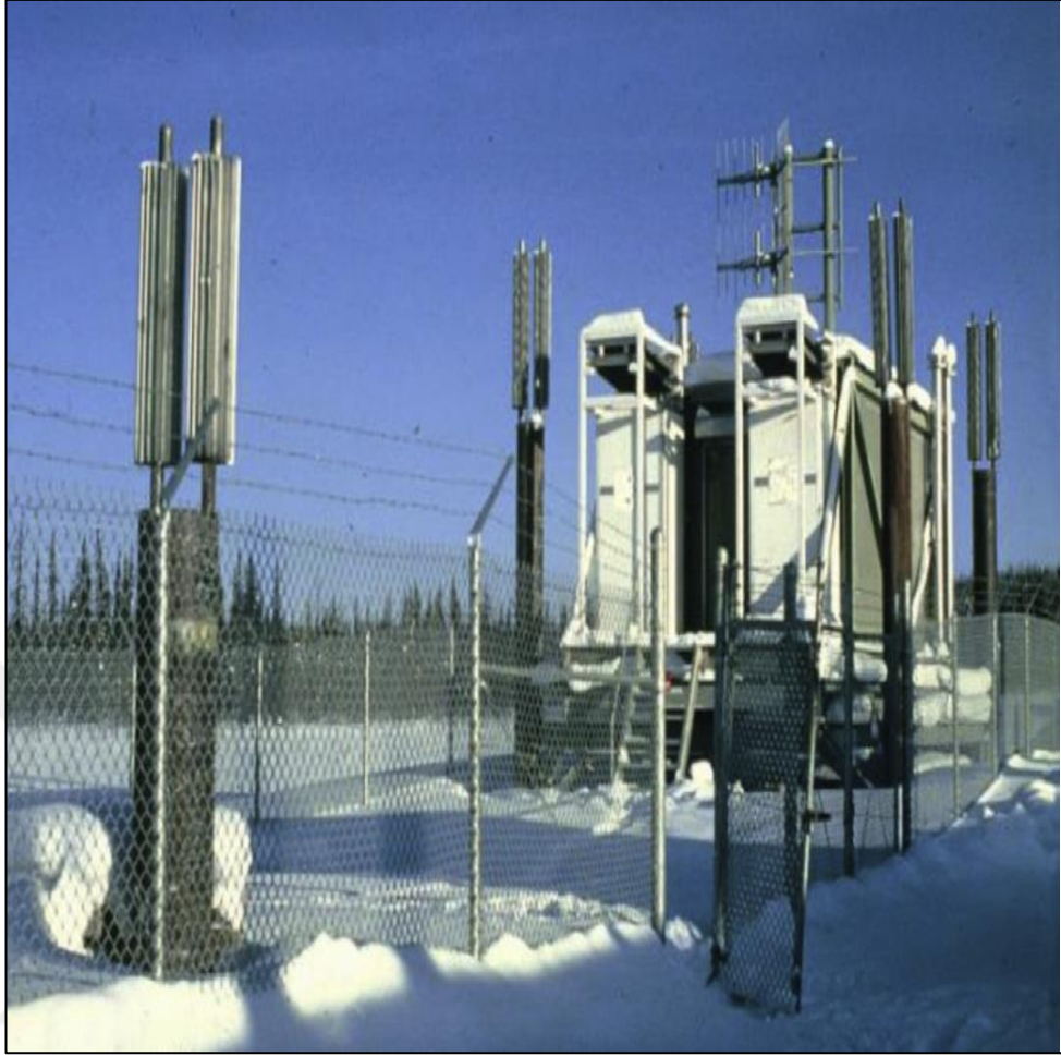
Şekil 1.20. Vana istasyonları enerji beslemesi için kullanılan 2 adet 600 W'lık ORC Alaska 2015
