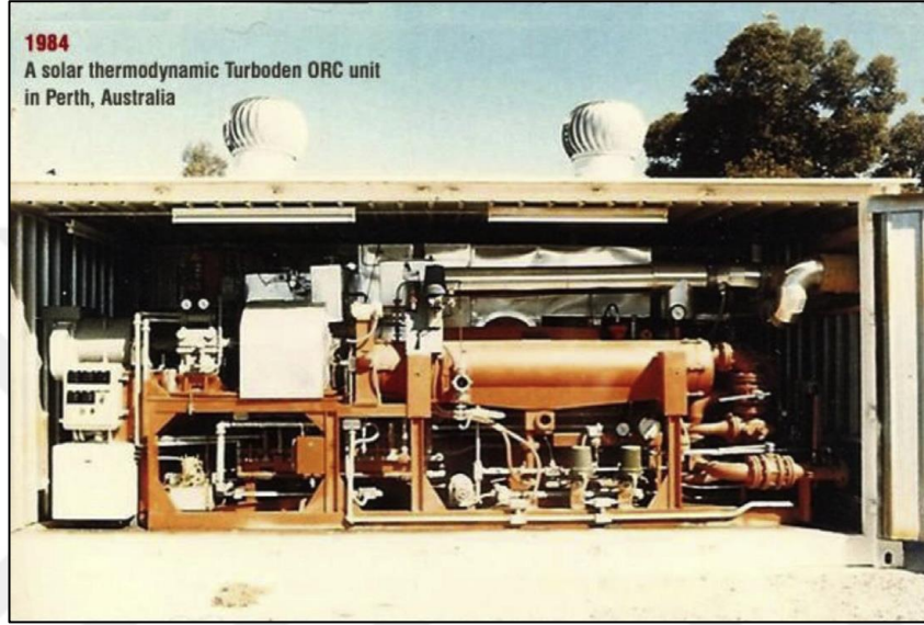
Şekil 1.17. Avustralya'daki güneş kolektörlerinden çalışan 35 kW dört kademeli türbin, 1984 Perth
