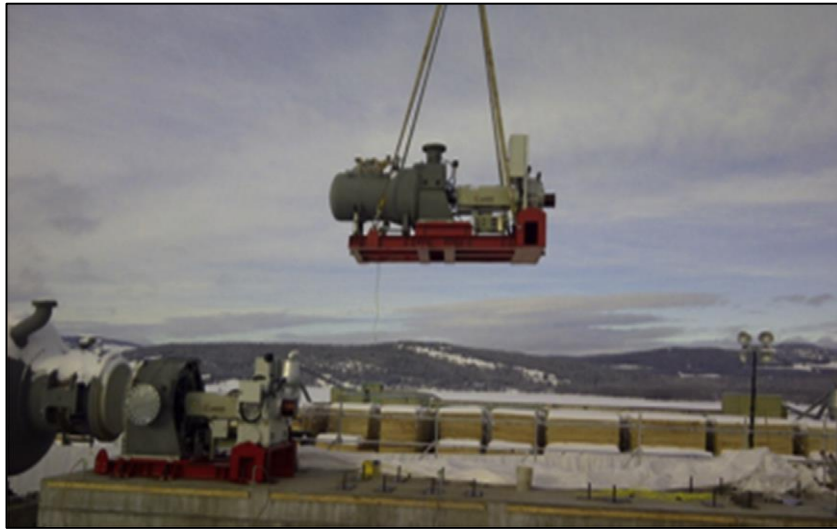
Şekil 1.28. 6 MW biyokütle ORC ünitesinin kurulum aşamasında görüntüsü, Fraser Lake, Kanada, 2015
