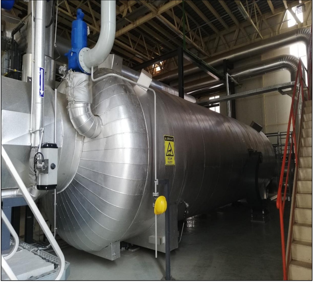
Şekil 3.19. ORC sistemi kondenseri
