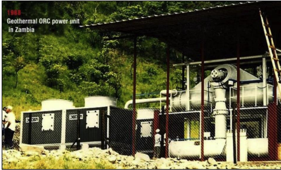
Şekil 1.24. 100 kW'lık Turboden Jeotermal Orc Türbinleri, Zambiya 1988
