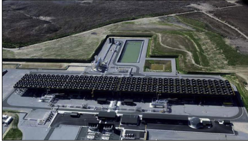
Şekil 1.22. 100 MW ORC jeotermal güç santrali, Yeni Zelanda, 2013
