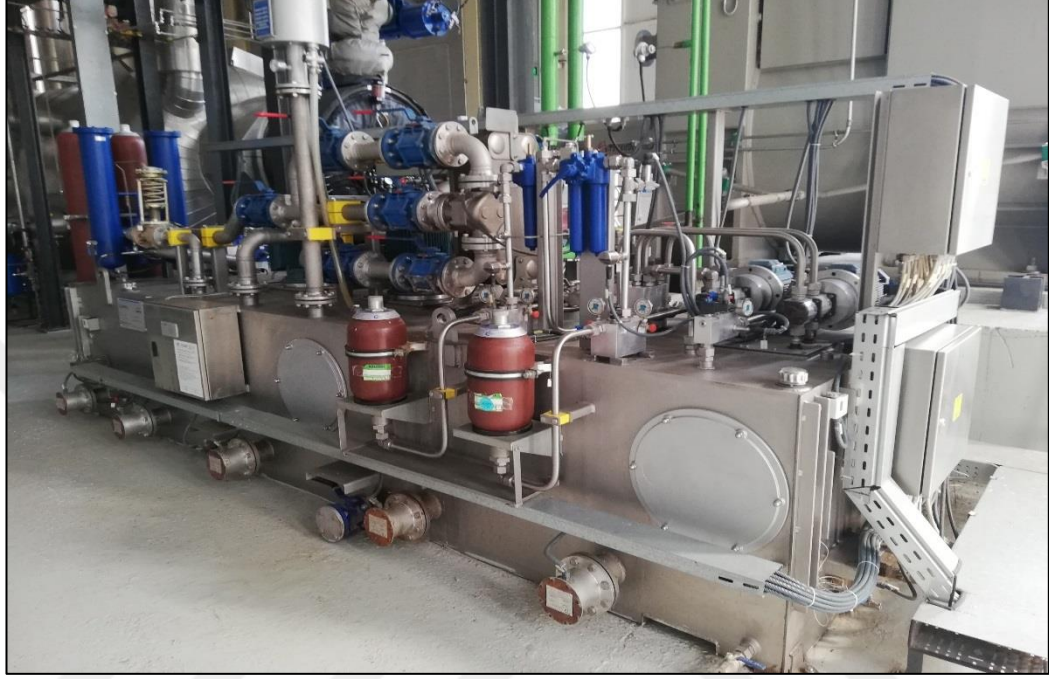
Şekil 3.24. ORC trbini yaęlama sistemi
