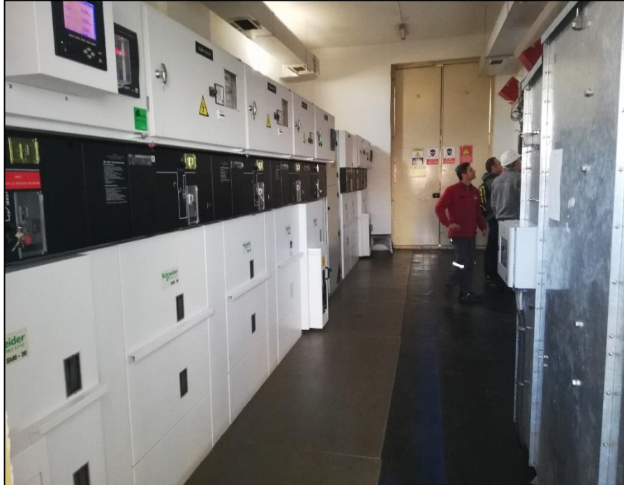
Şekil 3.23. ORC otomasyon ve sistem panoları
