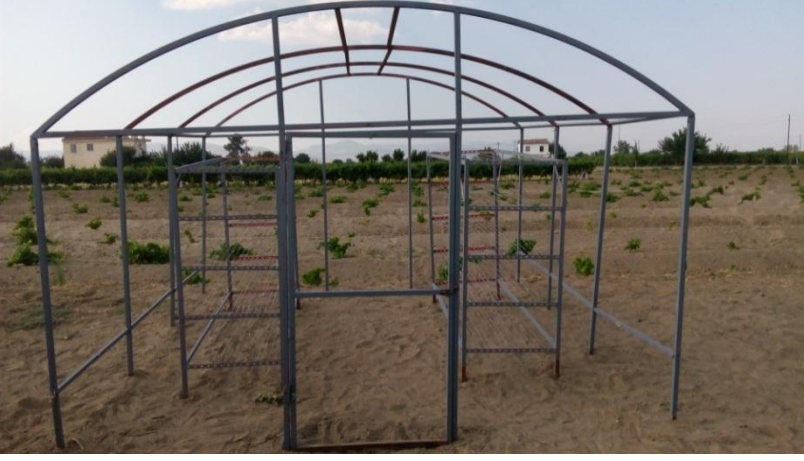
Şekil 3.4. Sera Konstrüksiyonunun Antipas Boya ile Boyanmış Hali.
