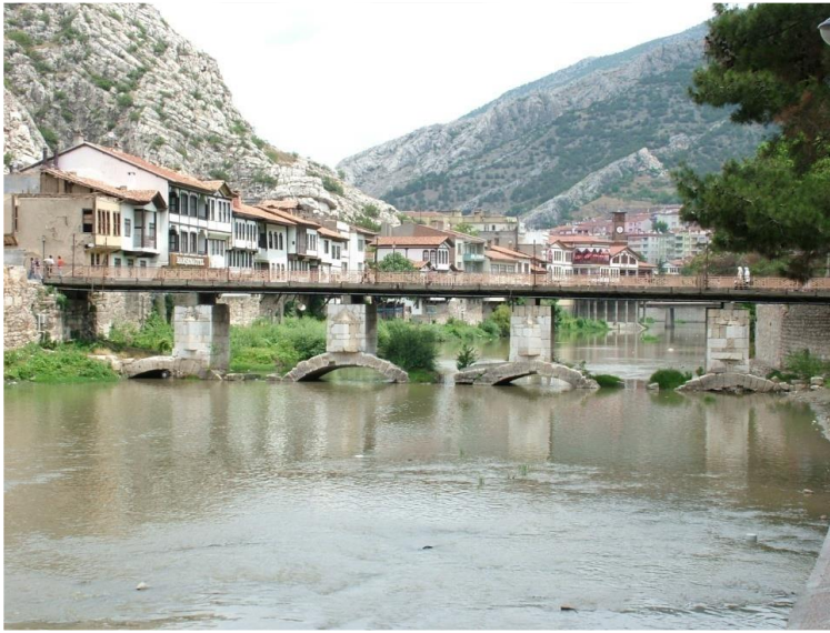
Resim 2.2. Yeşilırmak güncel yatağının, taşkın çökelleriyle dolması nedeniyle ayakları üç kez yükseltilen alçak köprü [6]
