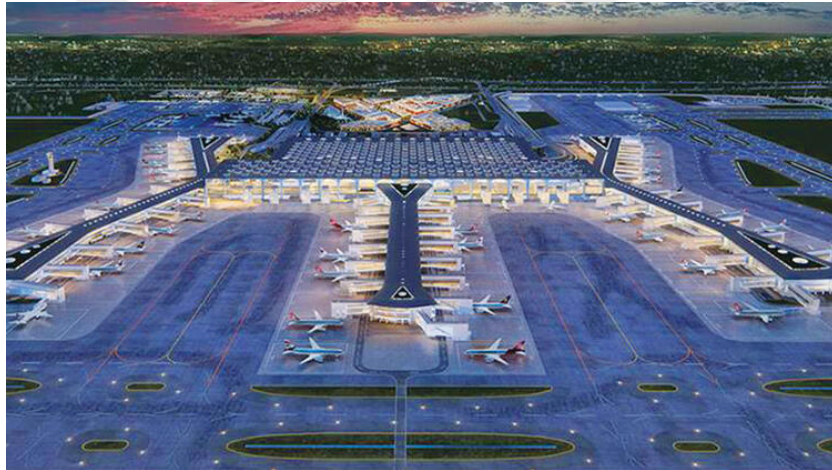
Şekil 4.4: İstanbul Yeni Havalimanı
