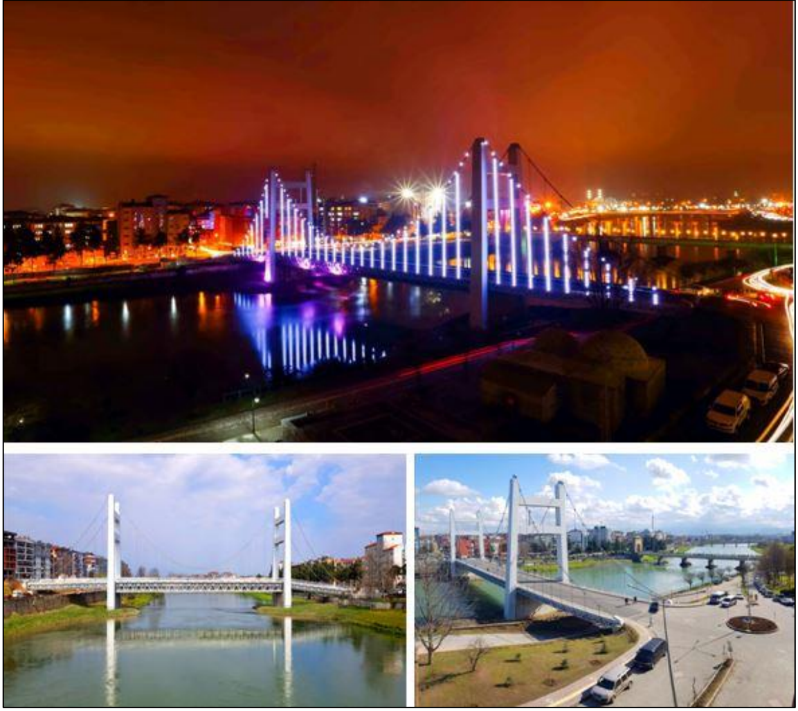
Şekil 6.9: Yeni Şehir Köprüsüne Ait Görüntüler (URL-5, 2019).
