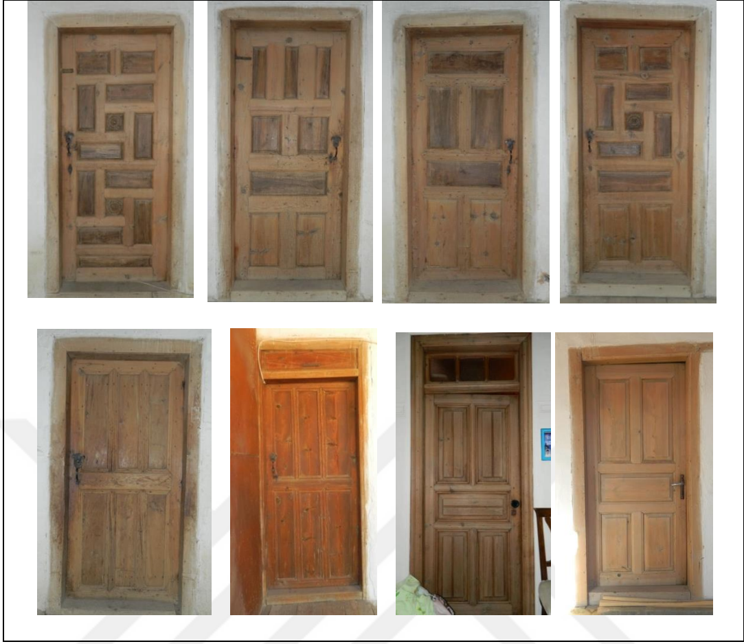
Şekil 4.10. Tablalı ahşap oda kapısı
