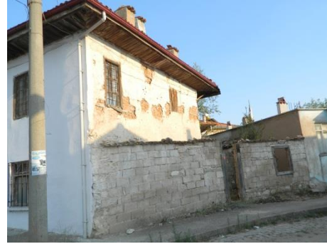
Şekil 5.3.17. Mehmet Bacakoğlu Evi kuzeybatı cephe görünümü
