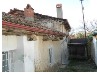
Şekil 5.10.4. Nurgül Yazıcı Evi cephede yer alan ahşap konstrüksiyon görünümü
