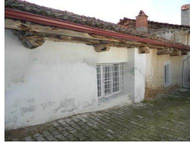
Şekil 5.10.13. Nurgül Yazıcı Evi kuzey cephesi görünümü
