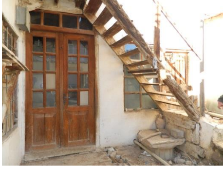
Şekil 5.6.15. Mehmet Ürek Evi zemin kat girişi ve ahşap merdiven görünümü
