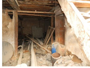
Şekil 5.13.4. Osman Nuri Çaput Evi zemin kat haneyaltı görünümü
