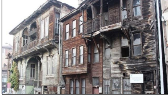
Şekil 2.9. Kocaeli/ Ereğli Ahşap karkas yapı görünümü
