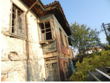
Şekil 5.8.15. Ahmet Can Evi teneke kaplı ve sıvalı cephe görünümü
