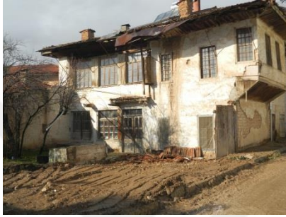
Şekil 5.12.18. İsmail Okul Evi güney cephe görünümü
