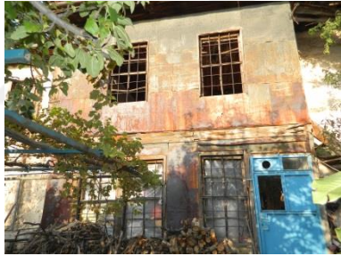
Şekil 5.8.17. Ahmet Can Evi teneke kaplı cephe görünümü
