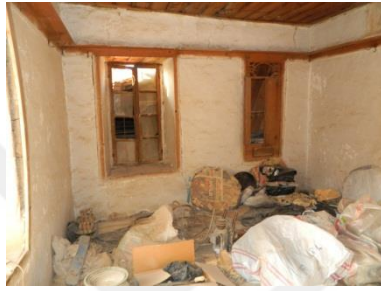
Şekil 5.8.11. Ahmet Can Evi birinci kat oda görünümü
