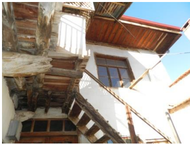
Şekil 5.6.3. Mehmet Ürek Evi güney cephe görünümü
