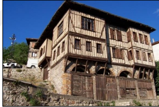
Şekil 2.8. Safranbolu Ahşap karkas hımış yapı görünümü ( https://emlakkulisi.com/safranbolu-evleri-unesco-dunya-mirasi-listesinde/442845 )
