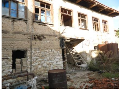
Şekil 5.13.3. Osman Nuri Çaput Evi güney cephenin görünümü
