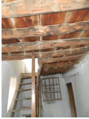
Şekil 5.14.3. İsmail Tırmık Evi haneyaltı ahşap tavan konstrüksiyon görünümü
