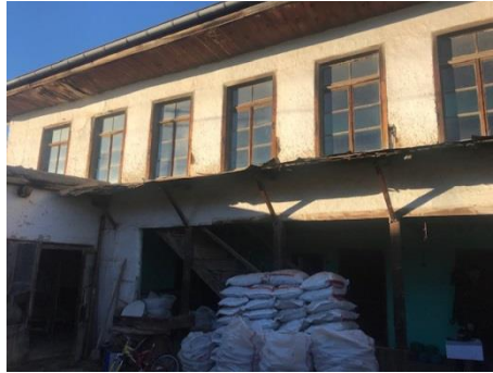
Şekil 5.11.16. Osman Aydınli Evi güney cephesi görünümü
