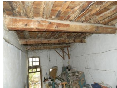
Şekil 5.7.4. Halil Çıplakoğlu Evi tavan ahşap konstrüksiyon
