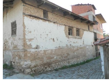
Şekil 5.13.16. Osman Nuri Çaput Evi kuzey cephesi görünümü
