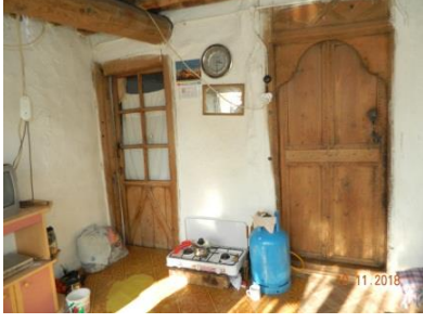
Şekil 5.9.12. Meryem Topal Evi birinci kat oda kapılarının görünümü
