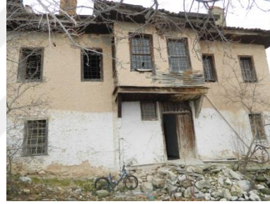
Şekil 5.5.4. İsmail Dayıoğlu Evi kuzeybatı cephe görünümü
