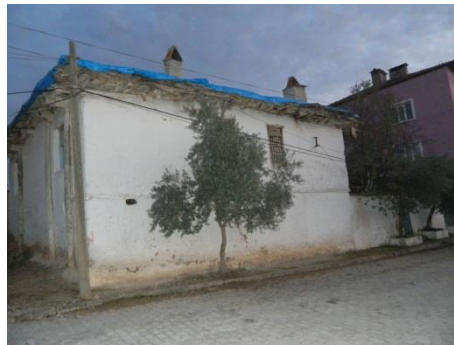
Şekil 5.4.15. Mehmet Ali Yılmazlı Evi kuzeybatı ve kuzeydoğu cephe görünümü
