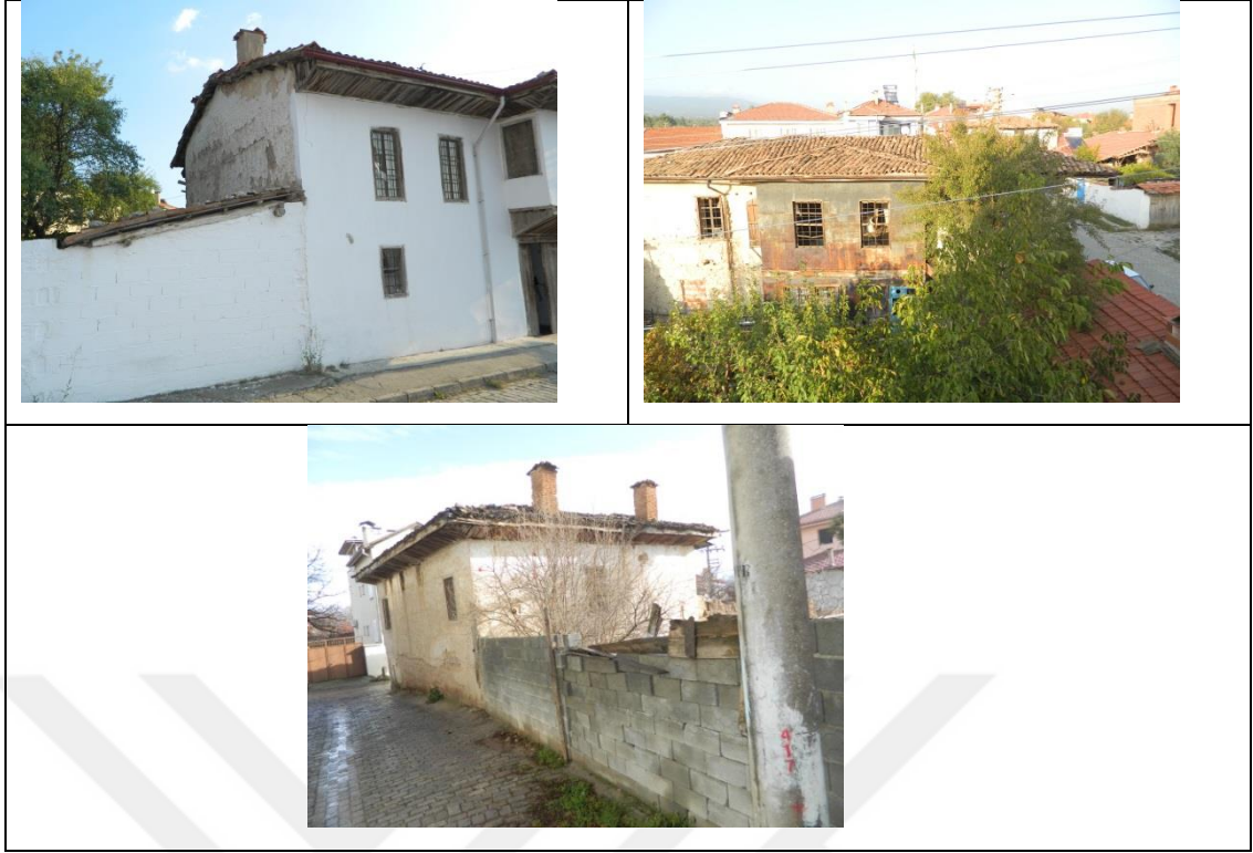
Şekil 4.18. Alaturka kiremitli çatı
