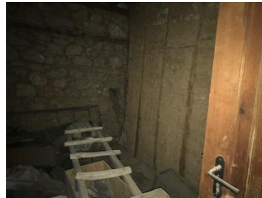
Şekil 5.11.4. Osman Aydınli Evi duvar malzemelerinin görünümü
