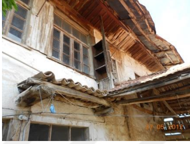
Şekil 5.12.3. İsmail Okul Evi güney cephe görünümü
