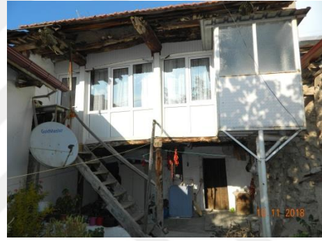
Şekil 5.9.19. Meryem Topal Evi güney cephesi görünümü
