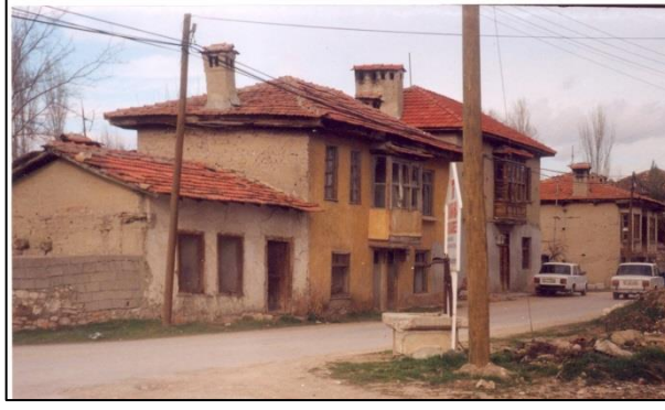
Şekil 2.6. Antalya/Korkuteli kerpiç yığma yapı görünümü (Yıldırım, 2010)
