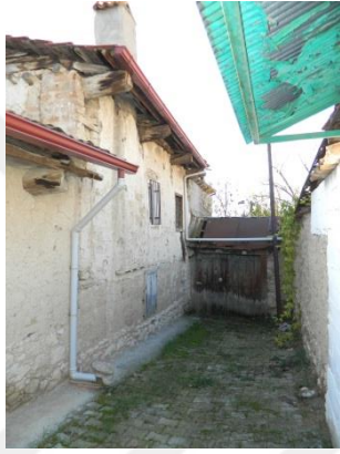
Şekil 5.9.18. Meryem Topal Evi kuzey cephesi görünümü
