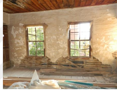
Şekil 5.8.4. Ahmet Can Evi ahşap karkas duvarı görünümü
