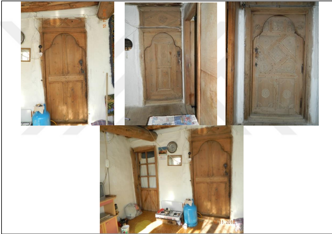
Şekil 4.9. El oymalı ahşap oda kapıları
