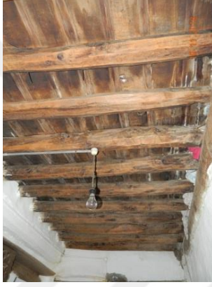
Şekil 5.9.3. Meryem Topal Evi tavan ahşap konstrüksiyon görünümü
