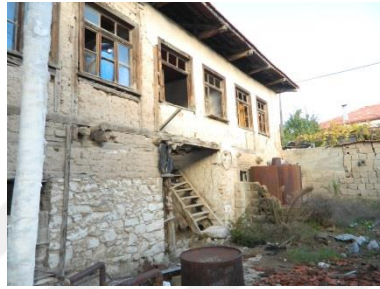
Şekil 5.13.17. Osman Nuri Çaput Evi güney cephesi görünümü
