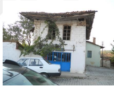
Şekil 5.8.18. Ahmet Can Evi güneydoğu cephe görünümü
