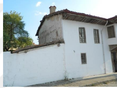
Şekil 5.3.4. Mehmet Bacakoğlu Evi kuzeydoğu cephe duvar malzeme ve özgün sıvanın görünümü
