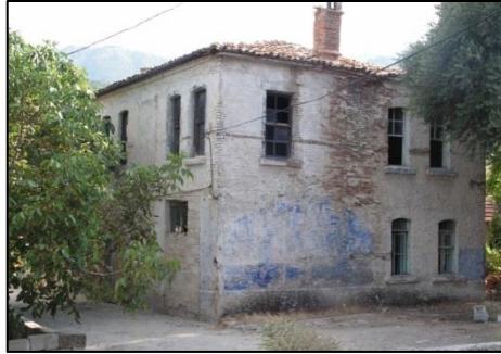
Şekil 2.7. Denizli/Buldan tuğla yığma yapı görünümü
