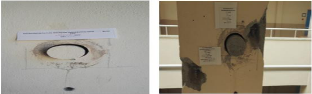
Şekil 4.9: İncelenen yapıdan alınan karot numuneler.
