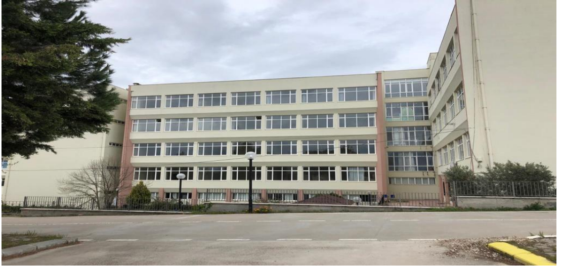
Şekil 4.3: D blok arka cepheden görünüş.
