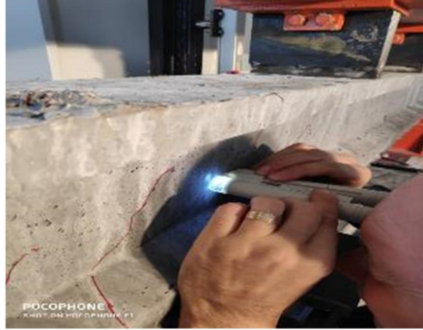
Şekil 3.12: Çatlak genişliğinin ölçülmesi.
