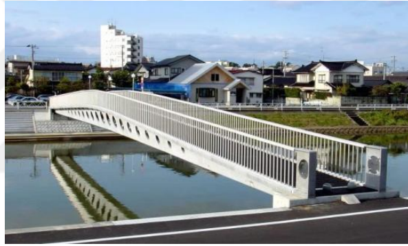
Şekil 1.5: Sakata Mirai Yaya Köprüsü [15].
