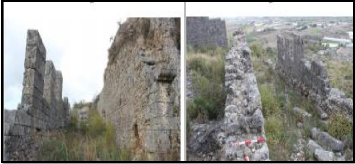
Levha 7a: Bastion Yapısı
