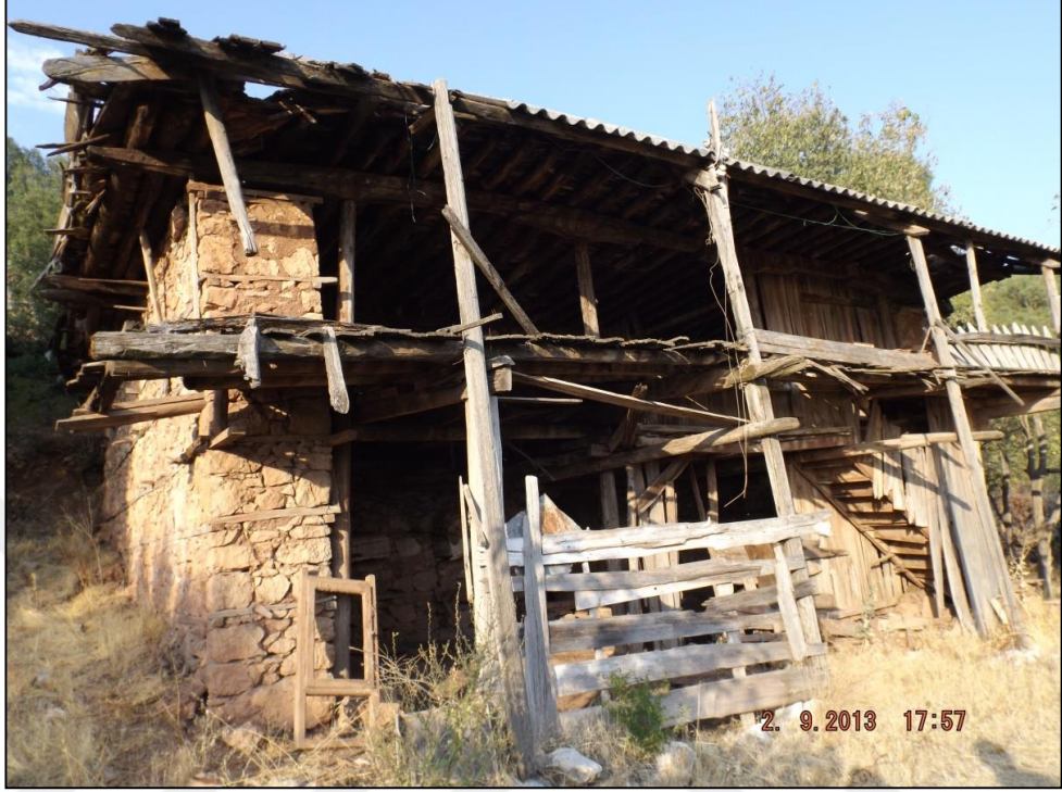
Resim 29: Toprak Damlı Taş Duvarlı Ev (1900?) 696
