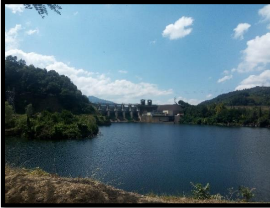
Şekil 16: Suat Uğurlu baraj seti ve mansap kesmi
