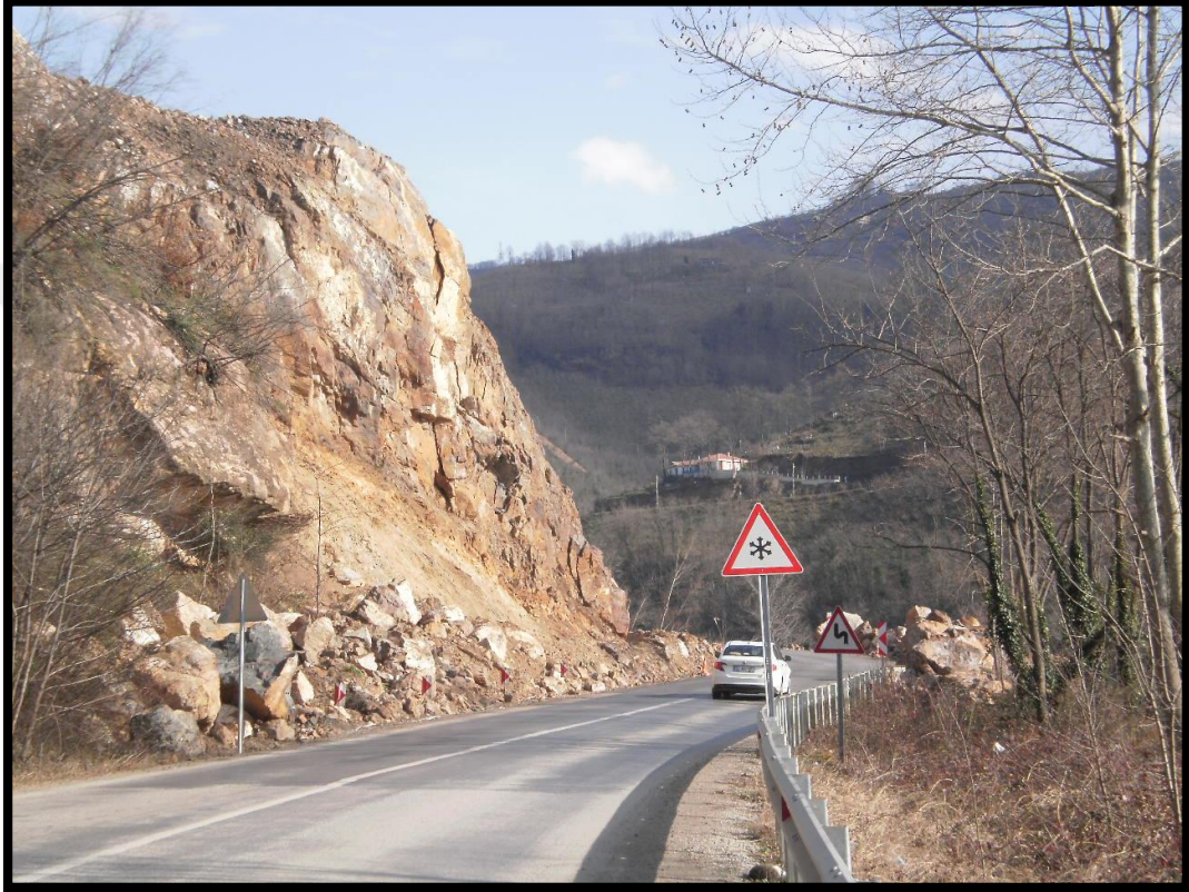
Şekil 87: Yol kenarlarında kaya düşmelerinin yaşandığı bir alan (Ayvacık-Çarşamba yolu)
