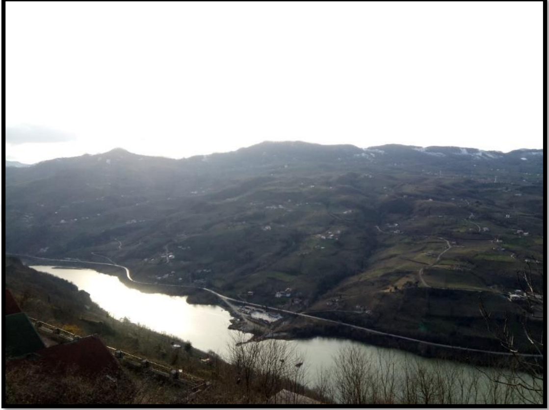
Şekil 5: Plato alanı (Eynel Mahallesinden güney batıya bakış)
