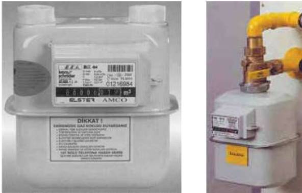
Resim 4.3. İki ve bir bağlantılı körüklü sayaç (UGATEM A.Ş., 2019)
