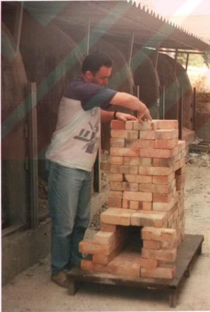
Resim 25: Fırın Yapımı Öncesi Tuğlaların Dizilerek Fırın Planını Kontrol Etme
