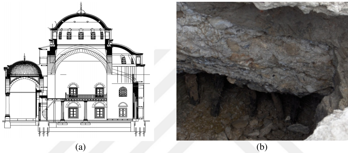
Resim 2.7. Ferhat Paşa Camii (a) kesiti ve (b) temelindeki tarihi meşe kazıkları [8]
