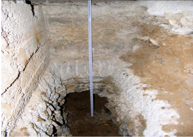
Resim 3.7. Kuleli Askeri Lisesi'nde açılan araştırma çukuru ile bulunan galeri [37]
