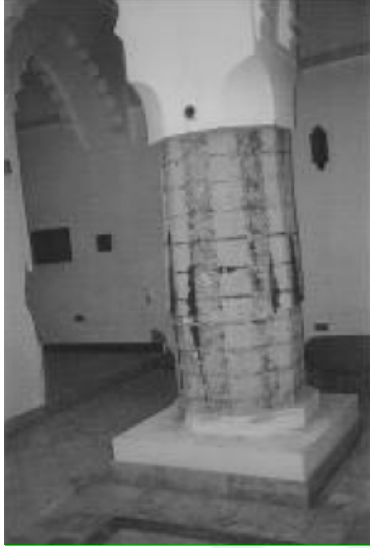
Resim 2.9. Umman Fransız müzesinde bozulmuş kolon [12]
