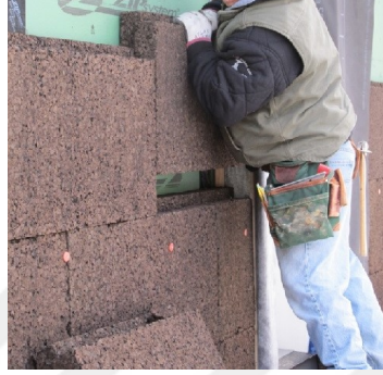
Şekil 2.25 : Mantar ısı yalıtımının uygulanması.
