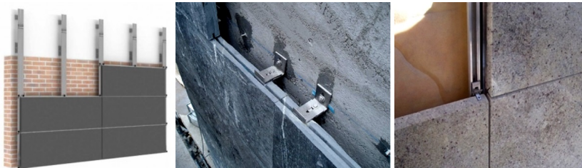
Şekil 2.22 : Doğal ve yapay taş plakaların mekanik montajı.
