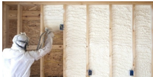
Şekil 2.35 : Püskürtme yöntemi ile poliüretan köpük uygulaması.
