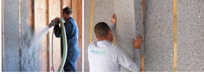
Şekil 2.24 : Selüloz ısı yalıtımının uygulanması.
