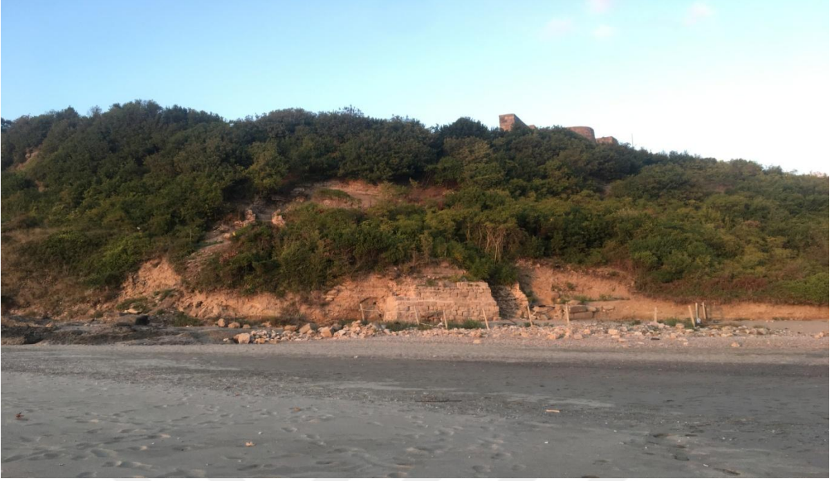
Resim 63: Bizans Dönemi Batı Sur Duvarı Moloz Bloklarla Oluşturulan Duvar (Foto: Gürcan Laçın)
