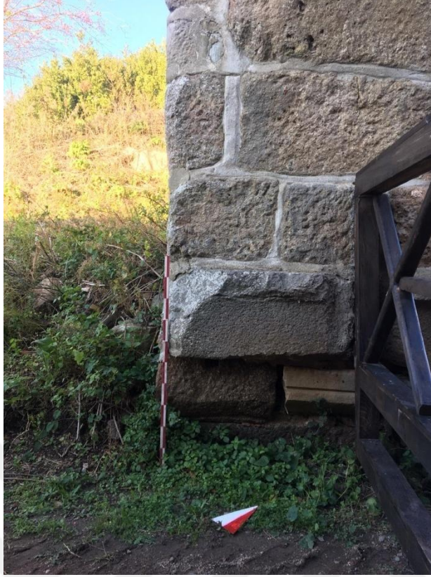
Resim 69: Kapıda Kullanılan Devşirme Bloklar (Foto Gürcan Laçın)
