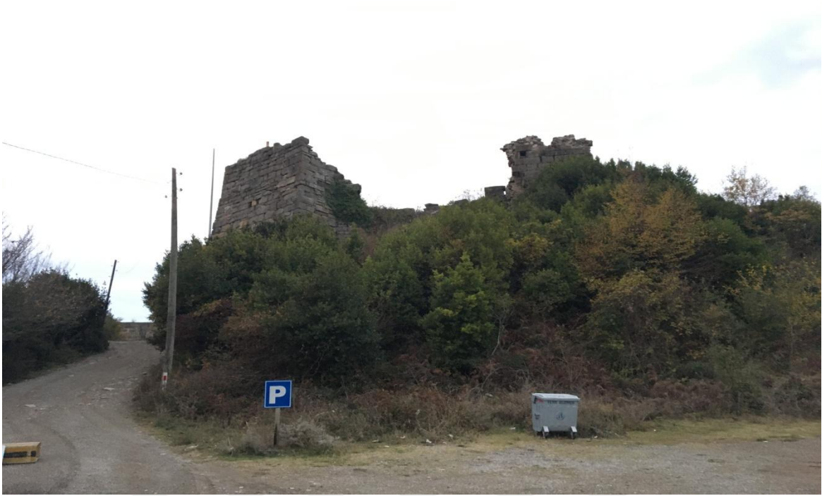
Resim 47: Doğu Sur Duvarı Bizans Dönemi Genel Görünüm (Foto: Gürcan Laçın)
