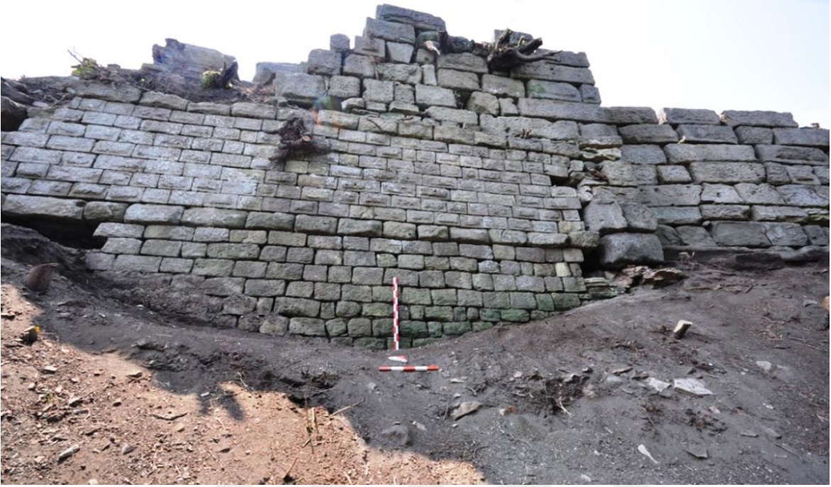
Resim 15: Geç Dönem Kuzey Sur Duvarı (Foto: Gürcan Laçın)
