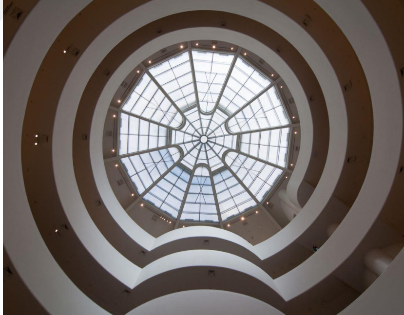
Şekil 56: Solomon R. Guggenheim Müzesi Çatı Görünümü
