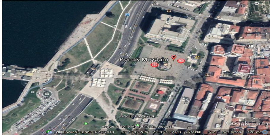
Şekil 2.5; İzmir Kışlası’nın Yıkılmadan Önceki Konumu.
