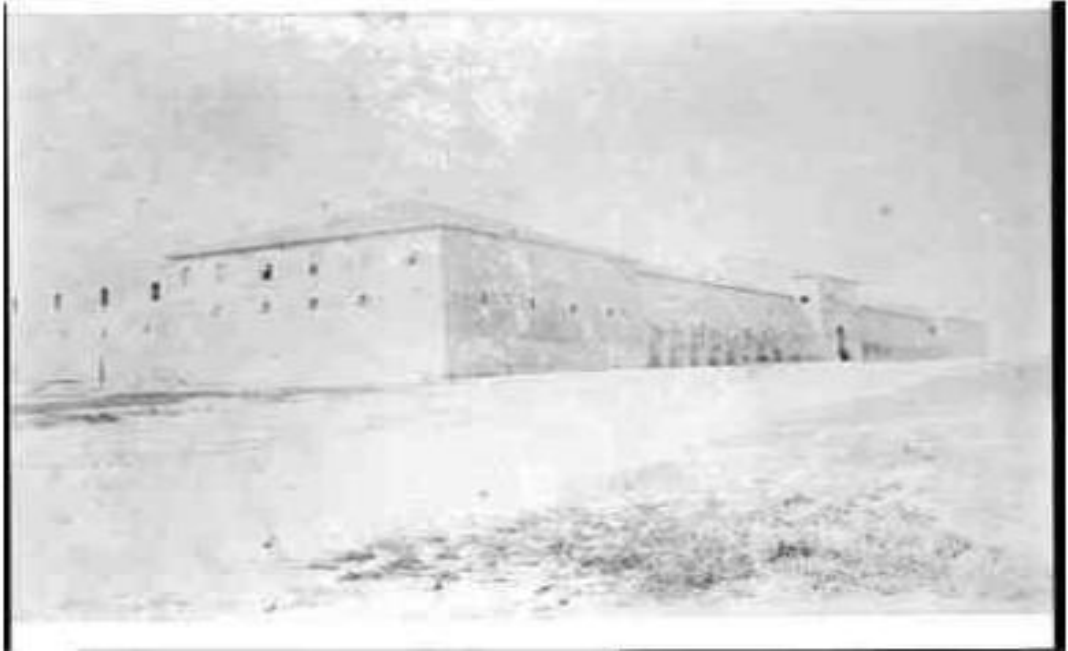
Şekil 2.26; Halep Şeyh Yaprak Kışlası'nın Kuzey Tarafından Görünüşü. 299
