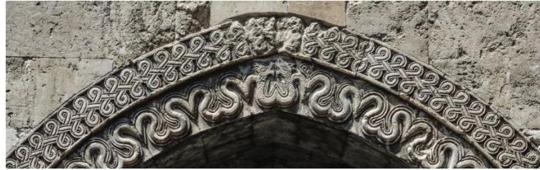
Görsel 24: Geçme, Kayseri Sultan Hanı, Kemerde Taş Kabartma
