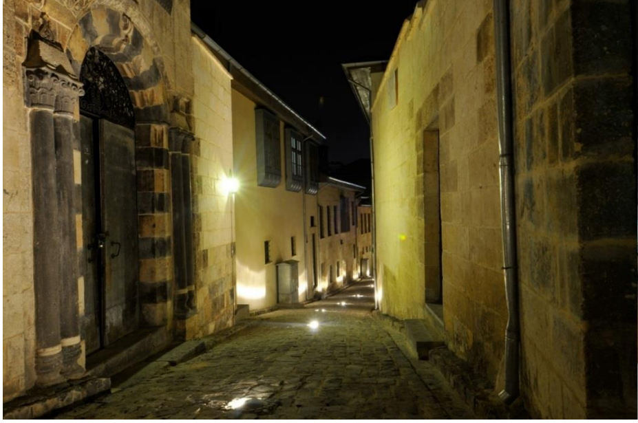
Şekil 3.28. Koruma amaçlı imar planı uygulamaları (Sokak Aydınlatması) (Anonim, 2010b).
