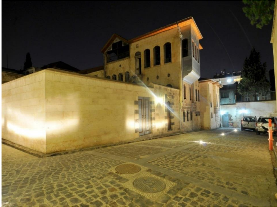
Şekil 3.29. Koruma amaçlı imar planı uygulamaları (Sokak Aydınlatması) (Anonim, 2010b).
