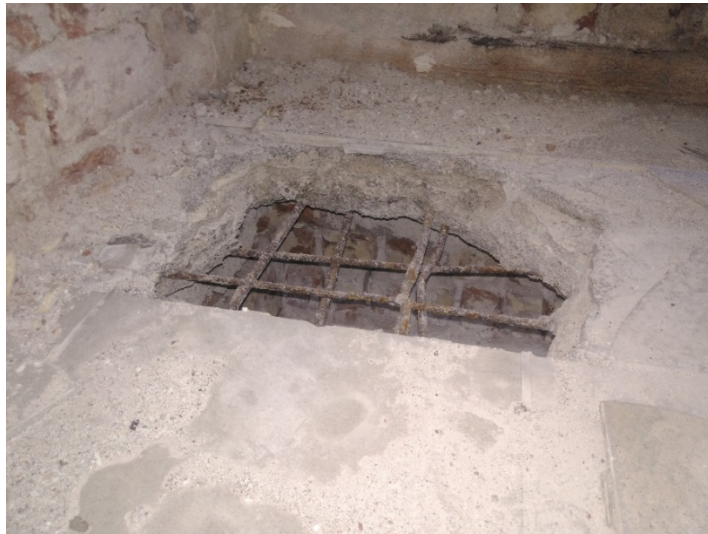
Şekil 4.18: İncelenen yapıda kullanılan donatılı betonarme döşeme
