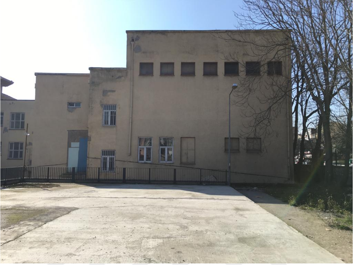
Şekil 4.2: İnceleme konusu yapının mevcut durumunun doğu cephesinden bir görünüm
