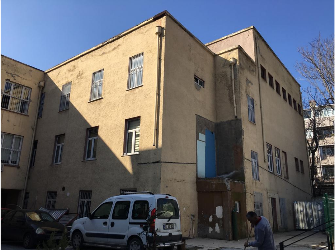
Şekil 4.1: İnceleme konusu yapının mevcut durumunun güney-doğu cephesinden bir görünüm
