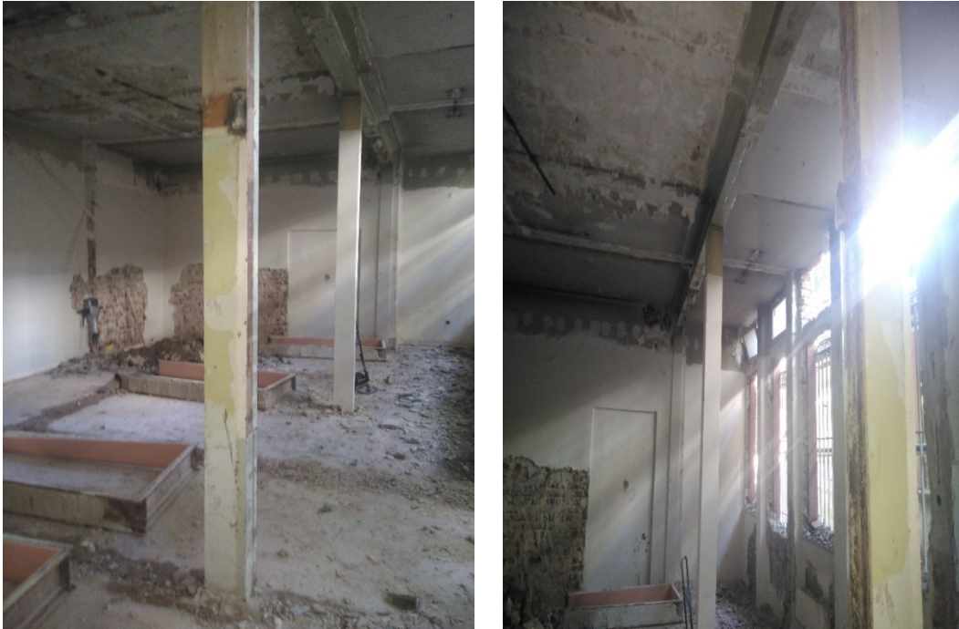
Şekil 4.11: İnceleme konusu yapıya eklenen çelik kolon ve kirişler
