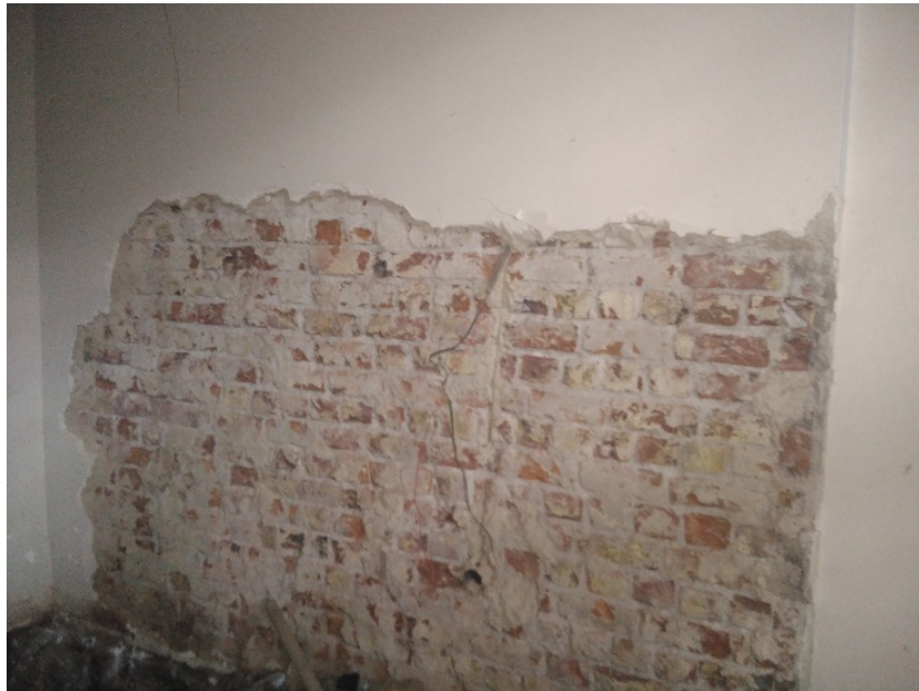
Şekil 4.16: İncelen yapıya ait bir yığma duvar örneği
