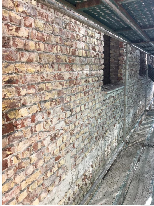
Şekil 4.17: İncelenen yapıya ait bir yığma duvar örneği
