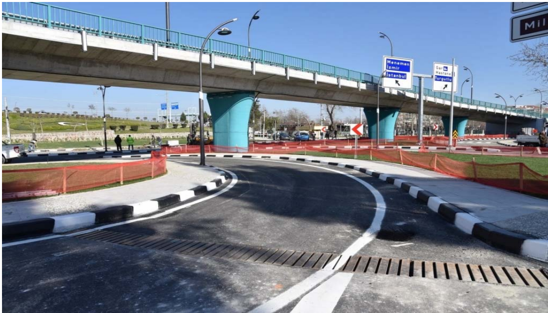
Şekil 2.27. Öğretmenevi kavşak köprüsü – Manisa
