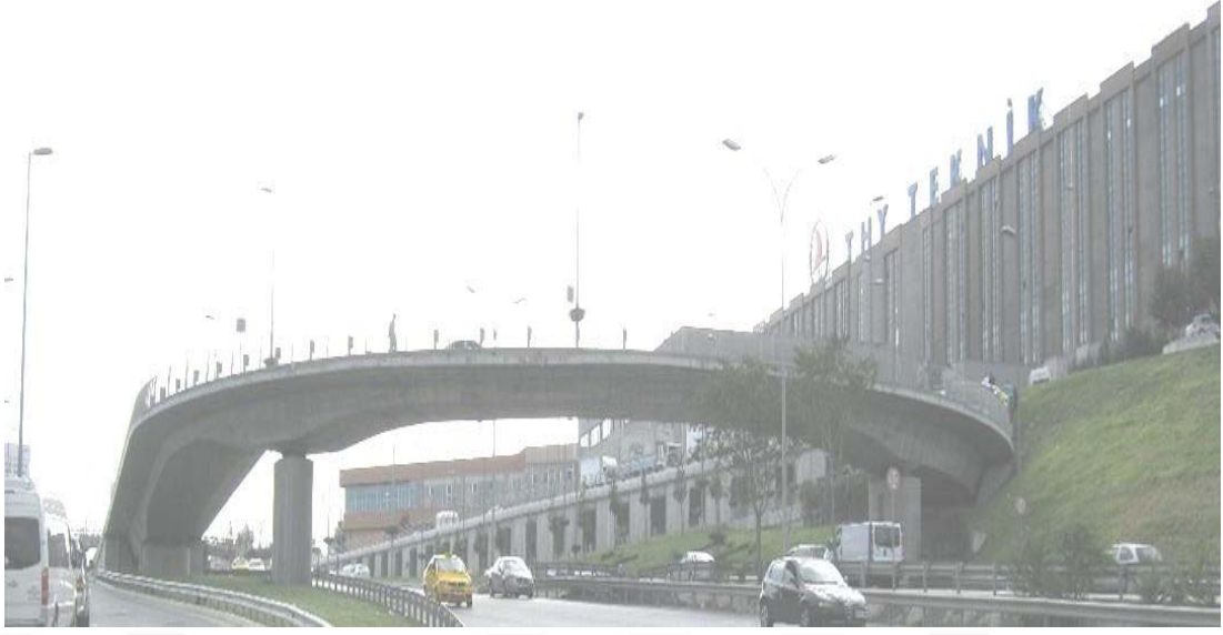
Şekil 2.18. Değişken kesitli yerinde dökme ardgermeli süreki tabliye köprü, Atatürk Havalimanı,
