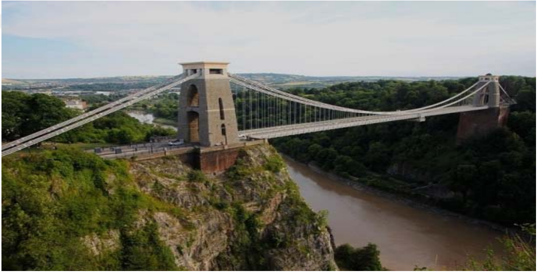
Şekil 2.4. Clifton asma köprüsü (İngiltere)
