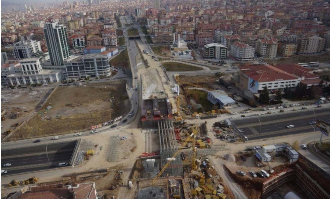
Şekil 2.21. Ankara Melikşah Köprüsü yapım aşaması
