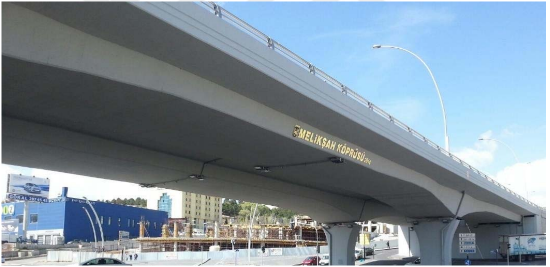
Şekil 2.22. Ankara Melikşah Köprüsü'nün tamamlanmış hali
