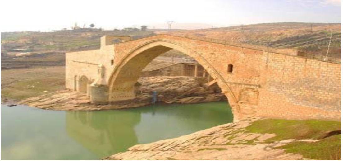
Şekil 2.9. Malabadi kemer köprüsü (Diyarbakır Türkiye 1147)
