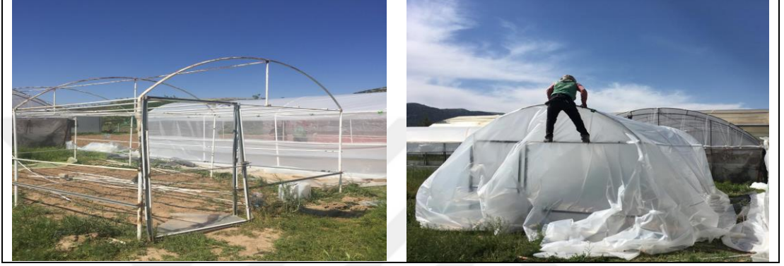
Şekil 3.6. Seraların örtü malzemelerinin yenilenmesi
