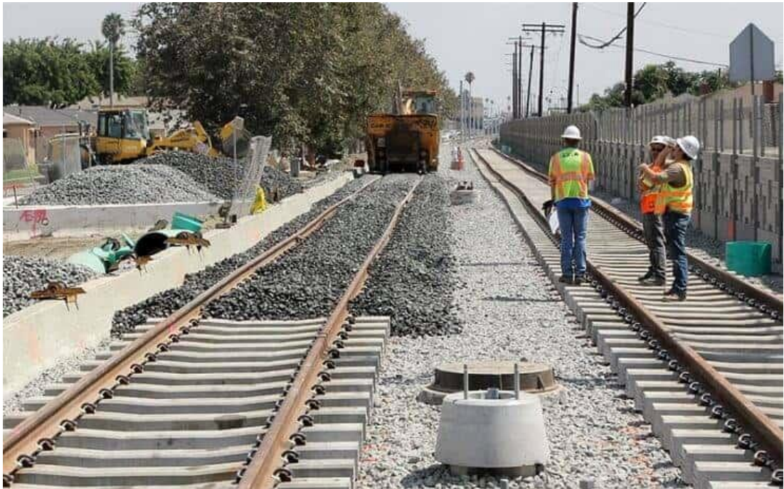
Şekil 3.10. Balastı serilen demiryolu hattı
