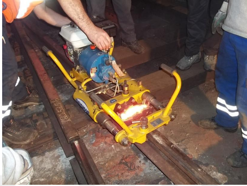
Şekil 5.16. Yakma alın kaynağı
