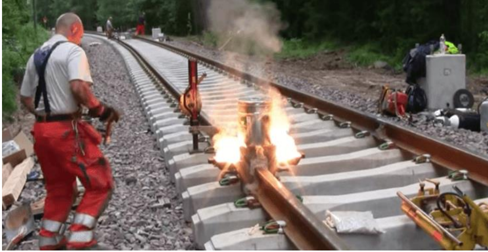
Şekil 5.15. Alüminotermit kaynağı
