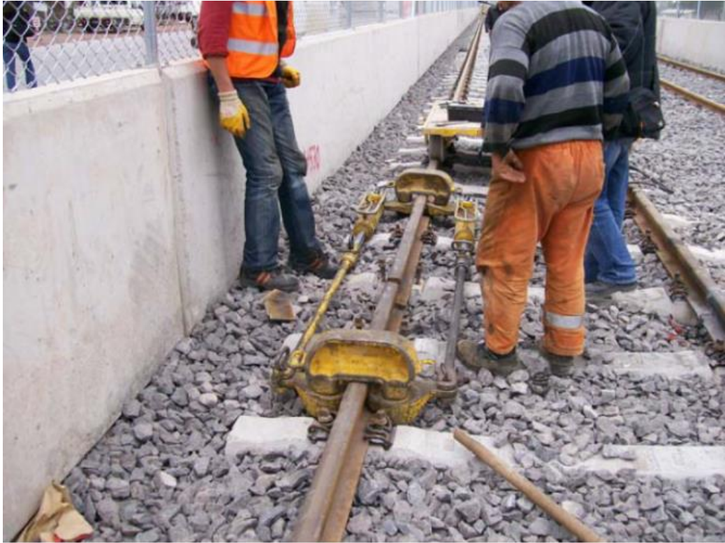
Şekil 5.12. Ray gerdirme makinesi
