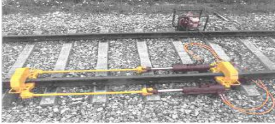
Şekil 5.14. Rayın gerdirilerek geriliminin alınması
