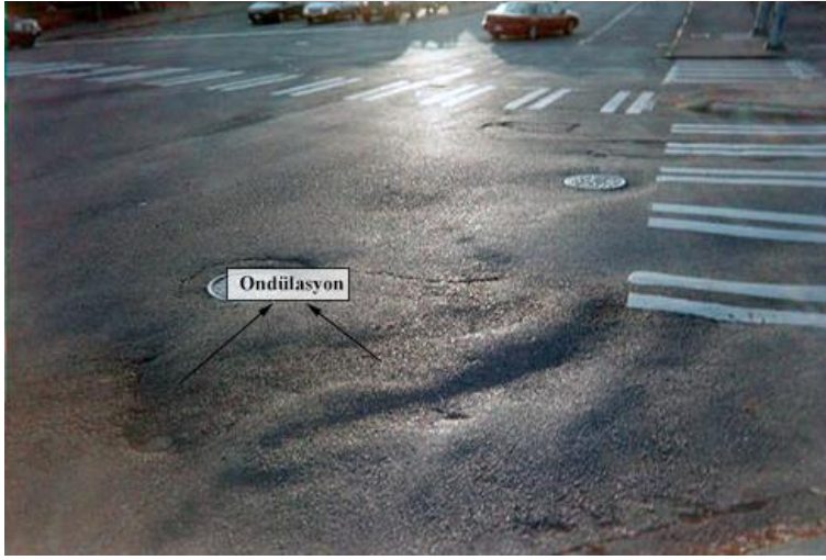
Resim 2.2. Bir kavşakta meydana gelen ondülasyon [33]
