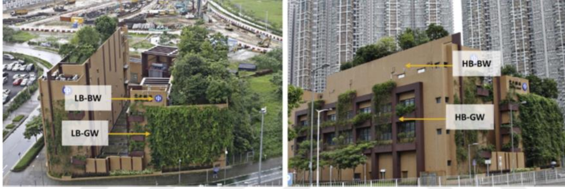
Resim 3.5. Deney duvarları (Lee ve Jim, 2017)
