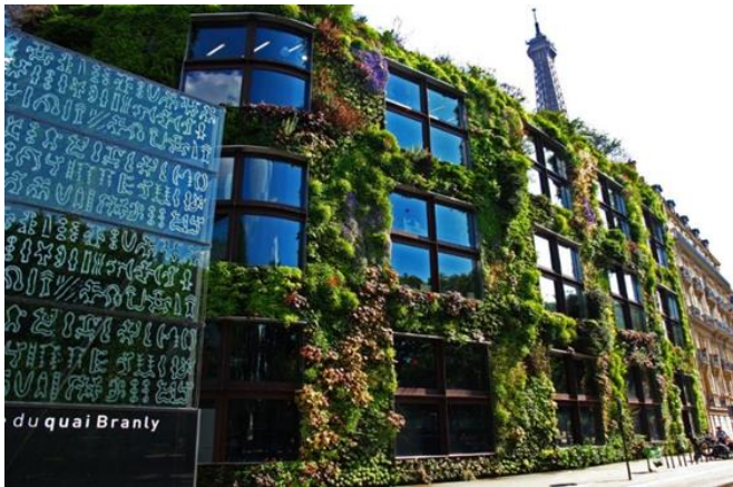
Resim 2.10. Mur Vegetal, Musee du quai Branly, Patrick Blanc (URL-9)
