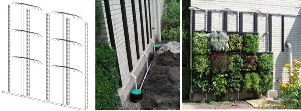
Resim 2.26. Yaşayan cephede sulama sistemi kurulumu (URL-24)
