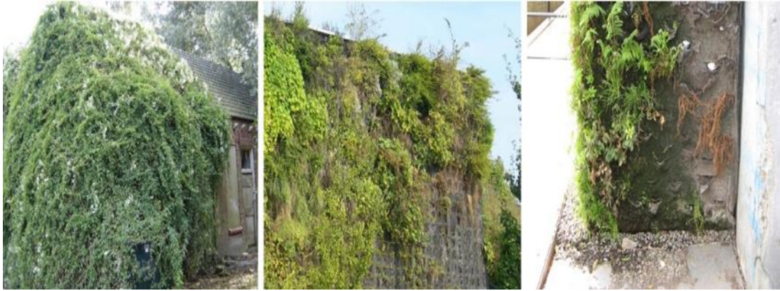
Resim 2.19. Bakım eksikliğinden kontrolsüz yayılmış ve çürümüş bitkiler (Perini, 2011)
