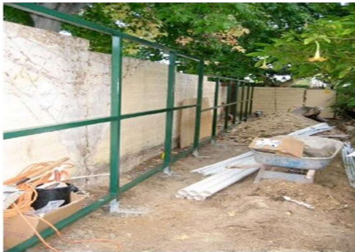
Resim 2.7. Bitkilendirilmiş hasır duvar taşıyıcı sistemi (Aygencel, 2011, 53)
