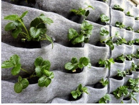
Resim 2.24. Yaşayan cephede bitki taşıyıcı keçe katmanı (URL-22)
