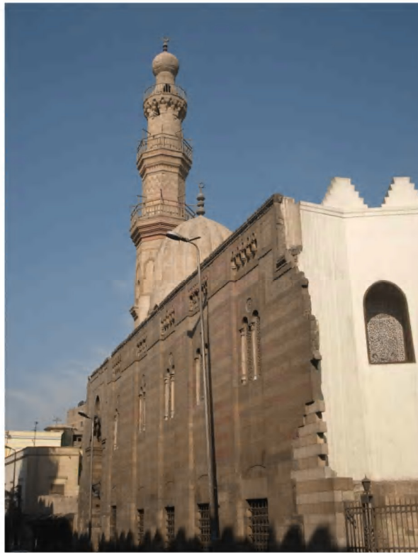
(Res:42) Emir Şeyhu el-Nasrı el-Ömeri Ulu Camii Ana Cephesi. 850
