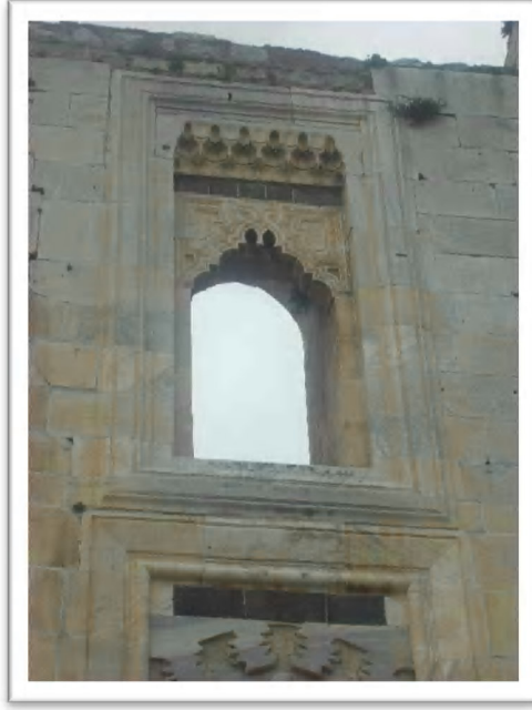
(Res:170) Aydın İsa Bey Ulu caminin Ön Yüz Cephesinde Üst Mukarnaslı Penceresi. 978
