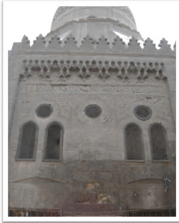
(Res:152) Canı Bey camiinin Kandıyesi. 960
