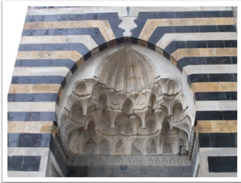
(Res:158) Ramazanoğulları Caminin Taçkapısının Sivri Mukarnasları. 966
