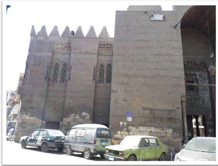
(Res: 14) Tanboğa el-Meradani Camiinin kuzey ana cephesi. 822
