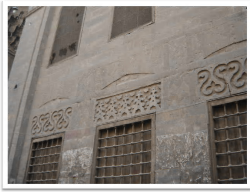
(Res: 73) Cani Bey el-Eşrefi el-Davadar Camiinin Dikdörtgen Demir Lokma Parmaklık Şebekeli Penceresi. 881
