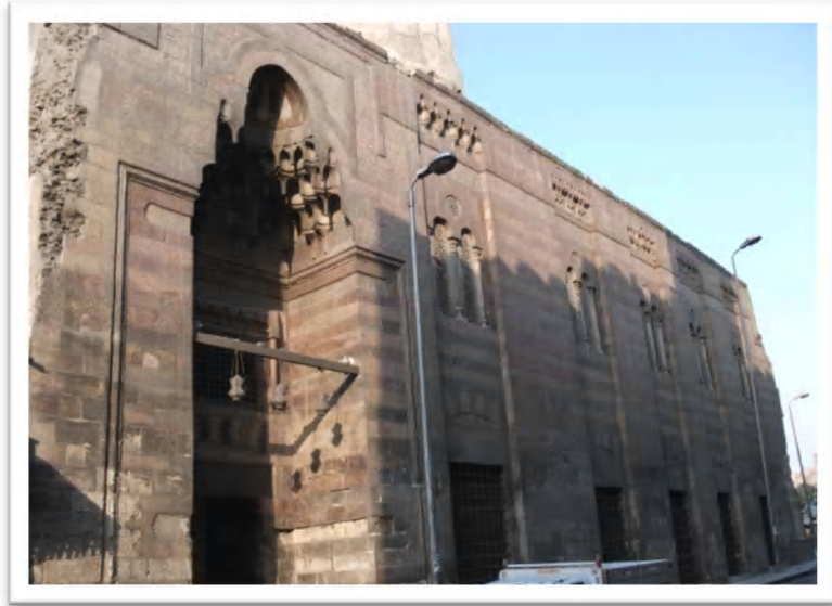
(Res:43) Emir Şeyhu el-Nasrı el-Ömeri Ulu Camiinin Ana Cephesi ve Taçkapısı. 851
