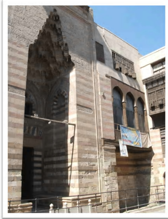
(Res: 62) Sultan Eşref Şaban b. Kalavun Medresesinin Doğu Ana Cephesinin Taçkapısı, Selsebili ve Mektebi. 870
