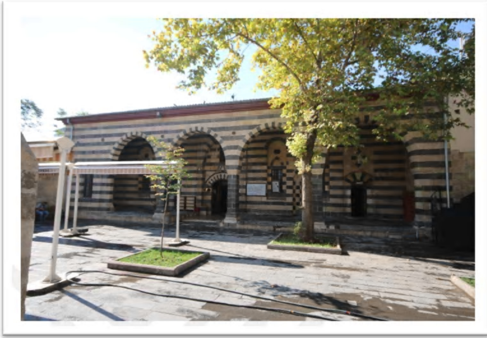
(Res:184) Ağa camii kuzey genel görünüşü. 992
