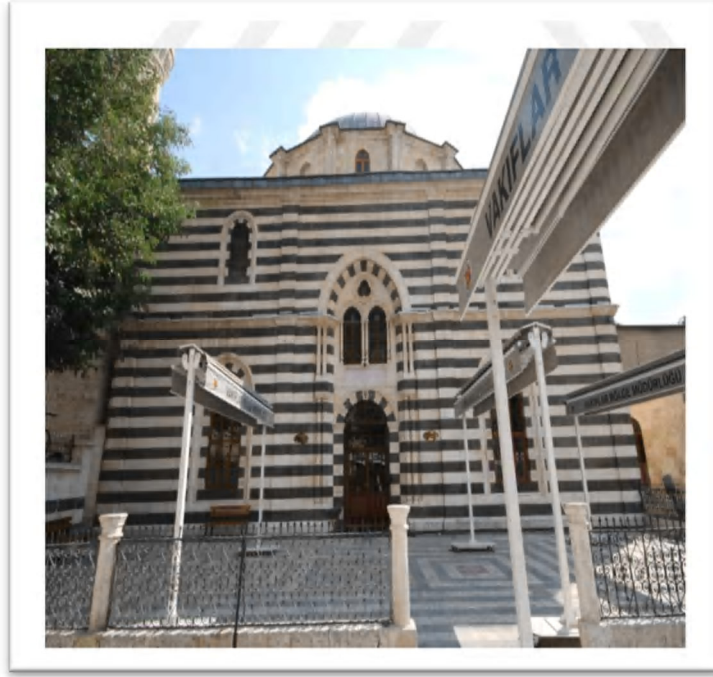
(Res:155) Alaüddevle camii kuzey cephe. 963
