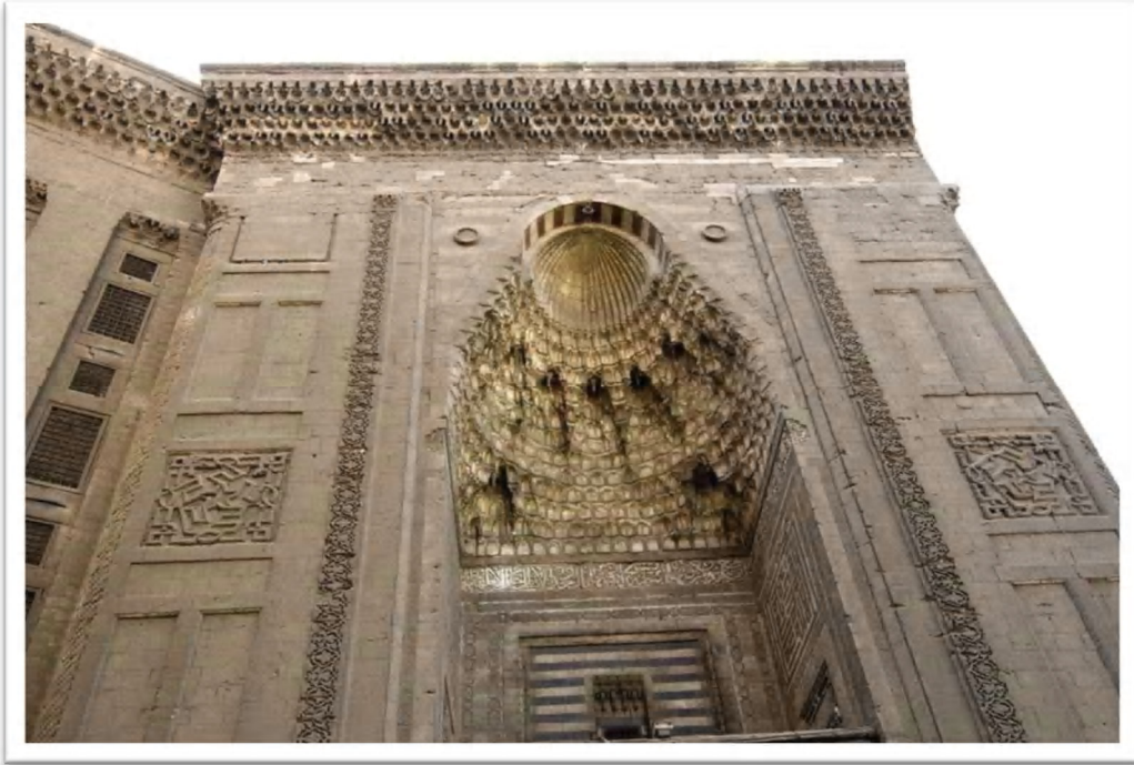
(Res: 57) Sultan Nasır Hasan Camiulmedresesinin Silme, Kavsaralı Mukarnaslı Taçkapısı ve Mukarnaslı Saçağı. 865
