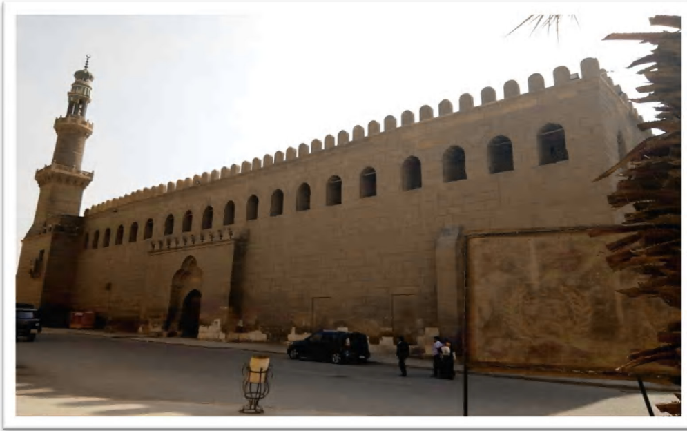
(Res:10) Sultan Nasir Mehmet b. Kalavun Ulu Camiinin Kuzeydoğu Cephesi. 818
