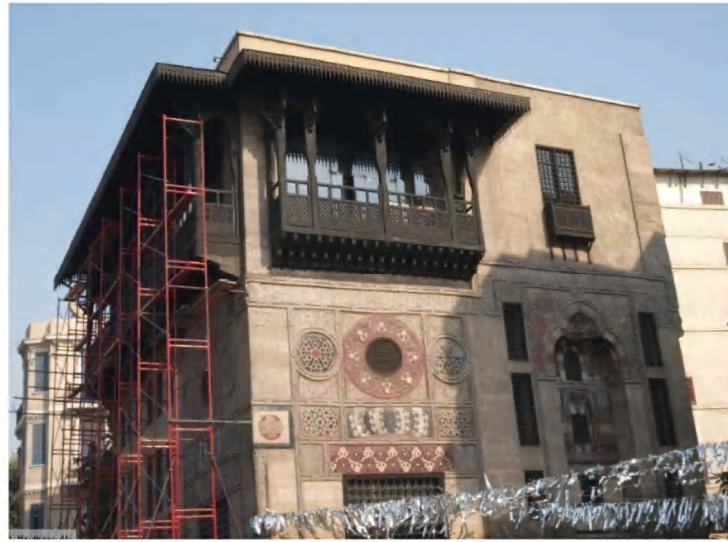
(Res:126) Sultan Kayıtbay müstakil selsebili, ana cephe ve taçkapı. 934
