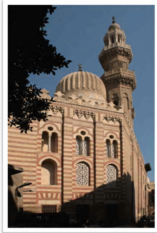
(Res: ) Sultan Eşref Şaban Medresesinin Güneydoğu Cephesi ve Pencereleleri. 868
