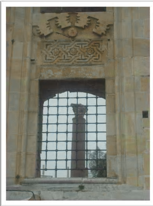
(Res:169) Aydın İsa Bey Ulu caminin Ön Yüz Cephesinde Alt Pencere. 977
