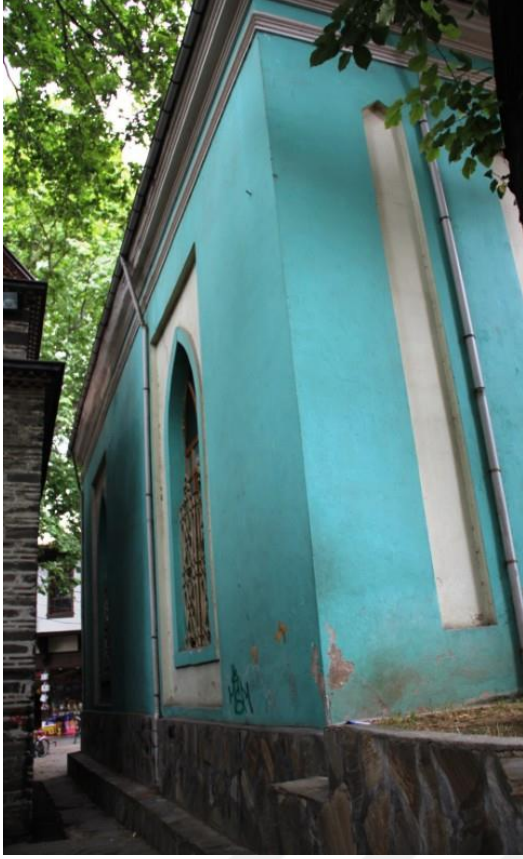
Resim 3. 106. Yıldırım (cuma) camii- güney cephe.
