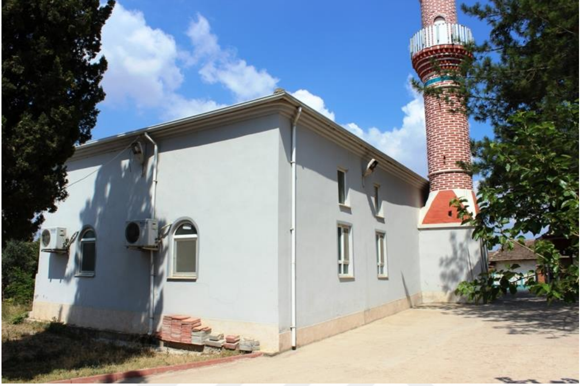
Resim 3. 140. Boğazköy Mahallesi Camii- doğu ve güney cepheler.
