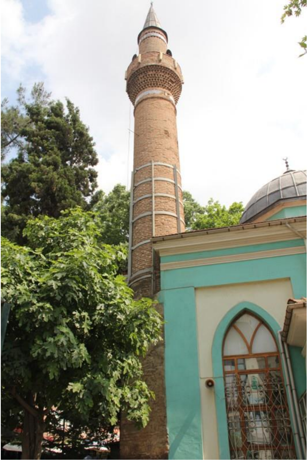
Resim 3. 101. Yıldırım (cuma) camii- minareye kuzeyden bakış.
