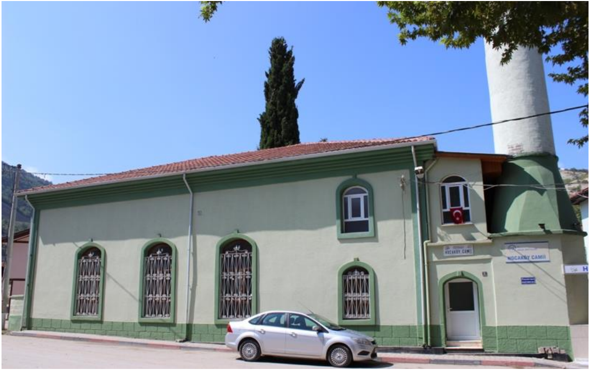
Resim 3. 196. Hocaköy Mahallesi Camii- doğudan çatı ve cepheye bakış.
