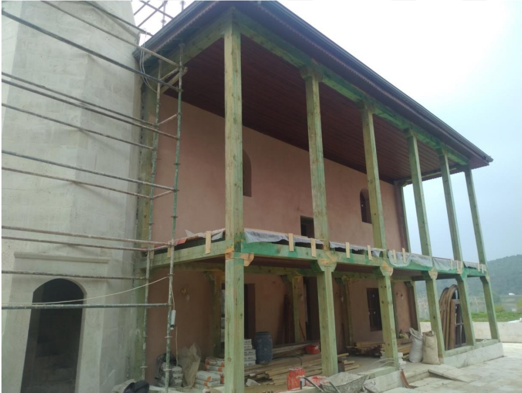
Resim 3. 159. Hamzabey Mahallesi Mehmed Bey Camii- 2018 restorasyonu.
