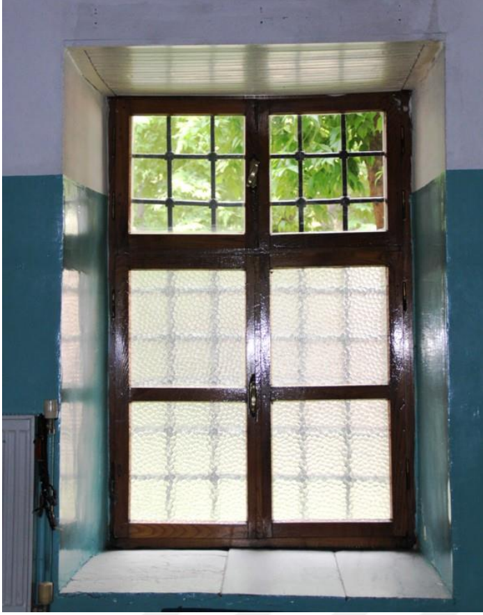
Resim 3. 29. İshak Paşa Camii ahşap çerçevesi pencere.
