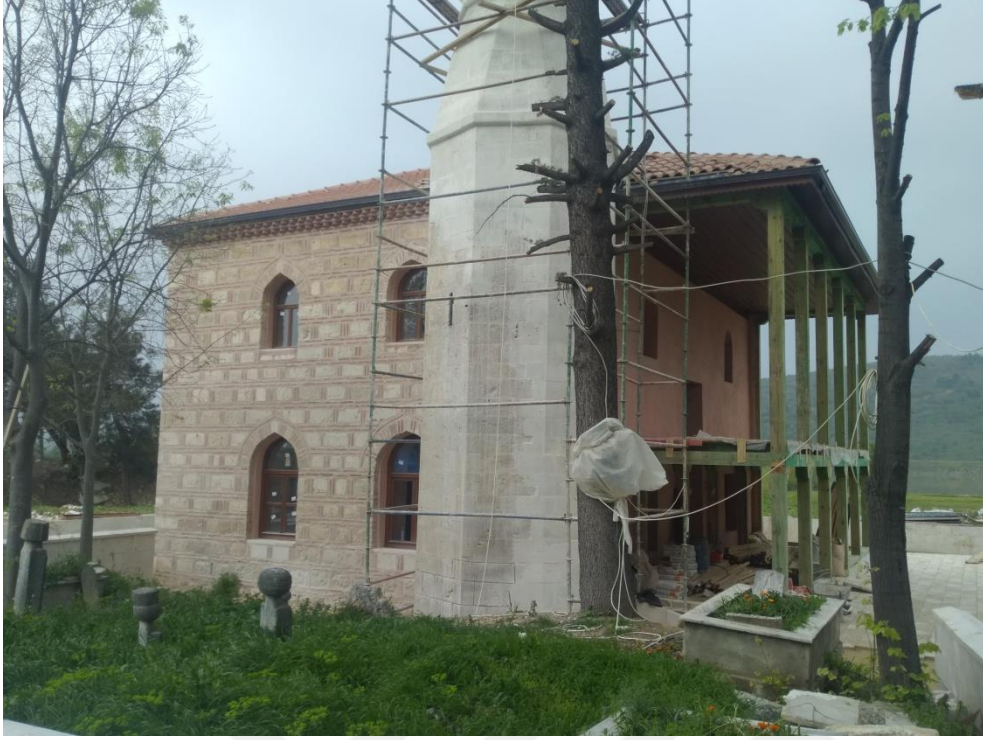
Resim 3. 158. Hamzabey Mahallesi Mehmed Bey Camii- 2018 restorasyonu.
