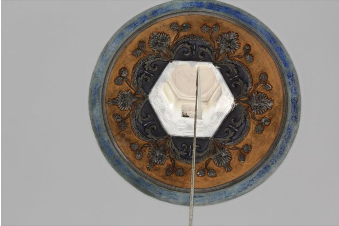
Resim 3. 26. İshak Paşa Camii harime giriş ilk kubbede yer alan alçı malzemedeki mukarnaslı aydınlatma feneri.
