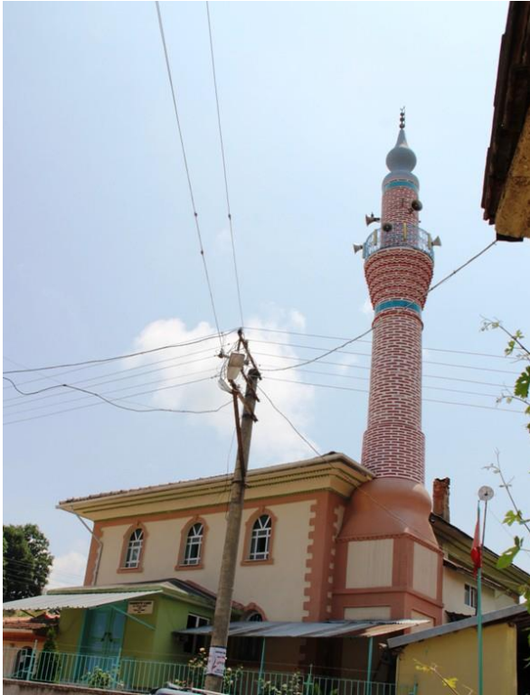
Resim 3. 241. Tahtaköprü Mahallesi Hamidiye Camii minaresi
