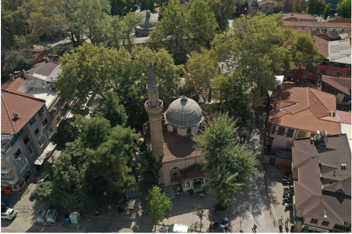
Resim 3. 95. İshak paşa medresesi- derslane mekanı önu kubbeli revaklı bölüm.
