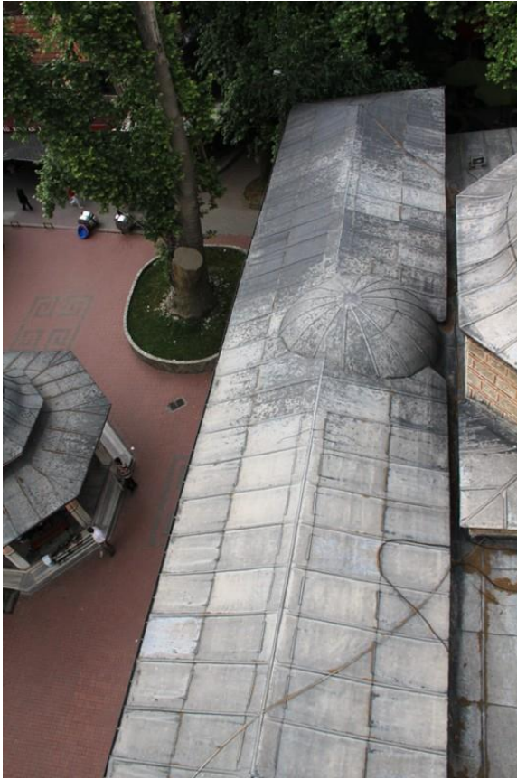
Resim 3. 12. İshak Paşa Camii son cemaat yeri minareden görünüşü.
