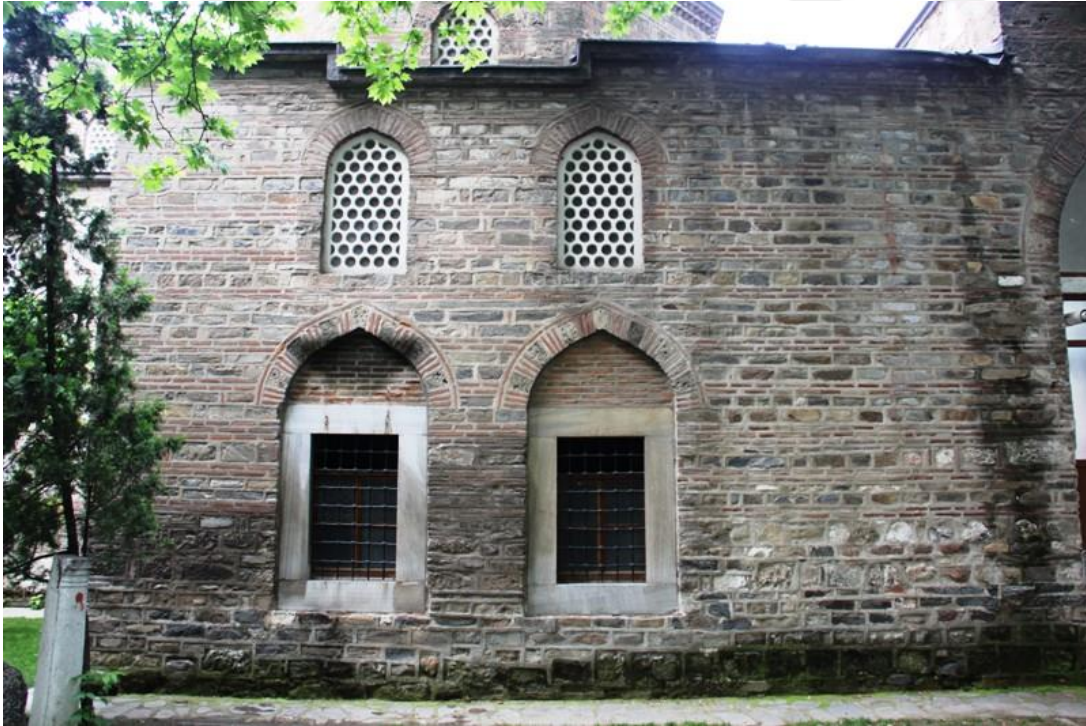
Resim 3. 18. İshak Paşa Camii doğu cepheden bir duvar örgüsünü gösterir kesit.
