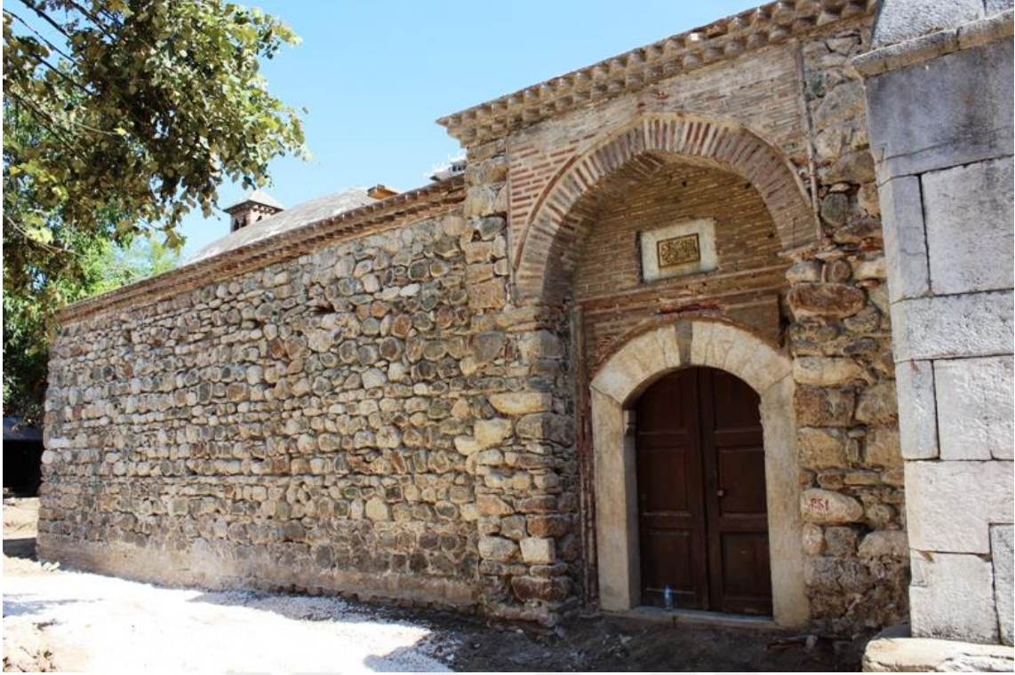
Resim 3. 175. Kurşunlu Mahallesi Hançerli Fatma Sultan Camii- restorasyonu- kuzey cepheden.
