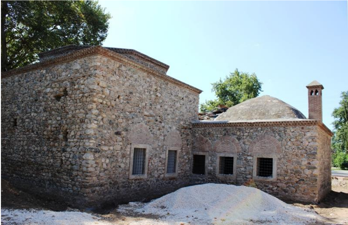
Resim 3. 176. Kurşunlu Mahallesi Hançerli Fatma Sultan Camii- restorasyonu- güneydoğu cepheden.
