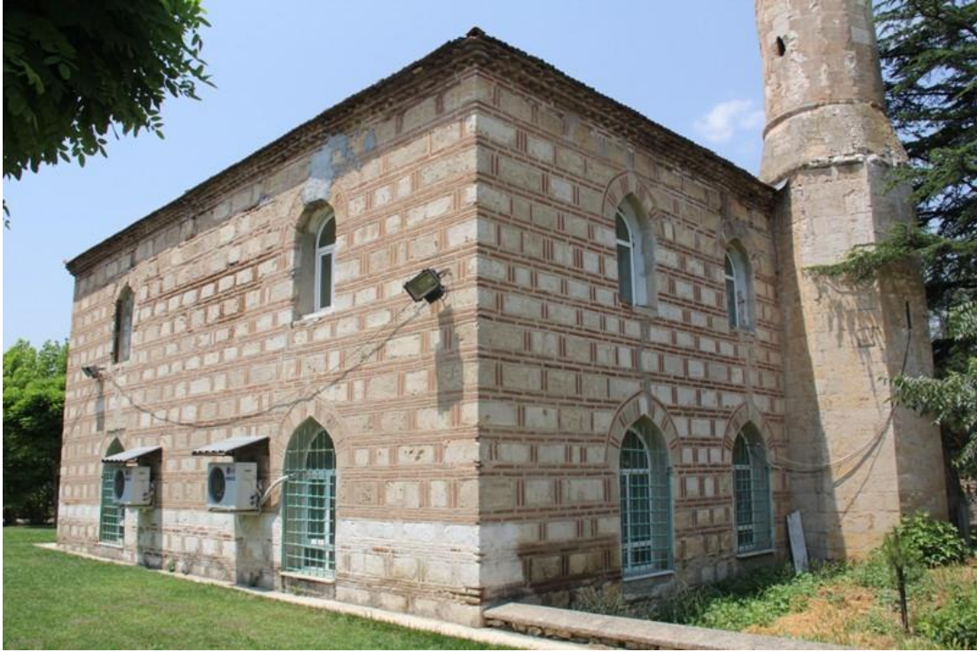
Resim 3. 164. Hamzabey Mahallesi Mehmed Bey Camii- doğu ve güney cephe.
