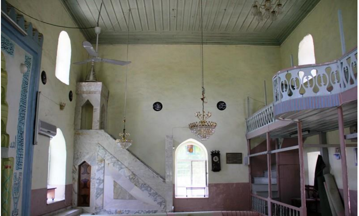
Resim 3. 169. Hamzabey Mahallesi Mehmed Bey Camii- harim batı cepheye bakış.
