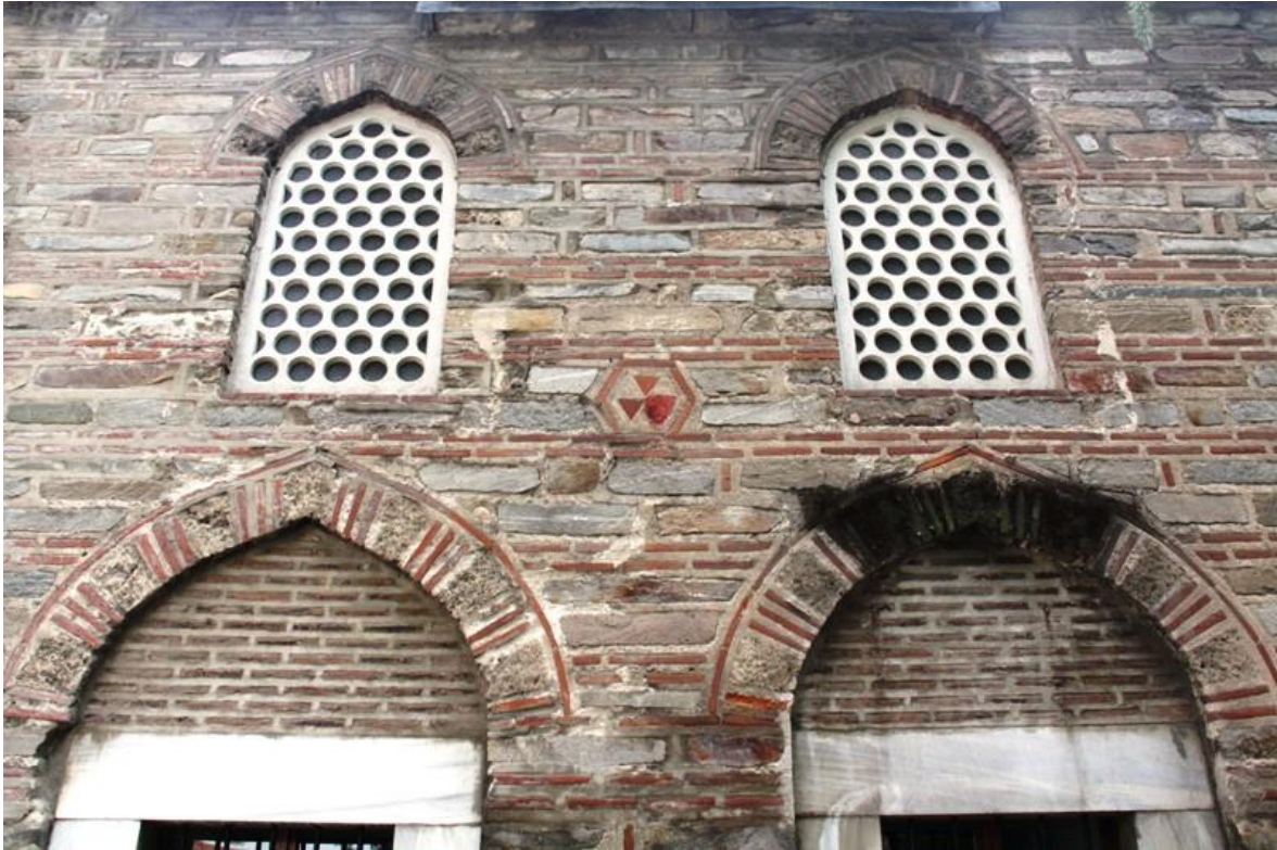
Resim 3. 50. İshak Paşa Camii batı yan kanat cephesi üzerindeki tuğla süsleme.
