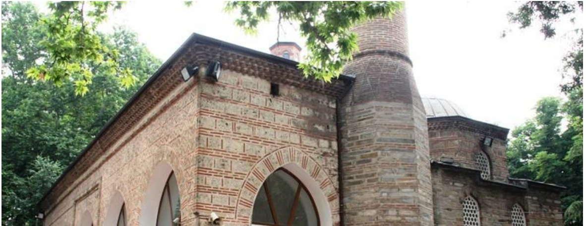
Resim 3. 20. İshak Paşa Camii son cemaat yeri ve kubbede kullanılan saçak.
