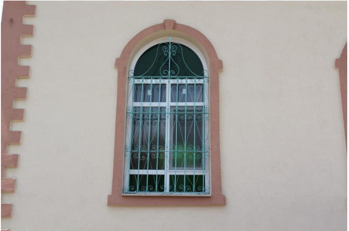
Resim 3. 245. Tahtaköprü Mahallesi Hamidiye Camii- pencere korkulukları.
