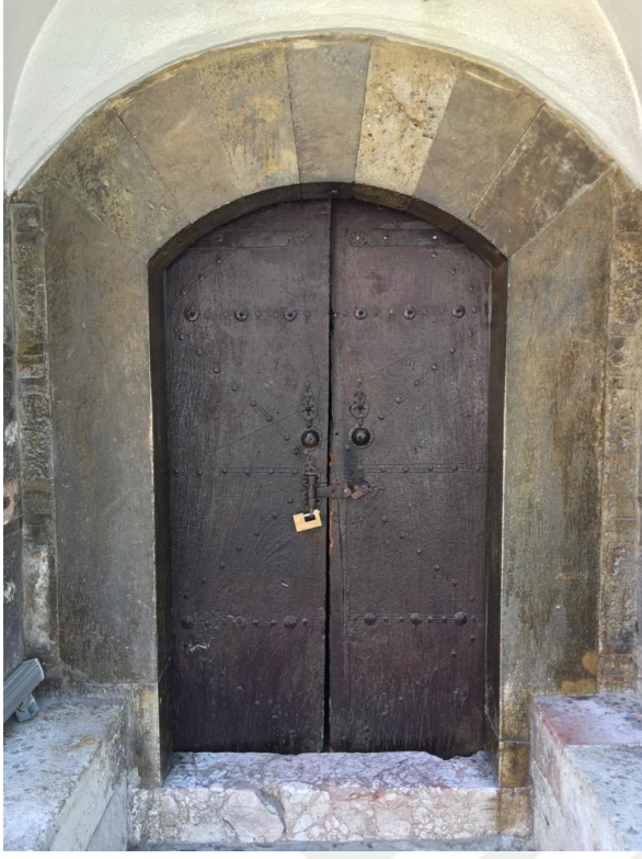
Resim 3. 66. Tacü'n Nisa Sultan Hatun Türbesi ahşap kapı kanatları.
