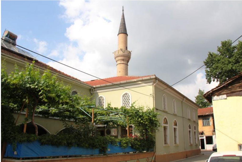
Resim 3. 248. Kasımefendi Camii- Güneybatı Cepheden.
