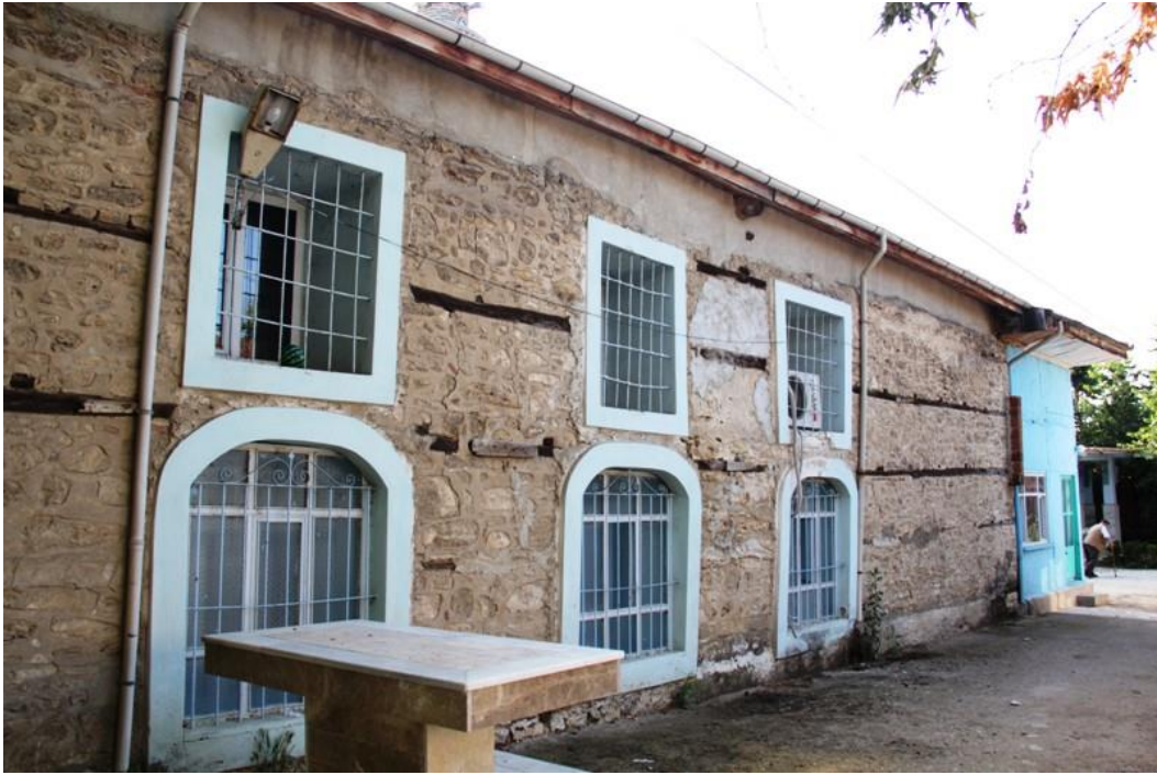
Resim 3. 225. Kulaca Mahallesi Mehmed Bey Camii restorasyon öncesi doğu cephe duvarı.
