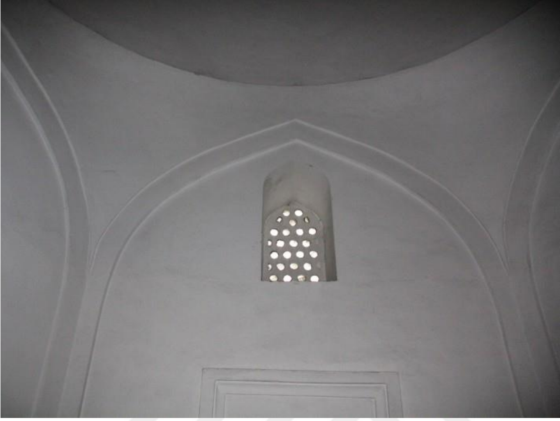
Resim 3. 61. Tacü'n Nisa Sultan Hatun Türbesi kubbeye geçiş elemanları.
