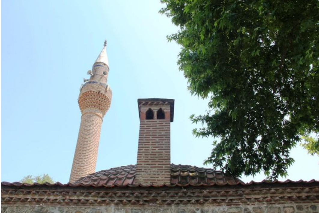
Resim 3. 191. Kurşunlu Mahallesi Hançerli Fatma Sultan Camii- kirpi saçak formlar- batı cepheden.
