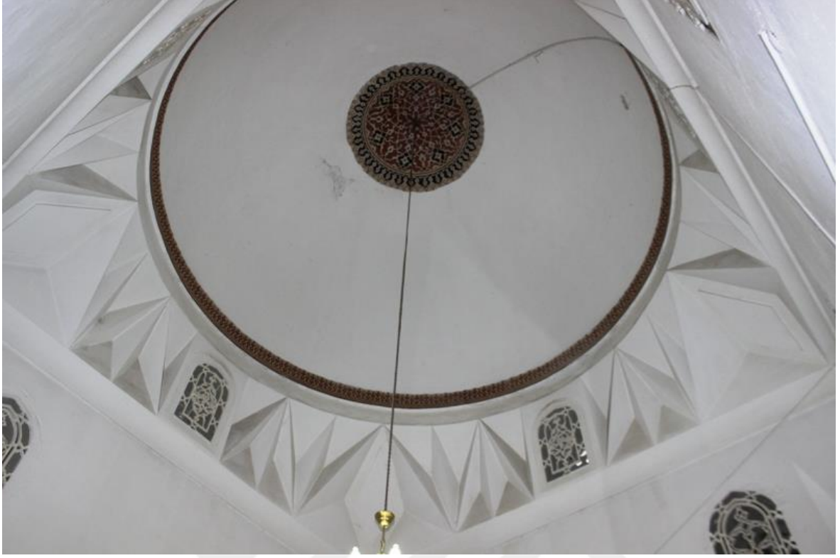
Resim 3. 92. İshak paşa medresesi dersane kubbesi.
