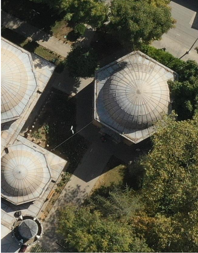
Resim 3. 59. Tacü'n Nisa Sultan Hatun Türbesi hava görüntüsü.
