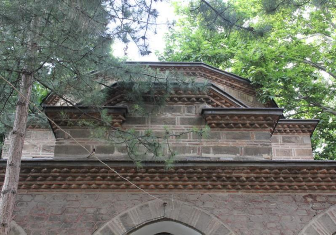
Resim 3. 79. İshak Paşa Medresesi derslane önü ve derslane mekanı kubbelerinin kasnakları.
