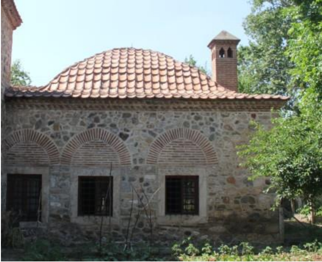
Resim 3. 190. Kurşunlu Mahallesi Hançerli Fatma Sultan Camii tuğla bacası.
