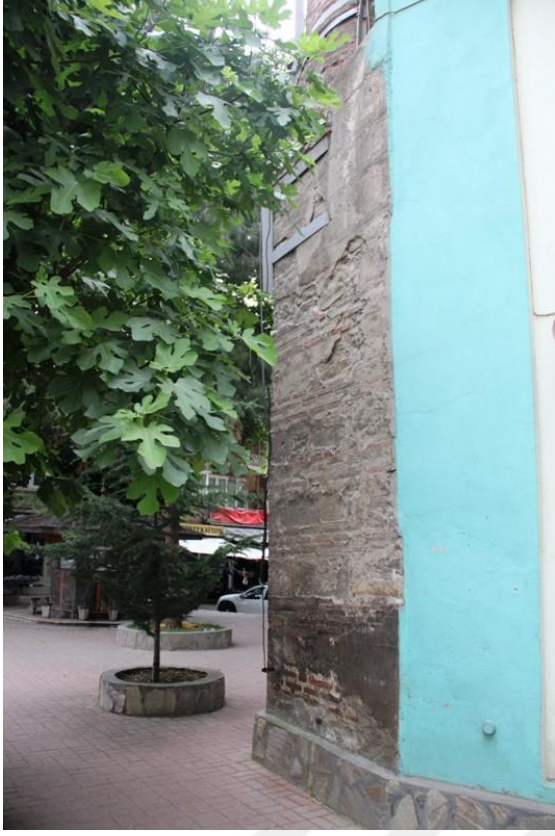
Resim 3. 104. Yıldırım (cuma) camii- minare kaidesi.
