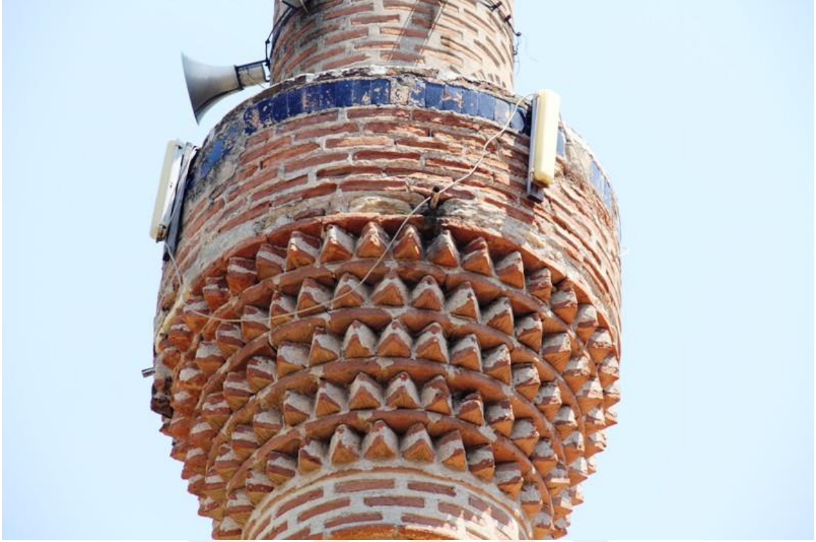
Resim 3. 188. Kurşunlu Mahallesi Hançerli Fatma Sultan Camii minaresi şerefesi.
