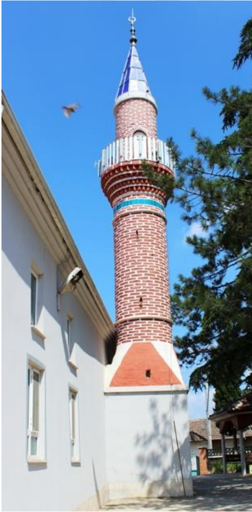
Resim 3. 146. Boğazköy Mahallesi Camii- minaresi.
