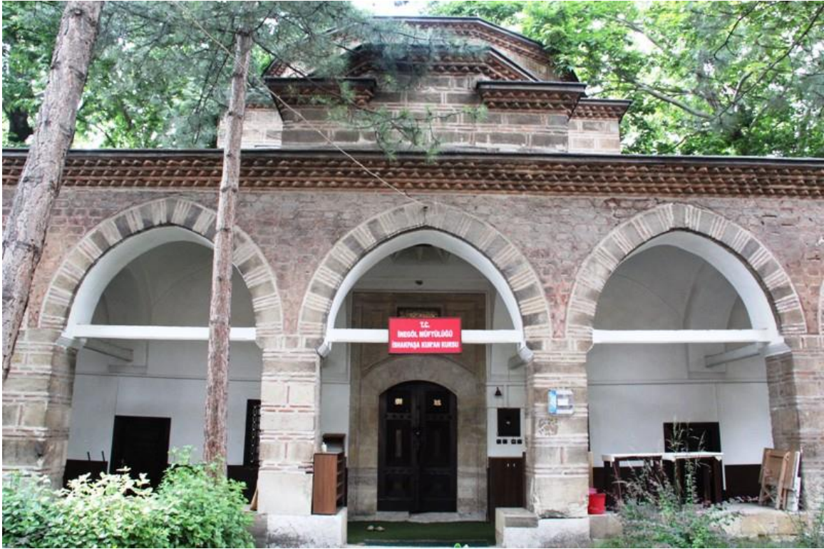
Resim 3. 85. İshak Paşa Medresesi revaklı bölüm tuğla süslemeleri genel görünüm.
