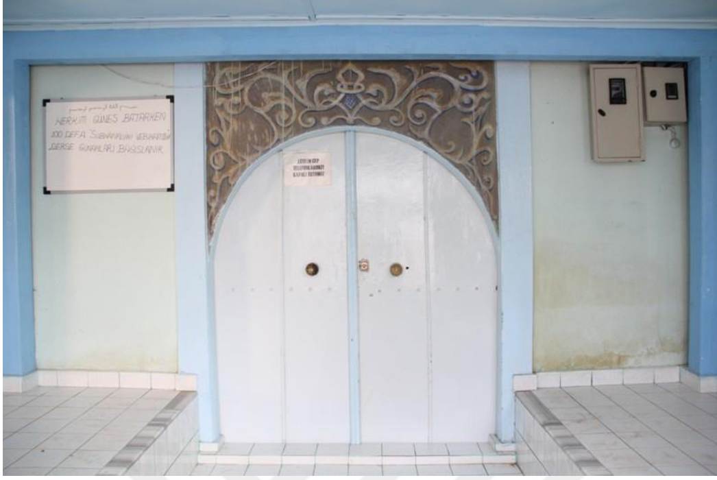
Resim 3. 231. Kulaca Mahallesi Mehmed Bey Camii restorasyon öncesi harime giriş kapısı ve süslemeleri.
