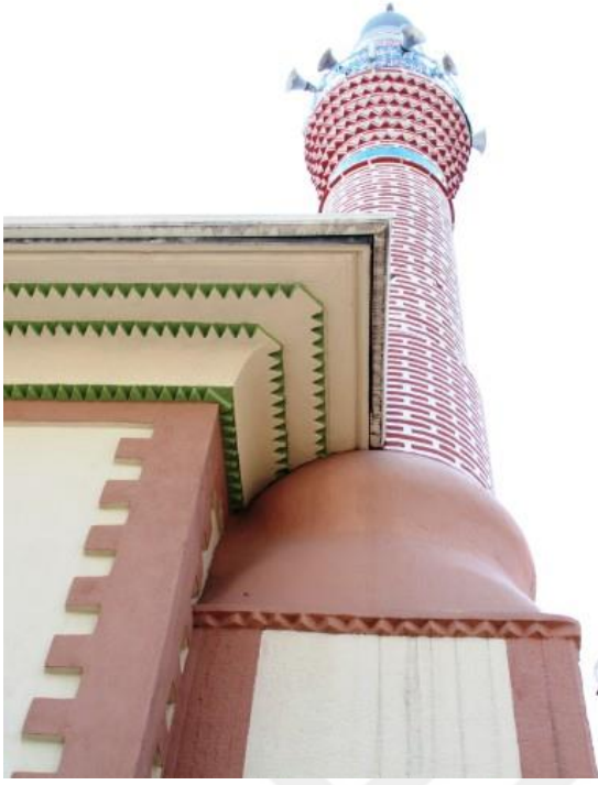
Resim 3. 242. Tahtaköprü Mahallesi Hamidiye Camii minaresi.
