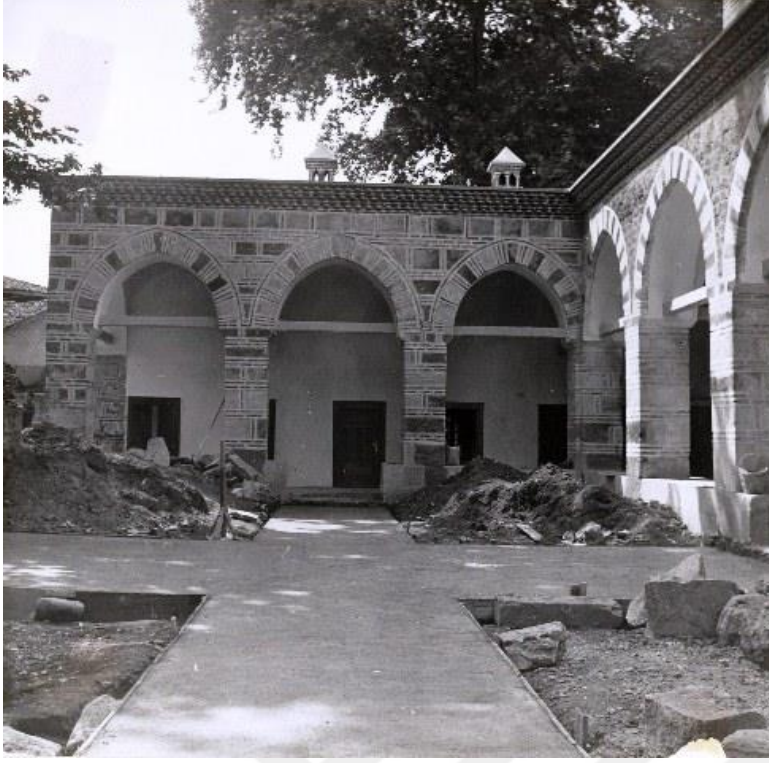
Resim 3. 76. İshak Paşa Medresesi'nin restorasyonu- Vakıflar Genel Müdürlüğü Arşivi.
