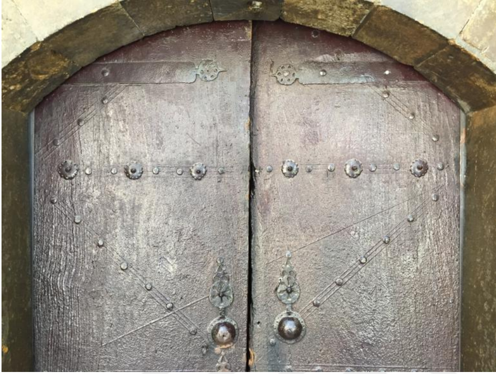
Resim 3. 68. Tacü'n Nisa Sultan Hatun Türbesi- ahşap kapı kanatları süsleme detayları.
