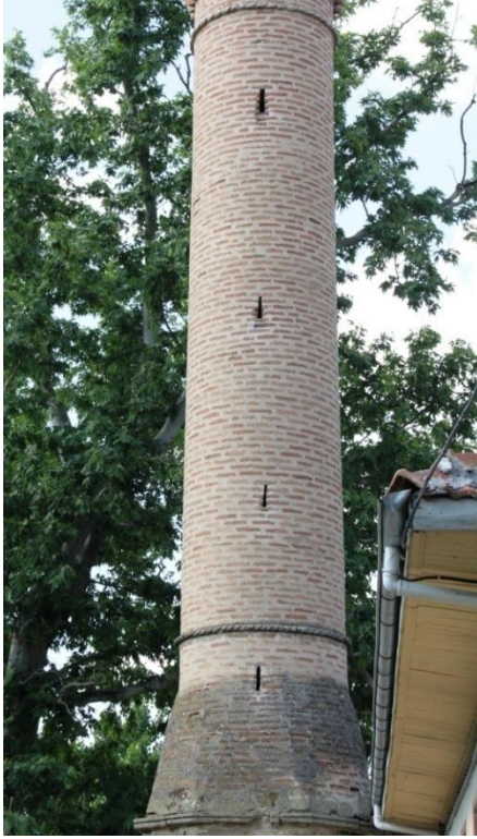
Resim 3. 214. Şipali Mahallesi İvaz Çelebi Camii-minare detayı.
