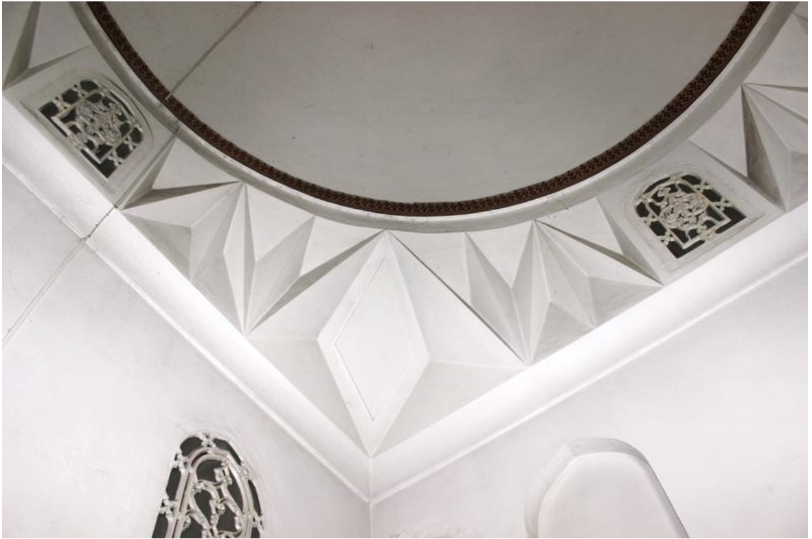
Resim 3. 93. İshak paşa medresesi- dersane kubbesine geiş elemanları.
