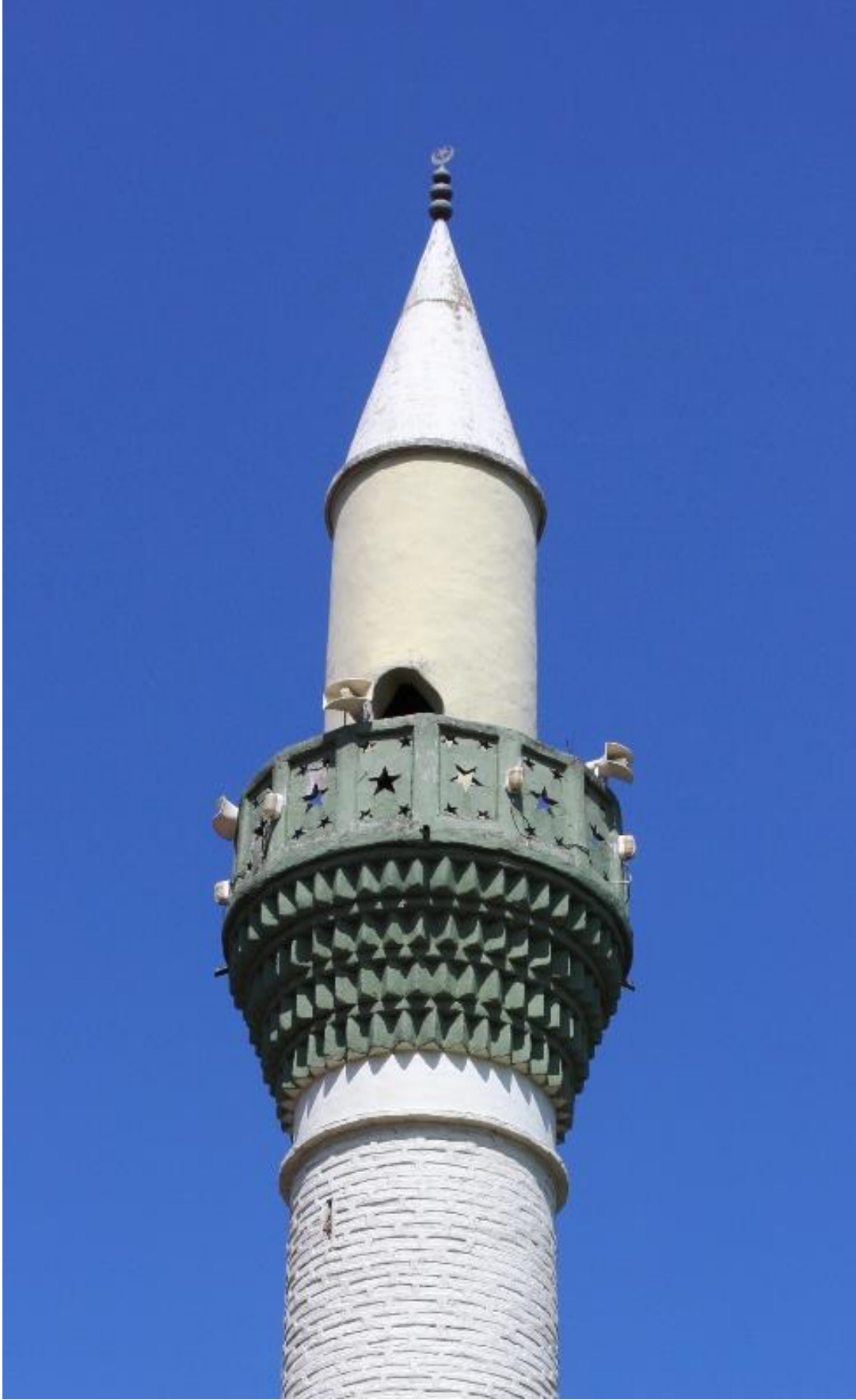
Resim 3. 209. Hocaköy Mahallesi Camii Minaresinden Detaylar.
