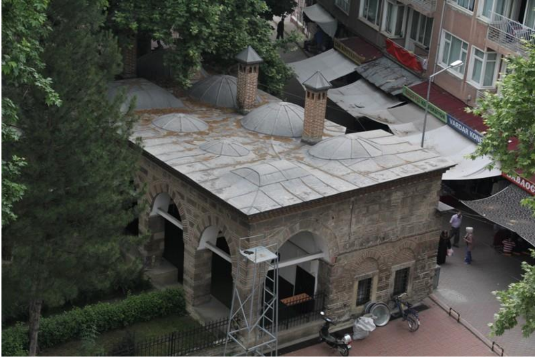
Resim 3. 81. İshak Paşa Medresesi doğu kanadındaki odaların örtü sistemi ve bacaları.
