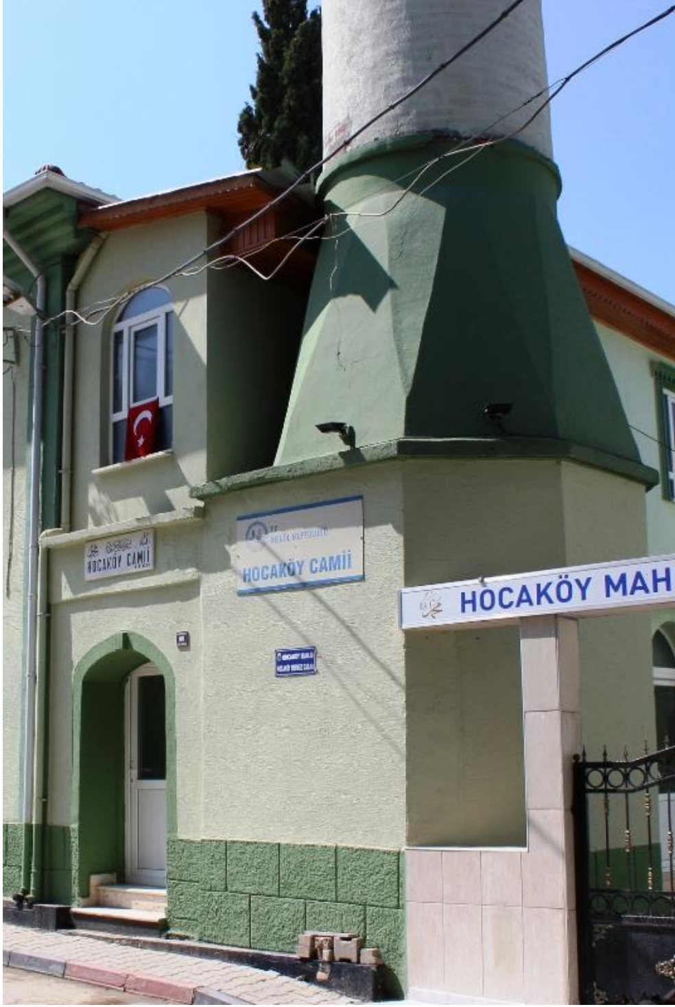
Resim 3. 208. Hocaköy Mahallesi Camii minaresi-kaide ve pabuç.
