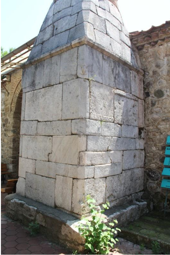
Resim 3. 187. Kurşunlu Mahallesi Hançerli Fatma Sultan Camii minaresi kaide ve pabuç bölümü.
