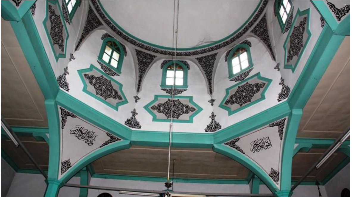
Resim 3. 111. Yıldırım (Cuma) Camii- Sekizgen Kasnaklı Kubbeeye Geçiş Elemanları ve Kubbeden Kesit.
