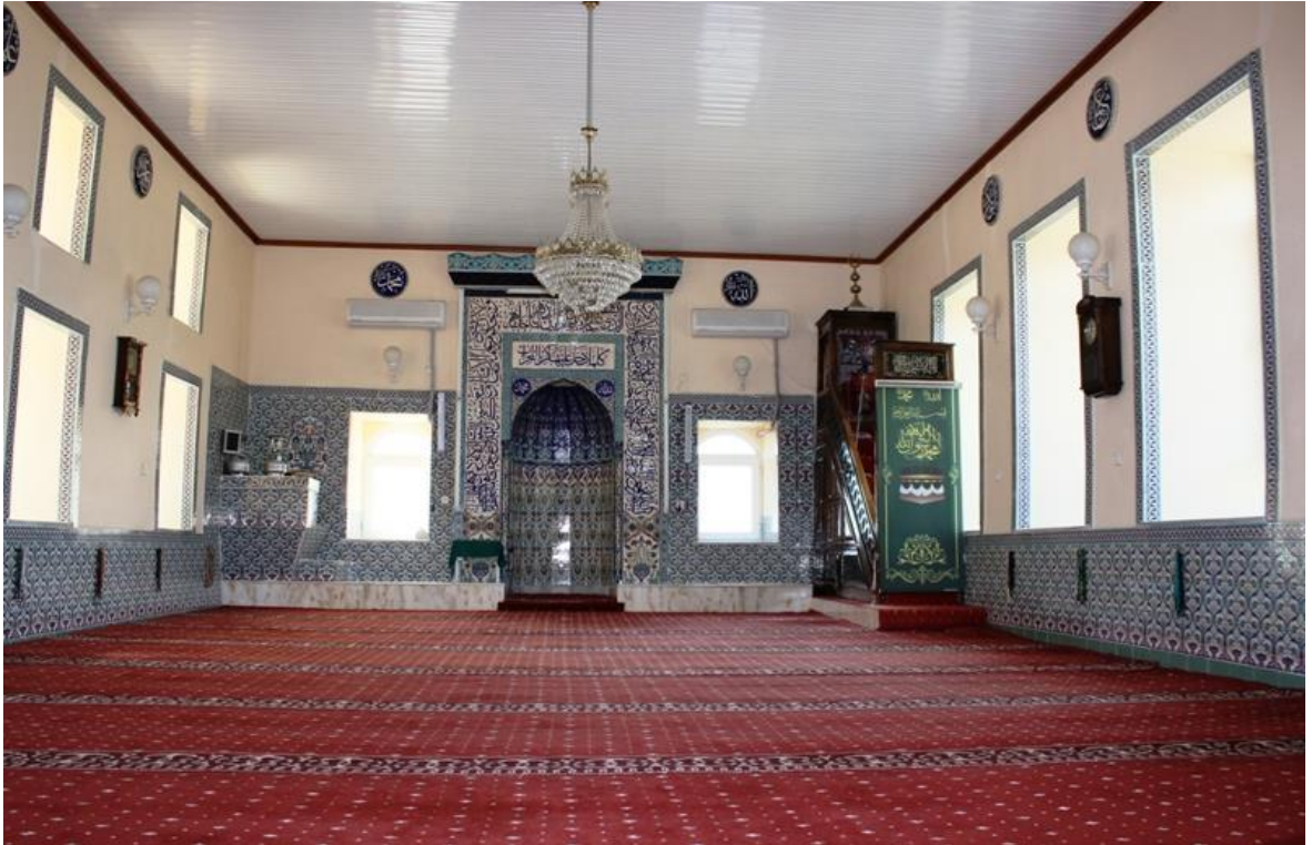
Resim 3. 144. Boğazköy Mahallesi Camii- harim mekanı- tavan.
