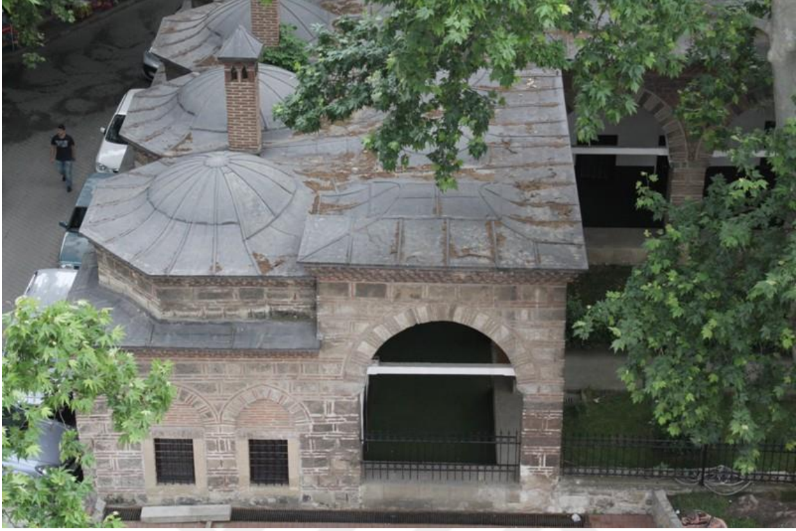
Resim 3. 80. İshak Paşa Medresesi batı kanadındaki odaların örtü sistemi ve bacaları.
