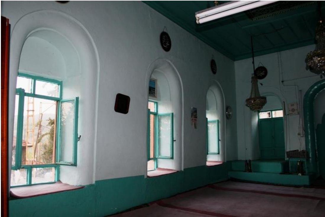
Resim 3. 153. Çayyaka mahallesi camii- pencere hattı doğu cephe duvarı.
