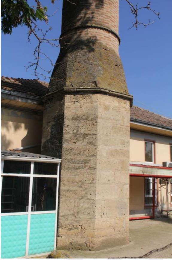
Resim 3. 213. Şipali Mahallesi İvaz Çelebi Camii minaresi- kaidesi ve pabuç bölümü.
