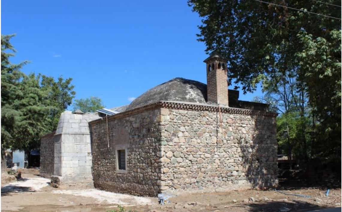
Resim 3. 174. Kurşunlu Mahallesi Hançerli Fatma Sultan Camii- restorasyonu- kuzeybatı cepheden.
