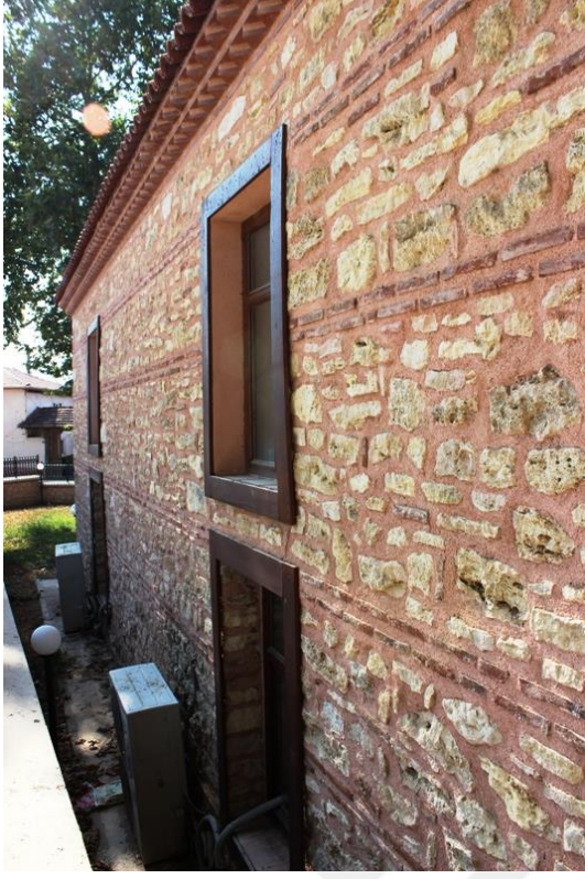
Resim 3. 220. Kulaca Mahallesi Mehmed Bey Camii güney cephesi.
