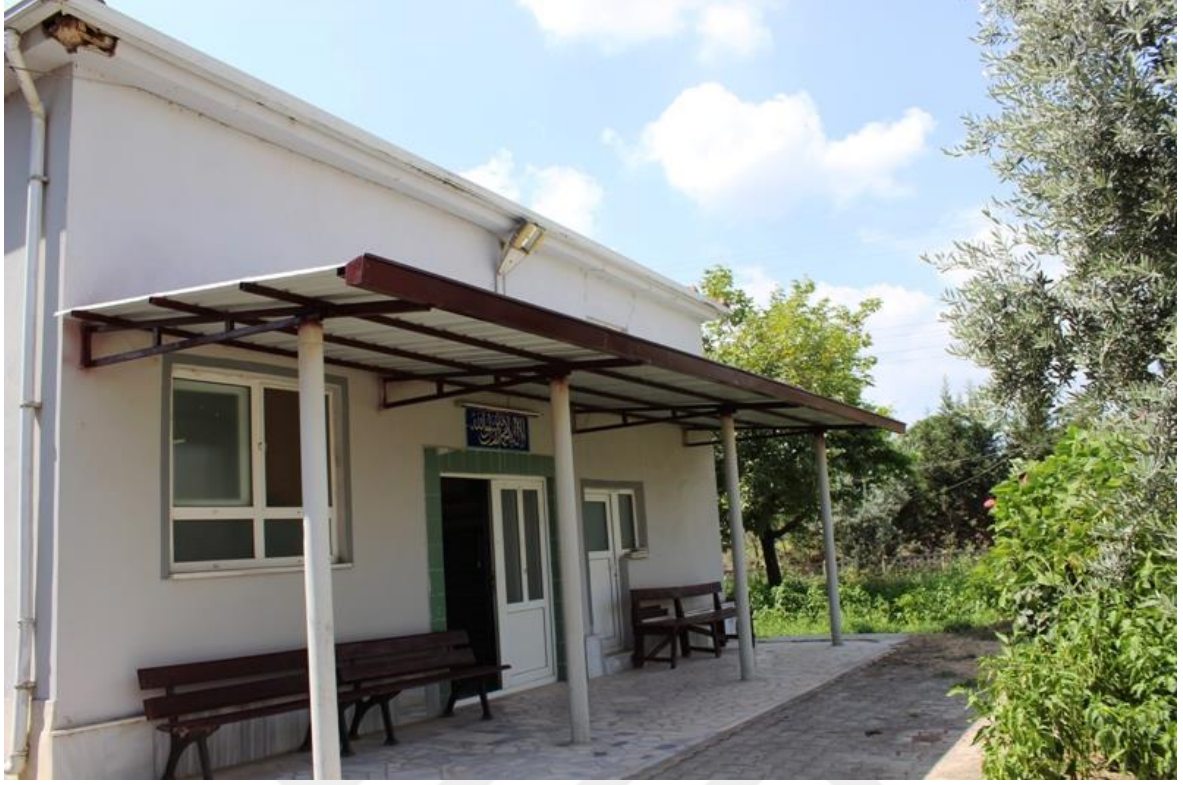
Resim 3. 138. Boğazköy Mahallesi Camii- kuzey cephe.
