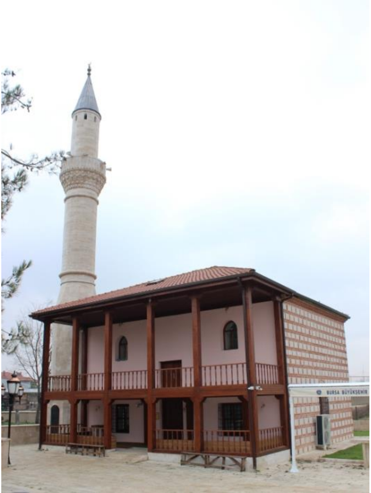
Resim 3. 160. Hamzabey Mahallesi Mehmed Bey Camii- 2018 restorasyonu.
