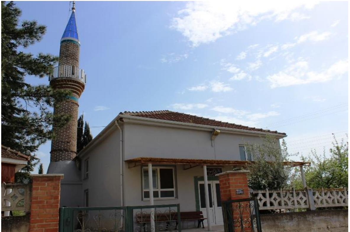
Resim 3. 137. Boğazköy Mahallesi Camii- kırma çatı örtüsü- kuzeyden görünüm.
