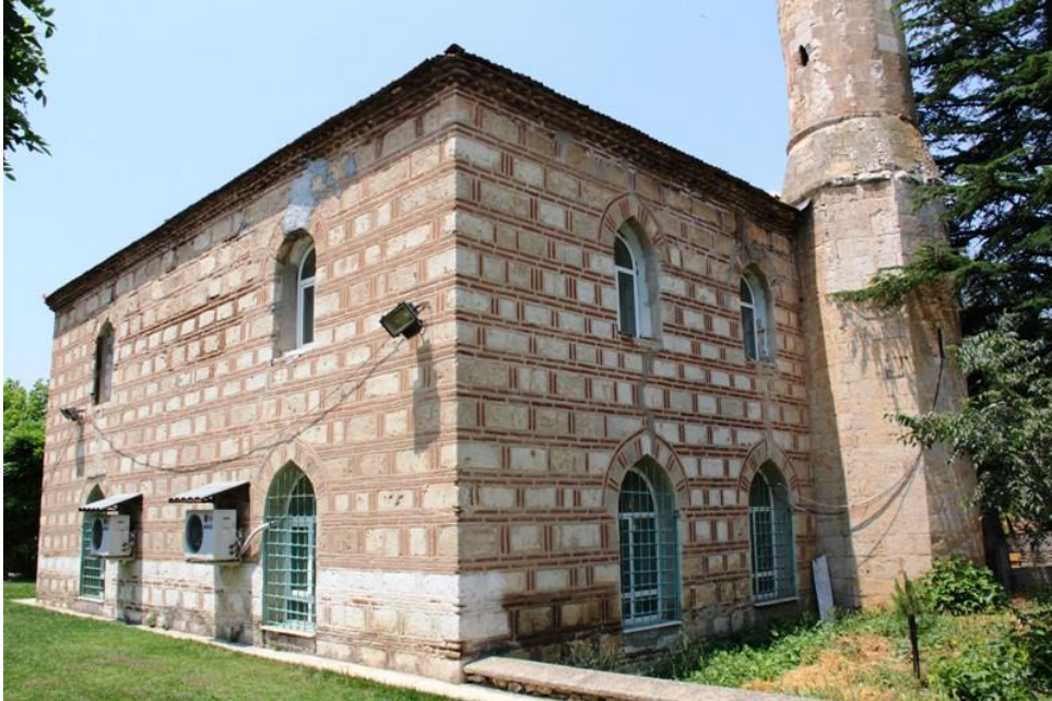
Resim 3. 157. Hamzabey Mahallesi Mehmed Bey Camii- dođu ve gney cephe duvarları.
