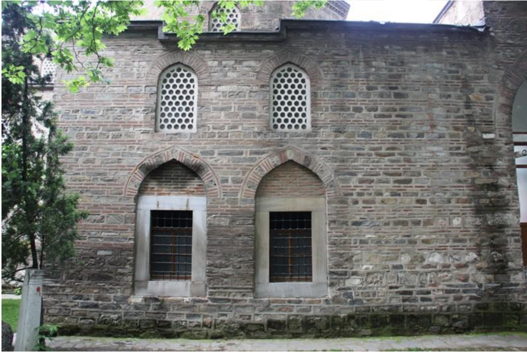
Resim 3. 14. Cami kuzeydoğu cepheden pencere hattı.
