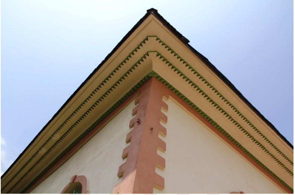
Resim 3. 246. Tahtaköprü Mahallesi Hamidiye Camii-saçak ve cephe kesişimlerinde yer alan süslemelerden bir bölüm.
