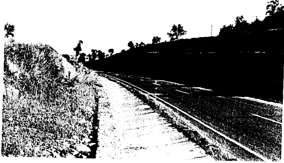
Foto:VII/12-Havza-Vezirköprü Karayolu'nun 20+500 km.sindeki kademeli yarma yamacı ve koruyucu duvar kesiti arkasındaki granüler dolgunun enine konumdaki görünümü.
