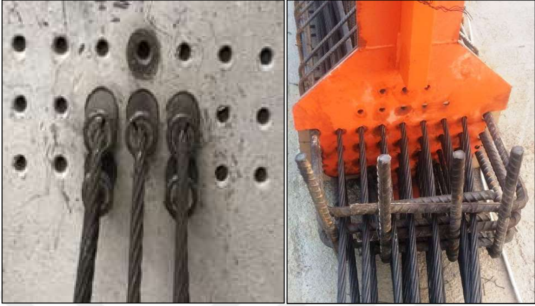
Şekil 4.6. Öngerilme halatları, çene aparatları ve öngerilme halat yerleşim plakası
