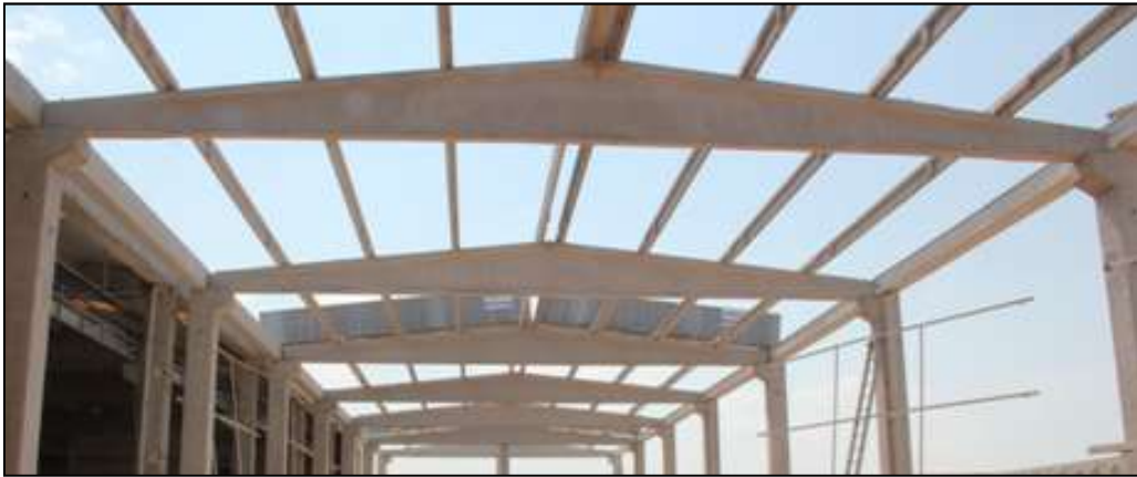
Şekil 3.3. Prefabrik makas ve aşık kirişi
