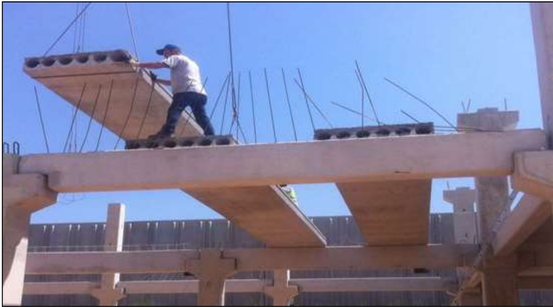
Şekil 3.16. Öngerilmeli boşluklu döşeme montajı
