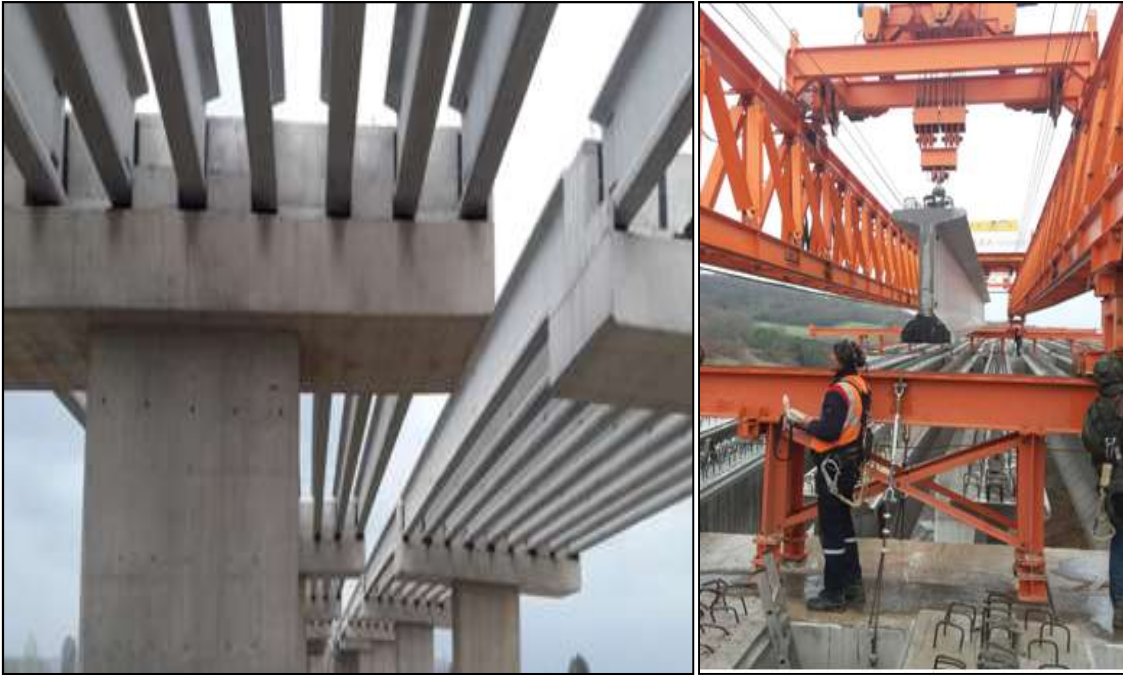
Şekil 3.6. Prefabrik köprü kirişleri, a)Montajı tamamlanmış kirişler, b)Montaj aşaması
