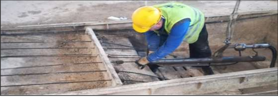
Şekil 3.9. Öngermeli boşluklu döşemenin halatlarını germe aşaması
