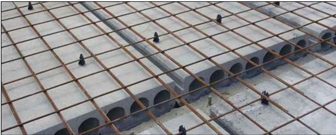
Şekil 3.17. Öngerilmeli boşluklu döşeme üzerine hasır çelik yerleştirilmesi
