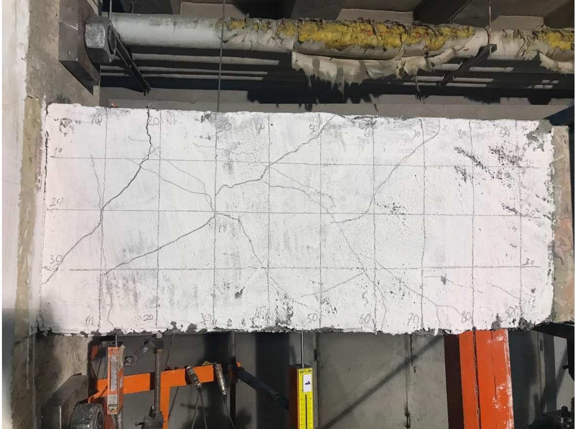
Resim 4.21. HPBC numunesi 1. çevrim sonu çatlak görüntüsü
