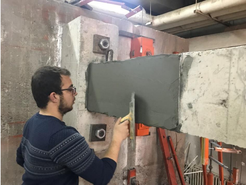
Resim 4.2. Sıva uygulanmış betonarme kiriş
