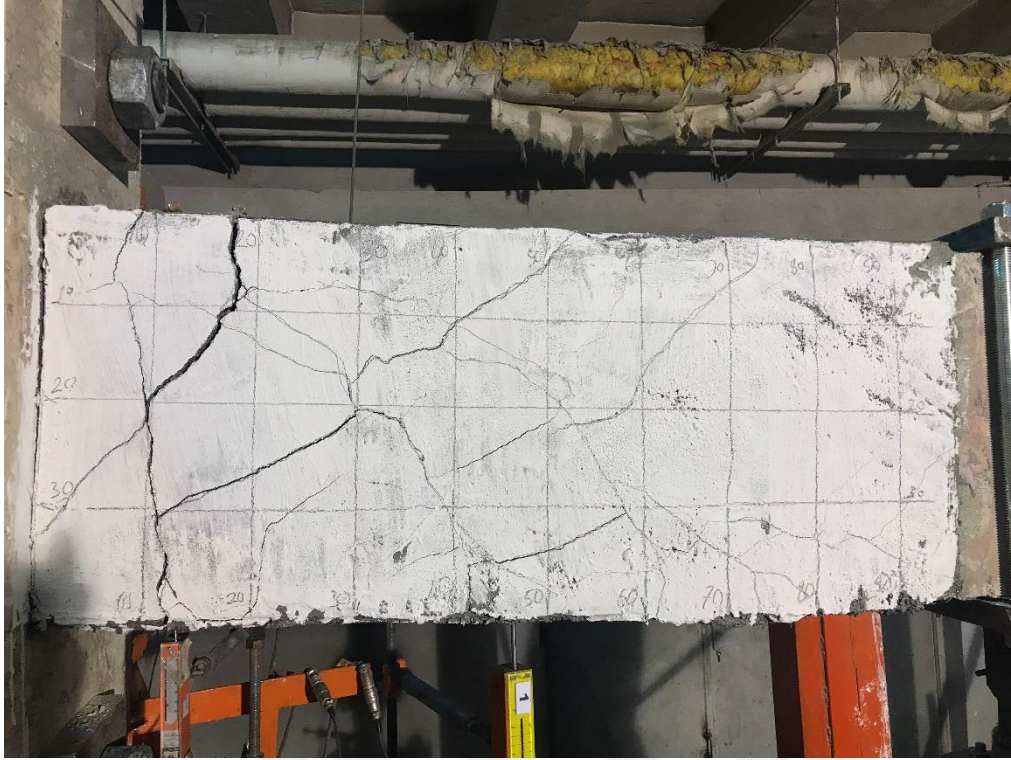
Resim 4.22. HPBC numunesi kablo kesilmeden önce çatlak görüntüsü
