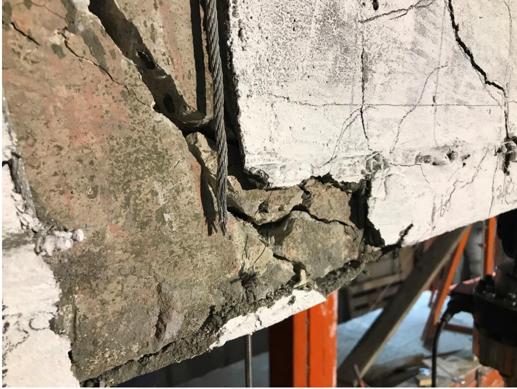
Resim 4.19. HPL numunesi kopan çelik kablo
