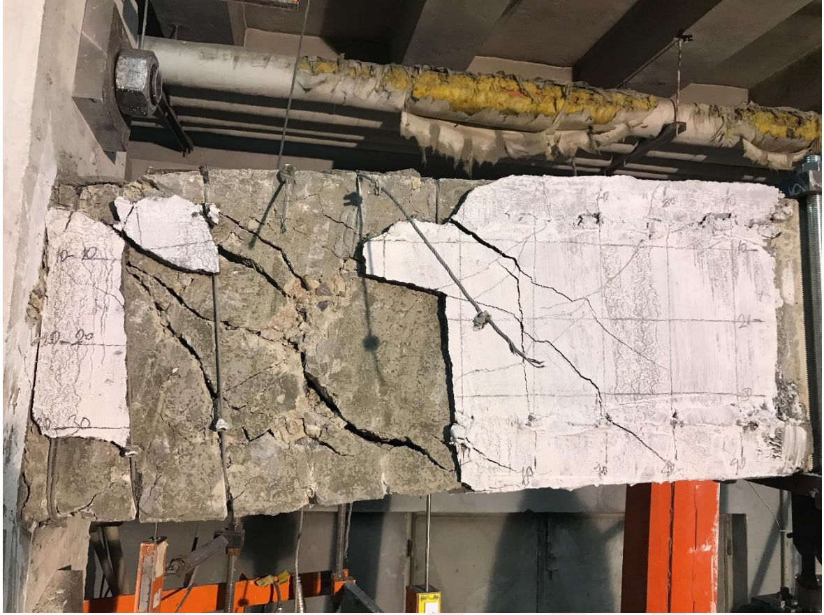
Resim 4.13. MPLC numunesi kopan çelik kablo
