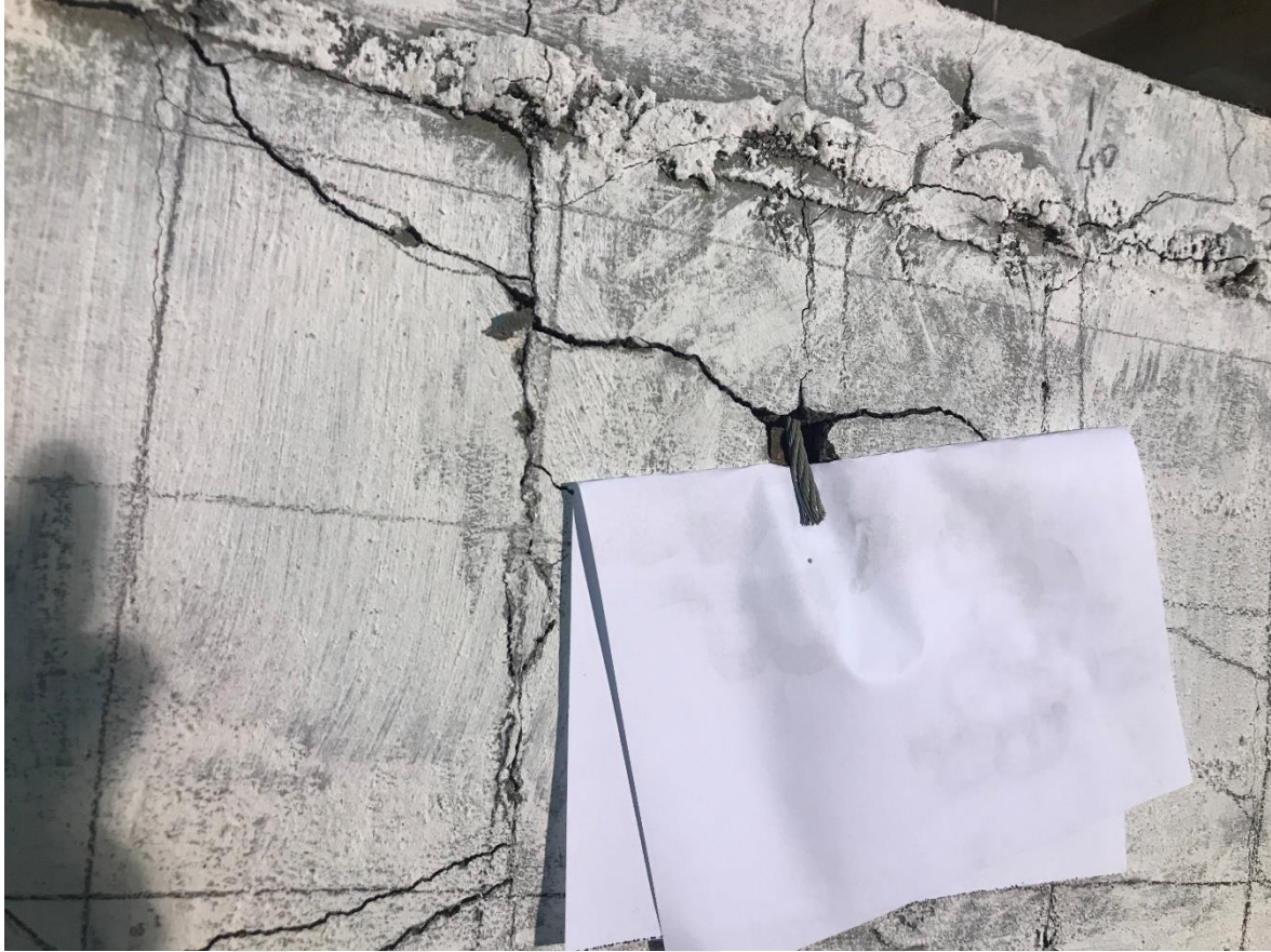
Resim 4.26. HPLC numunesi kesilen kablo görüntüsü
