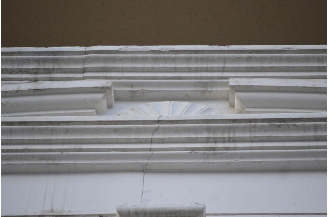
Fotoğraf 35: Eski Sağlık Müdürlüğü Binası 3, saçak kısmı.
