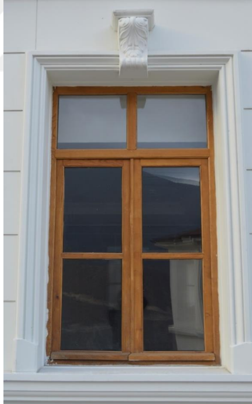
Fotoğraf 15: Eski Sağlık Müdürlüğü Binası, pencere.
