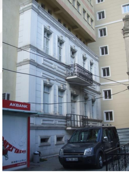
Fotoğraf 30: Eski Sağlık Müdürlüğü Binası 2, güneyden görünüşü.
