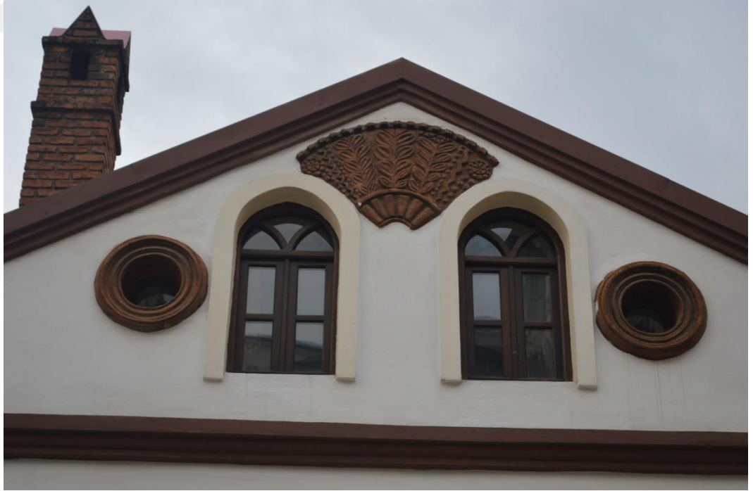
Fotoğraf 25: Eski Askerlik Şubesi Binası, çatı katı, kuzeyden görünüş.
