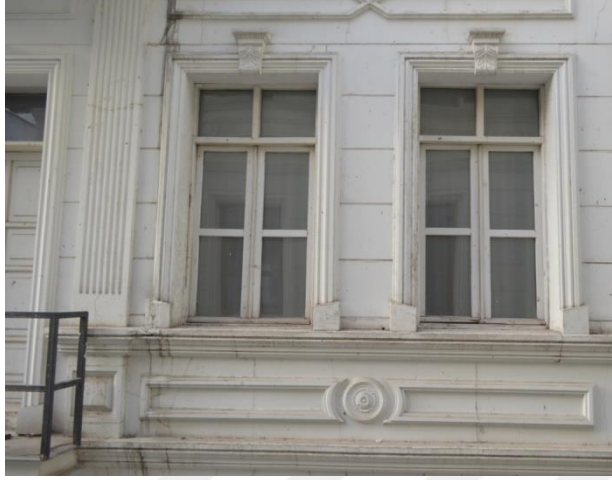
Fotoğraf 31: Eski Sağlık Müdürlüğü Binası 2, pencere ve pilaster.
