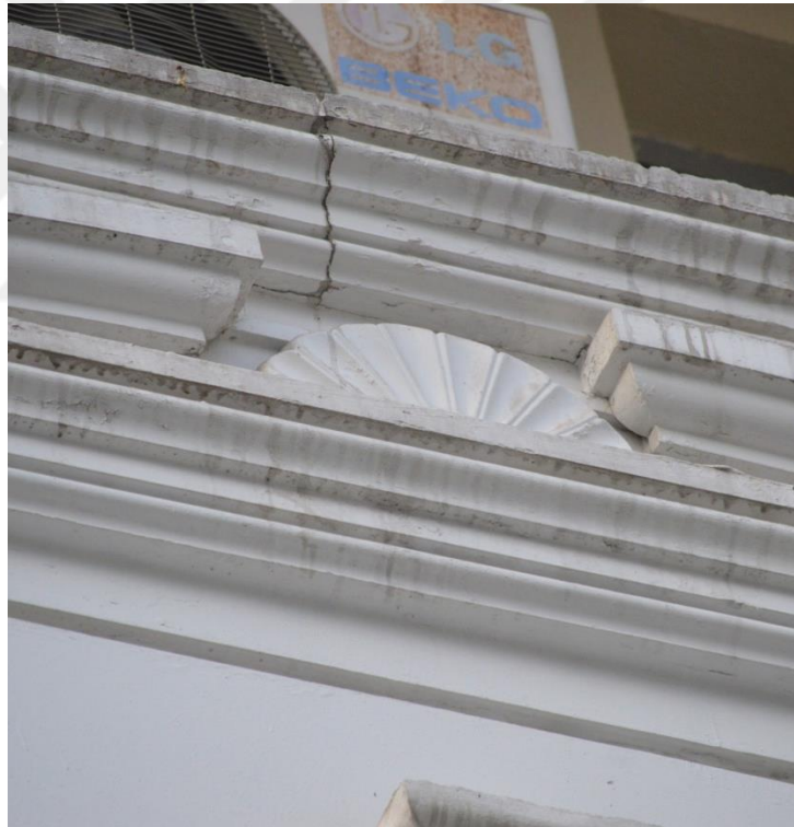
Fotoğraf 32: Eski Sağlık Müdürlüğü Binası 2, saçak kısmı.
