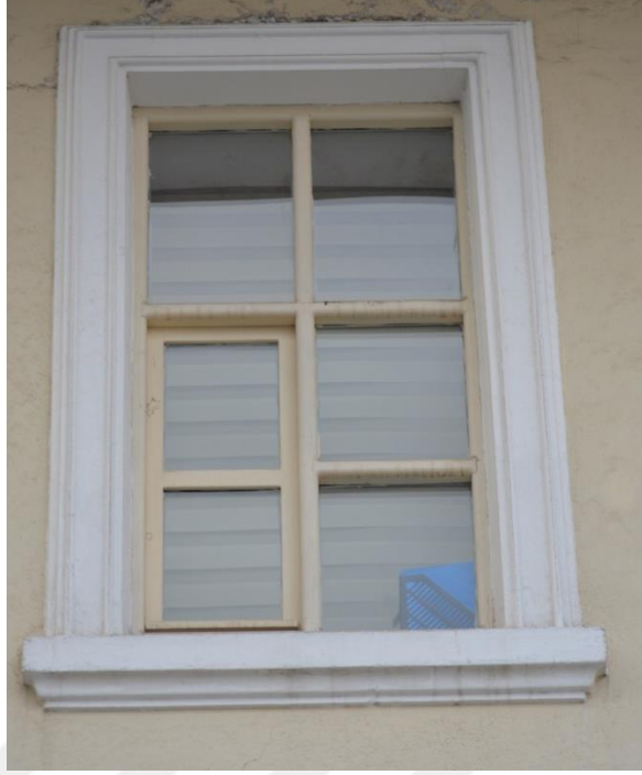
Fotoğraf 28: Kadastro Müdürlüğü Binası, pencere.
