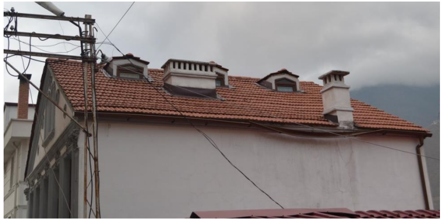
Fotoğraf 11: Eski Tekel İl Müdürlüğü Binası, çatı batıdan görünüş.
