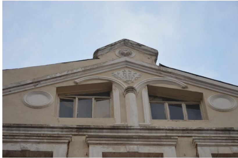
Fotoğraf 29: Kadastro Müdürlüğü Binası, çatı katı, güneyden görünüşü.
