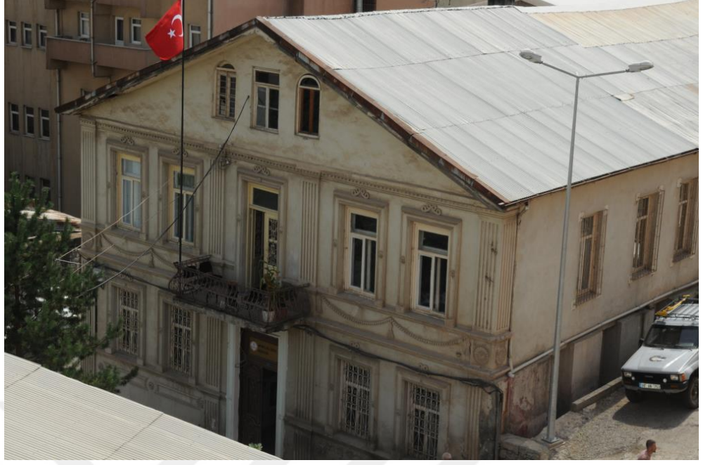
Fotoğraf 17: Eski Adliye Binası, kuzeyden görünüm (restorasyon öncesi hali) 67 .
