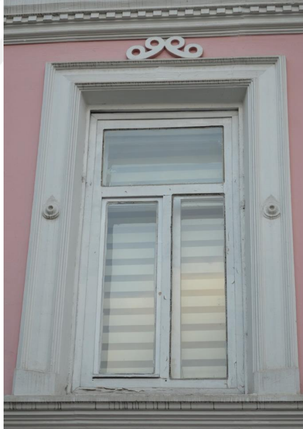
Fotoğraf 20: Eski Adliye Binası, pencere.
