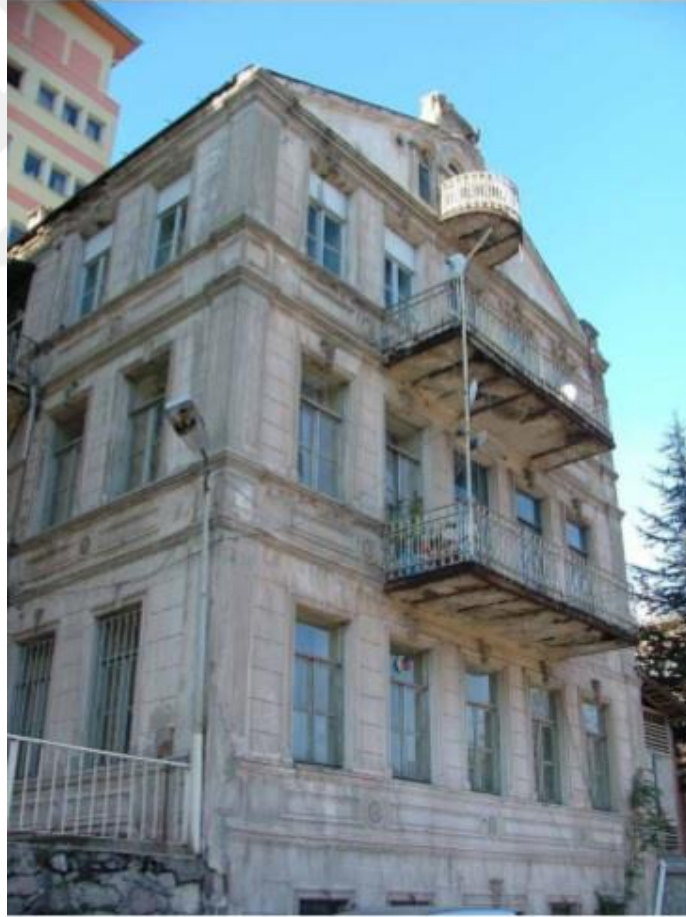
Fotoğraf 12: Eski Sağlık Müdürlüğü Binası, güneyden görünüm (restorasyon öncesi hali).
