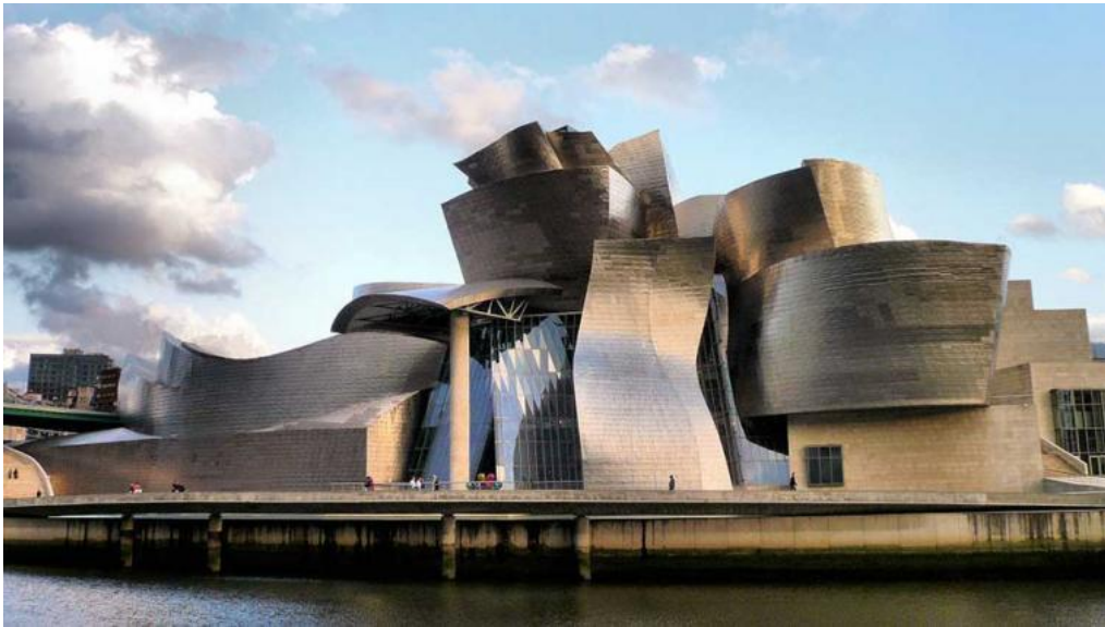
Resim 2.27. Guggenheim Müzesi (1997), mimar Frank Gehry, Bilbao, İspanya
