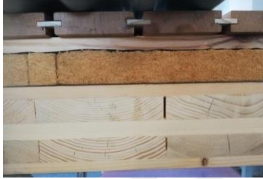
Şekil 4.2 : Tip2 çapraz tabakalı ahşap duvar detayı.
