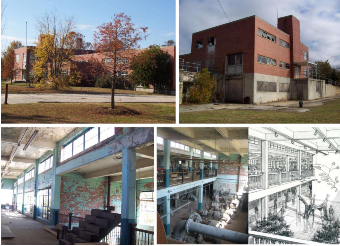
Şekil 3.49 Mevcut Su Filtreleme Tesisin dış-iç mekan görünümleri ve iç mekan galeri eskizi (Sanoff, Kişisel iletişim, 2013).
