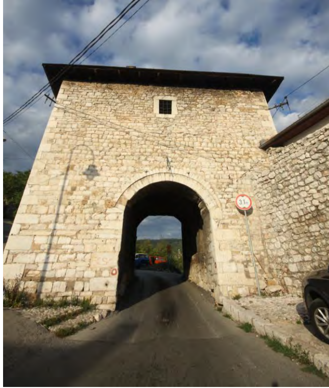
Resim 78. Višegrad Kapikulesi , Mevcut Durum (21.09.2013)
