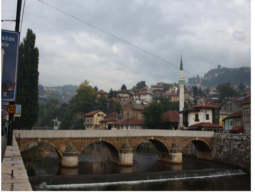
Resim 73. Şehit Çehaya Köprüsü, Genel Görünüm (08.10.2013)
