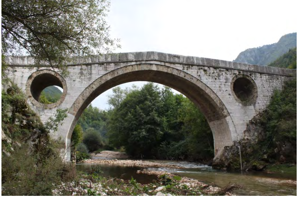
Resim 71. Keçi Köprüsü, Genel Görünüm (22.09.2013)
