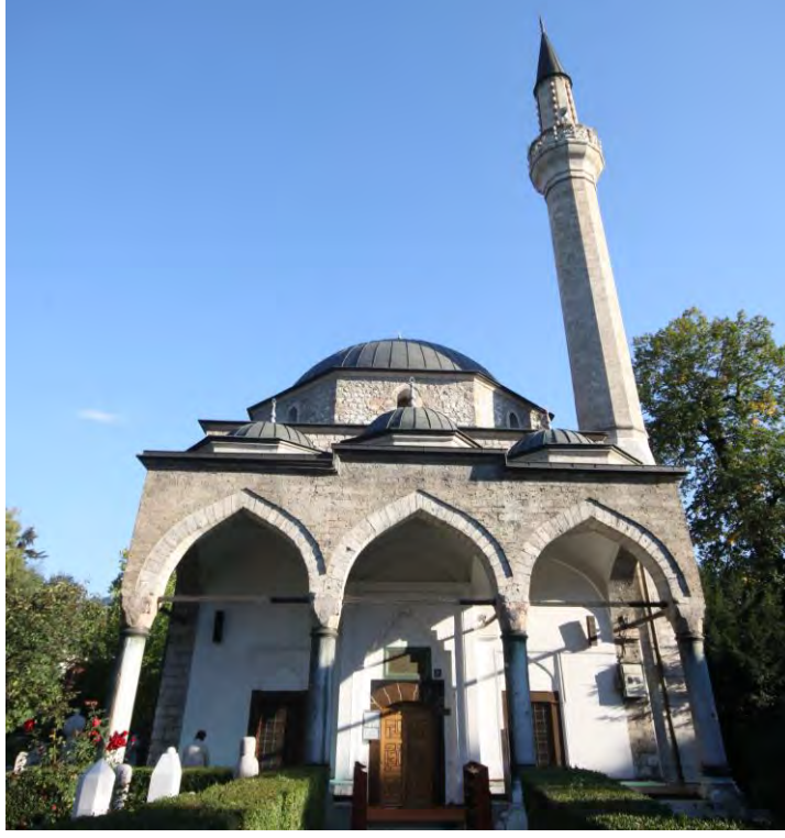
Resim 21. Hadım Ali Paşa Camii, Genel Görünüm (03.10.2013)
