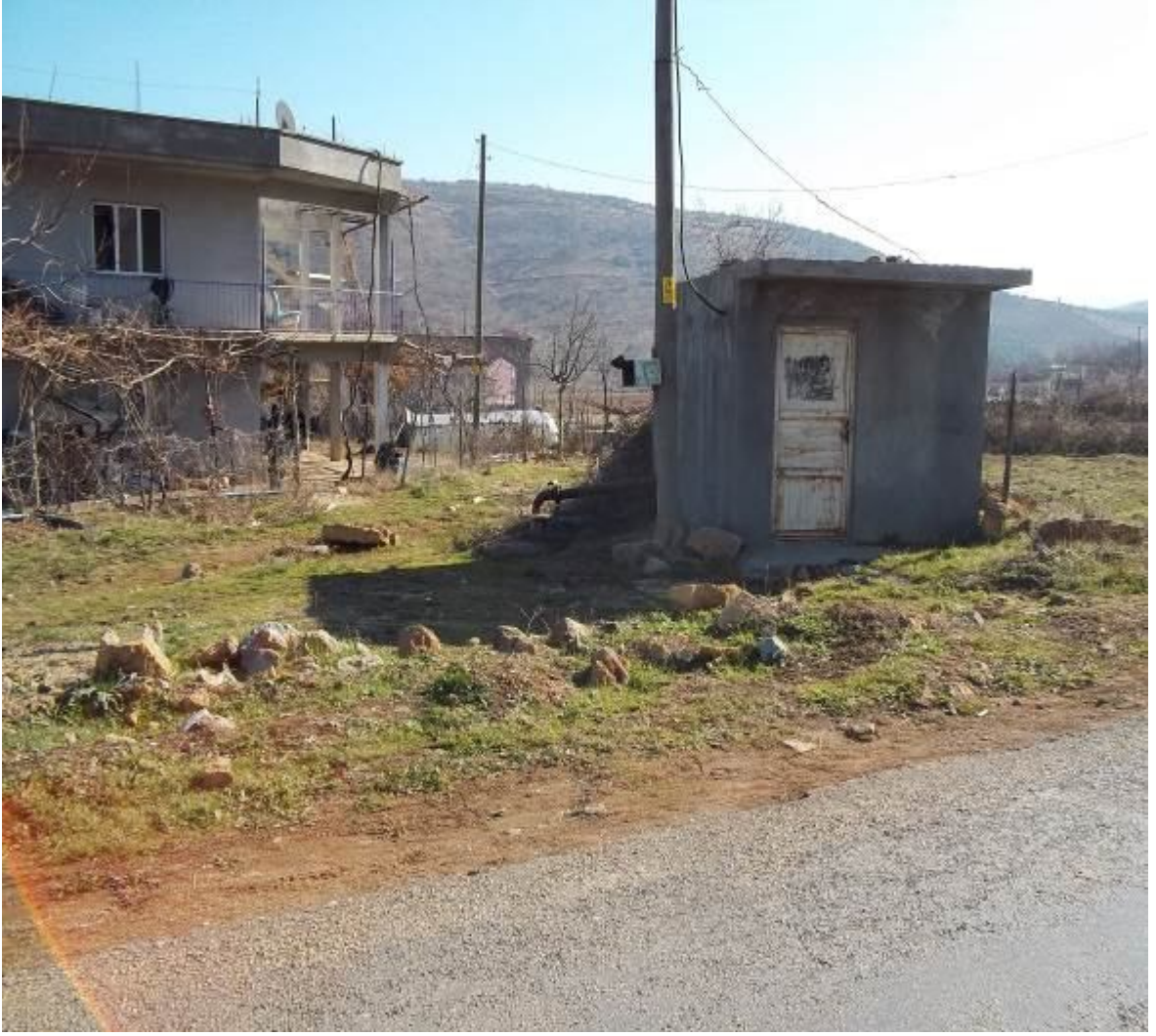
Şekil 2.1. Uzunsöğüt köyü içme suyu terfi binası (kuyu üzeri)
