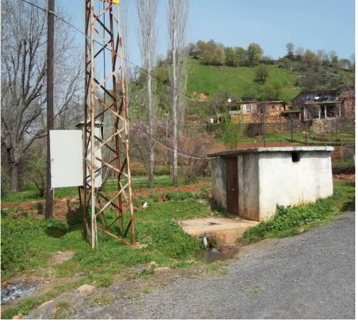
Şekil 2.6. Yavuzlar köyü içme suyu kaynağı (kırkgöz pınarı kaynağı)
