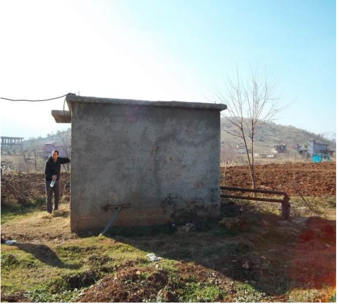
Şekil 2.2. Aydınkavak köyü içme suyu terfi binası (kuyu üzeri)
