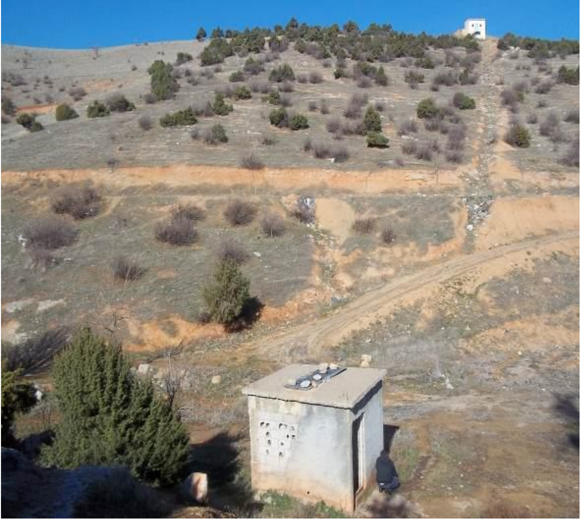
Şekil 2.5. Önsenhopuru köyü içme suyu terfi binası (kuyu üzeri)
