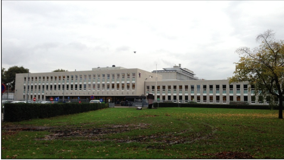
Şekil 5-24 Kral Willem II Koleji Ön Cepheden Görünüşü (2013)
