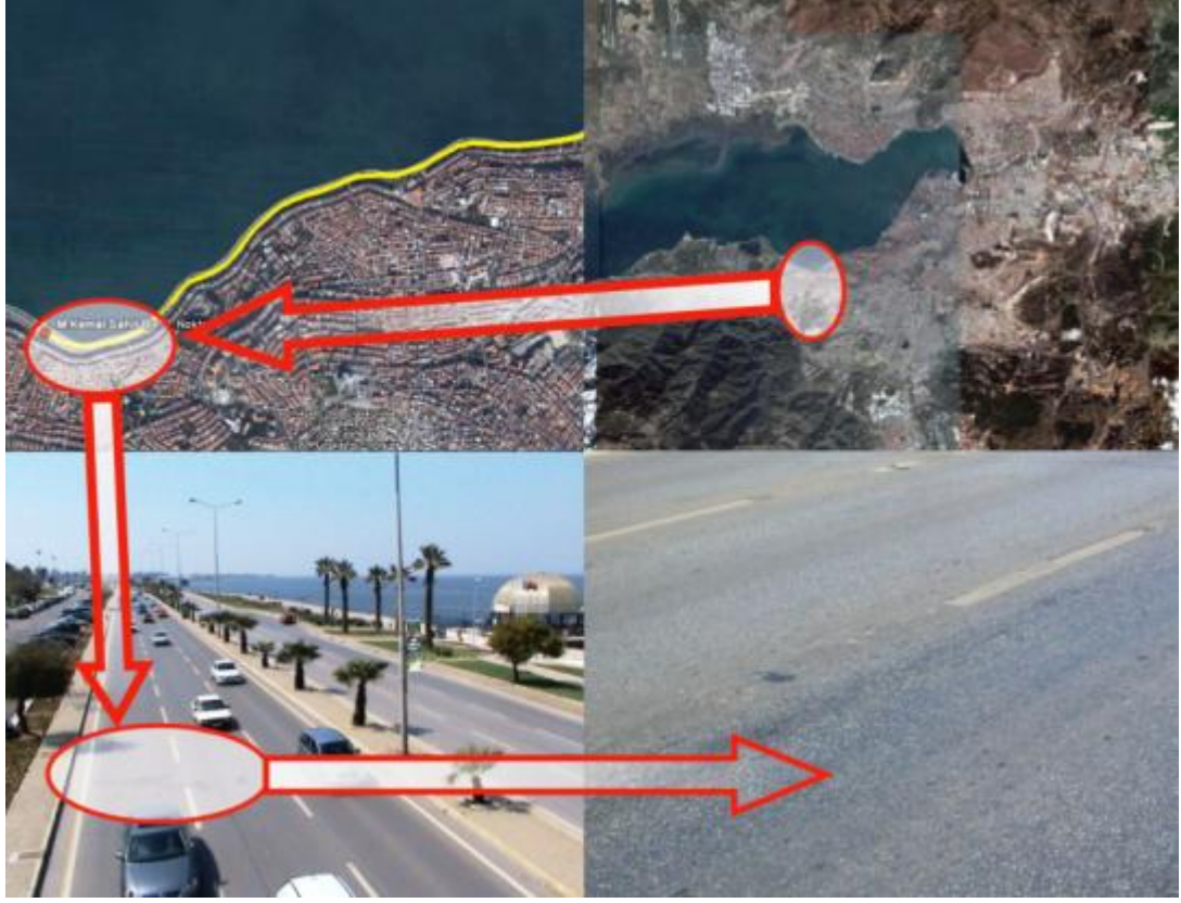
Şekil 4.9 M. Kemal Sahil Bulvarı, genel görünüm, ölçüm yapılan yer ve yol sathının durumu.
