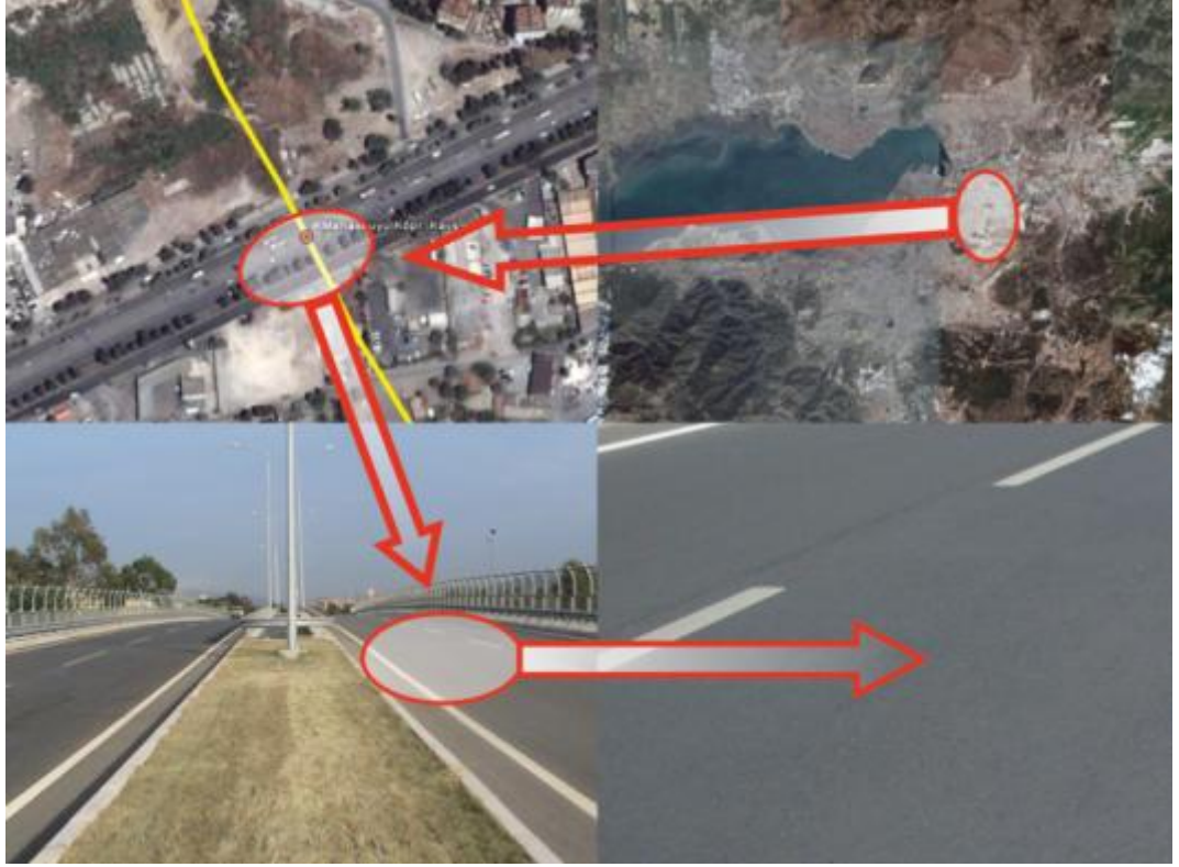
Şekil 4.12 Manavkuyu Köprülü Kavşak Bağlantısı, ölçüm yapılan yer ve yol sathının durumu
