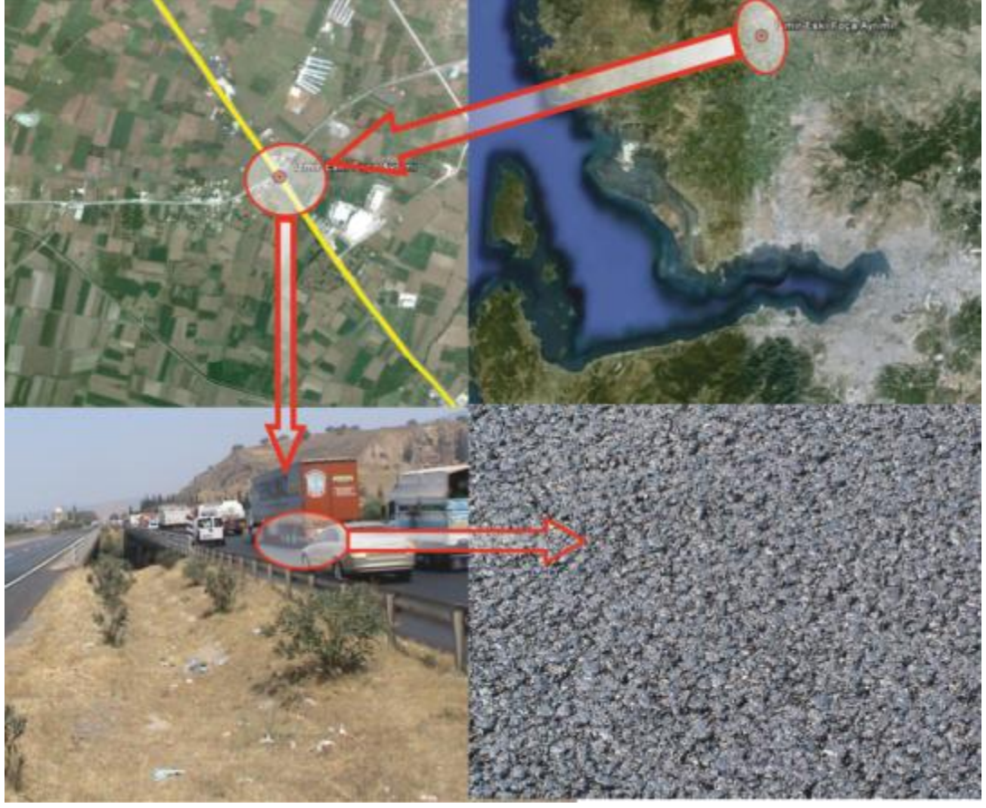
Şekil 4.5 İzmir-Eski Foça ayırımına ait genel görünüm ve yüzey yapısı
