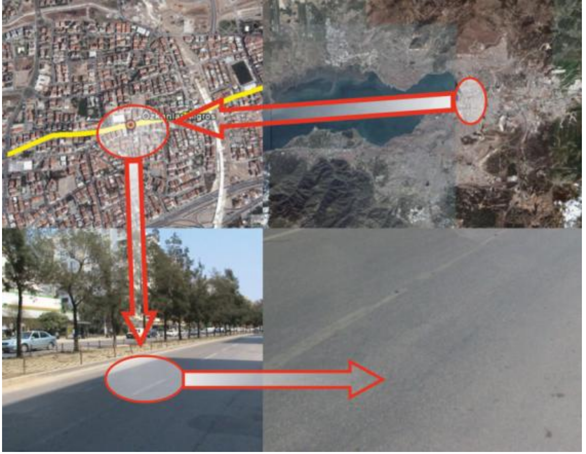
Şekil 4.11 Mustafa Kemal Caddesi (Özkanlar Migros önü ölçüm yapılan yer ve yol sathının durumu.
