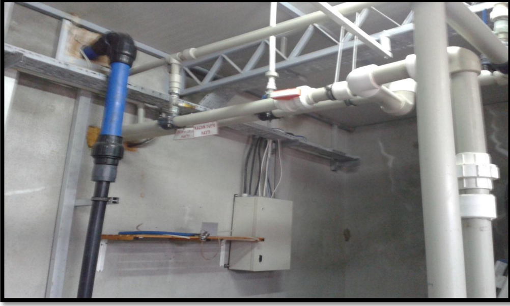
Şekil 2.26 Üretim hattı suyu, kazan hattı suyu ve besleme hattı suyu boru sistemleri.
