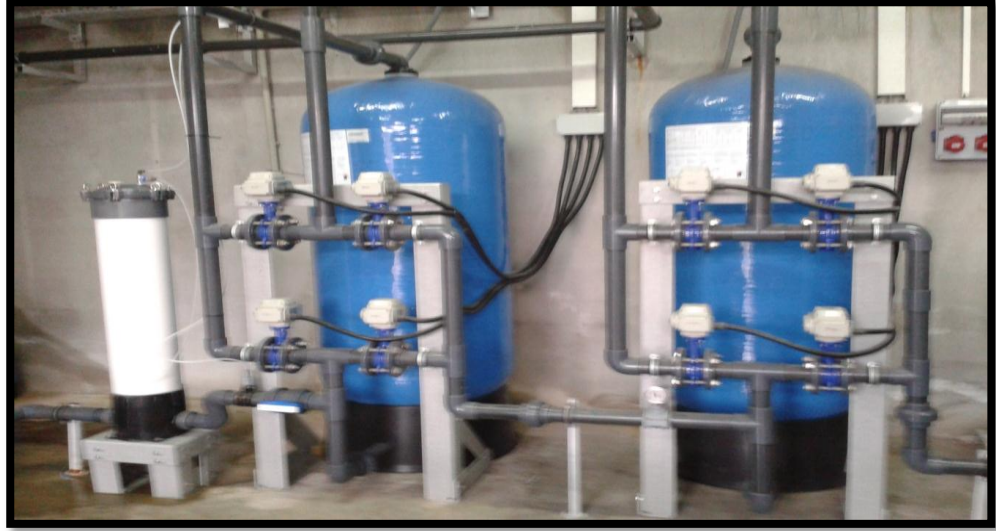
Şekil 2.23 Kum filtre, aktif karbon filtre ve kartuş filtre sistemleri.
