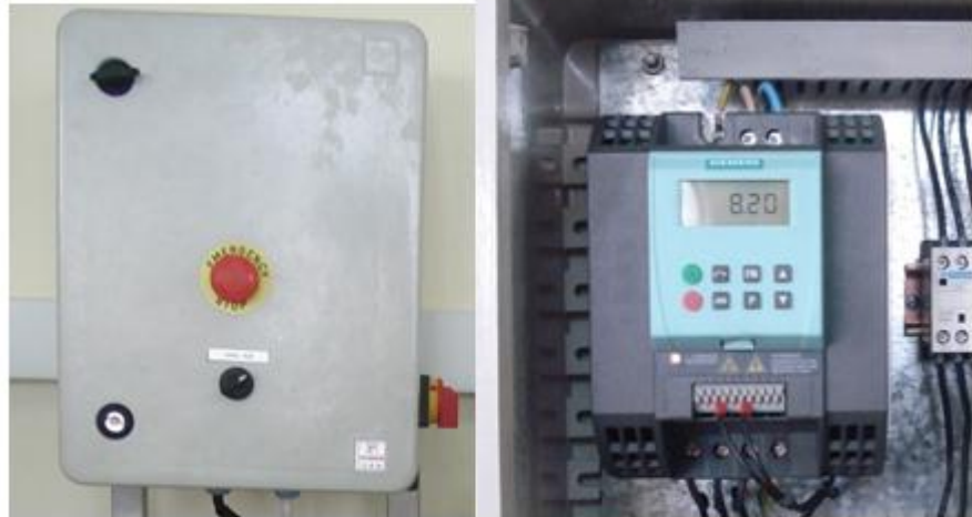
Şekil 2.9 Kontrol paneli ve frekans ayarlama sistemi.
